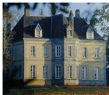
Elévation ouest Repro. Christel Douard IVR53_20032901431NUCA
