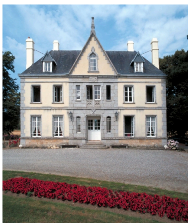
Elévation est du logis Phot. Bernard Bègne IVR53_20012900116XA
