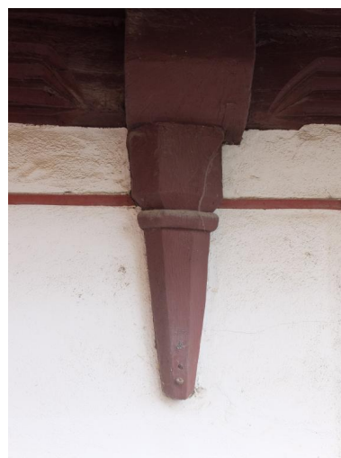
Détail de pigeatre soutenant une tête de solive chanfreinée Phot. ANTAK, Architectes du Patrimoine IVR53_20235605934NUCA
