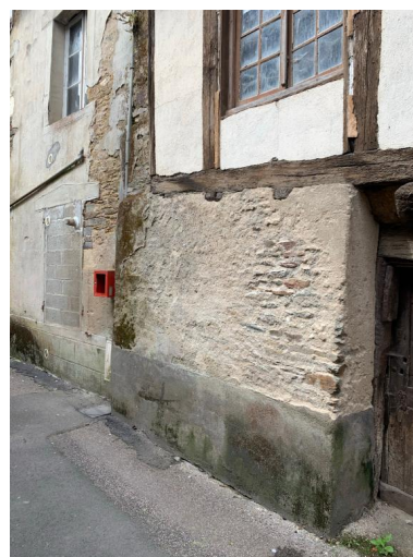
Maison à gauche. Partie sud du rez-de-chaussée Phot. ANTAK, Architectes du Patrimoine IVR53_20235605947NUCA
