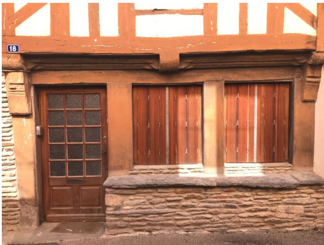
Maison à droite. Rez-de-chaussée
