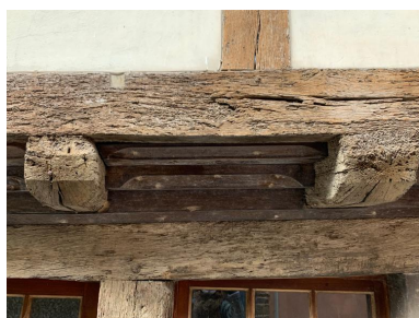
Détail des têtes de solives et d'entretoise Phot. ANTAK, Architectes du Patrimoine IVR53_20235605948NUCA
