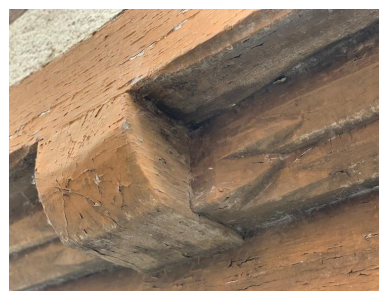
Maison à droite. Détail de tête de solive et d'entretoise Phot. ANTAK, Architectes du Patrimoine IVR53_20235605944NUCA
