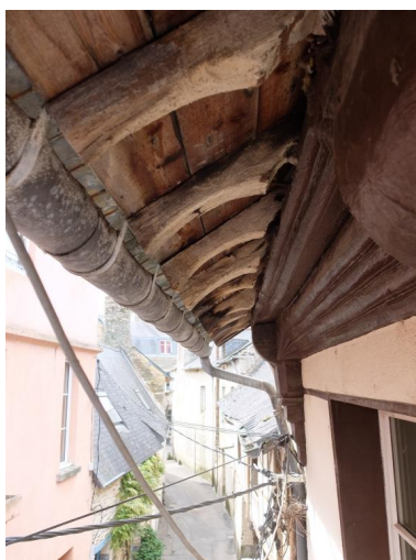
Détail des chevrons débordants sur sablière apparente posée sur têtes de solives Phot. ANTAK, Architectes du Patrimoine IVR53_20235605933NUCA
