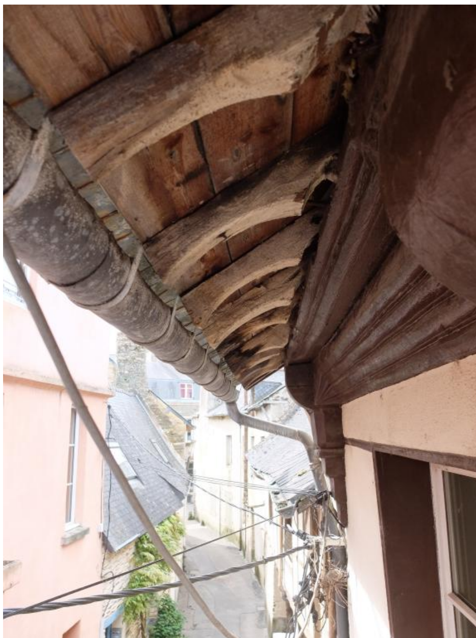
Détail des chevrons débordants sur sablière apparente posée sur têtes de solives
