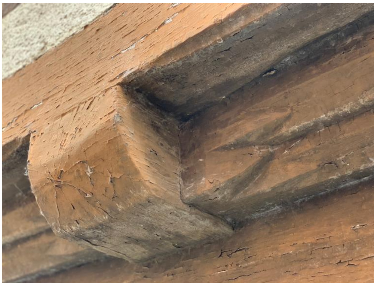
Maison à droite. Détail de tête de solive et d'entretoise
