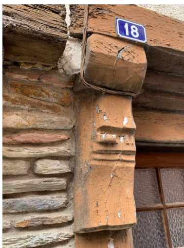
Maison à droite. Détail de console Phot. ANTAK, Architectes du Patrimoine IVR53_20235605950NUCA
