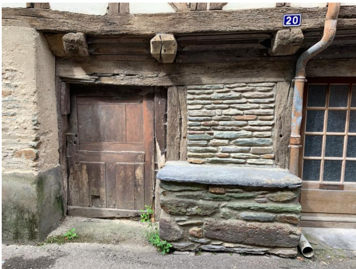
Maison à gauche. Rez-de-chaussée
