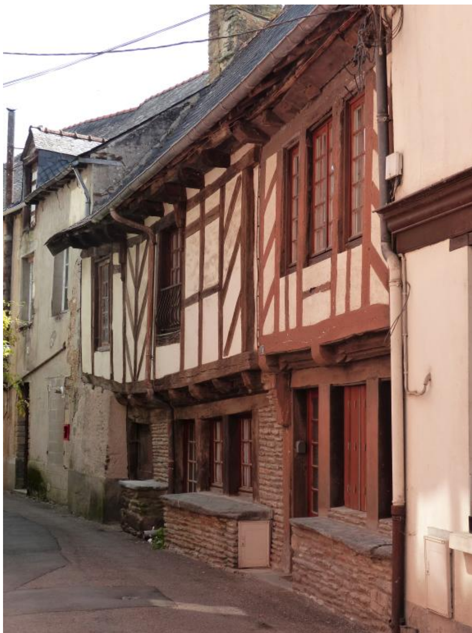
Vue générale de l'alignement des deux maisons
