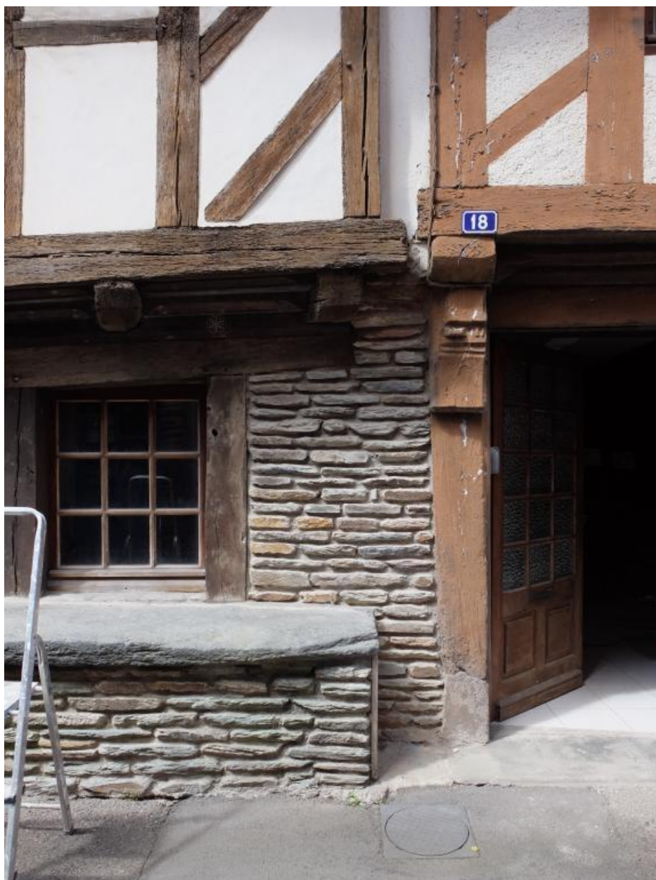
Alignement des maisons. Rez-de-chaussée
