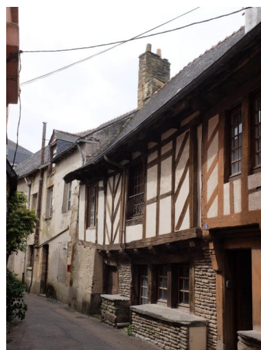
Vue générale de la maison à gauche
