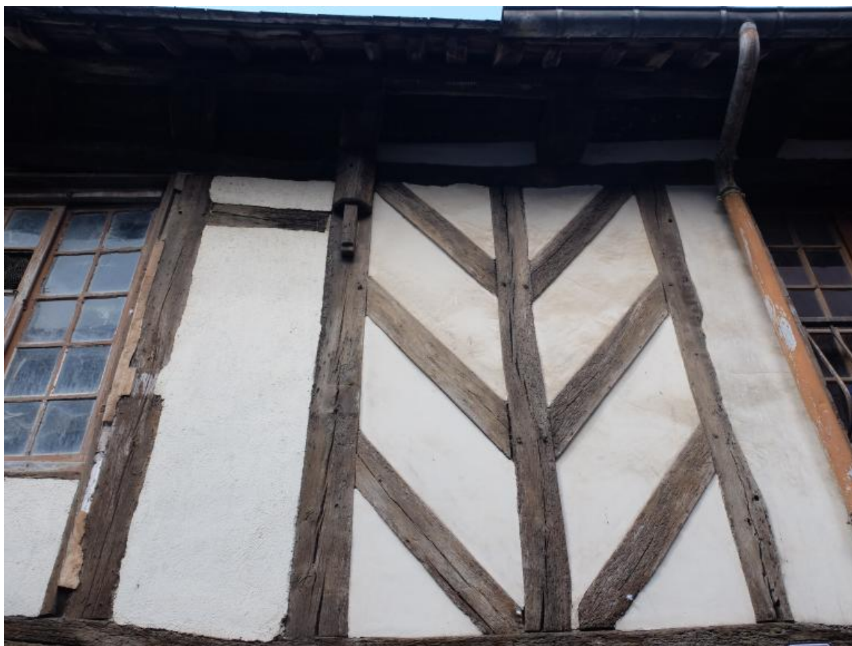
Maison à gauche. Détails du premier étage en pan de bois
