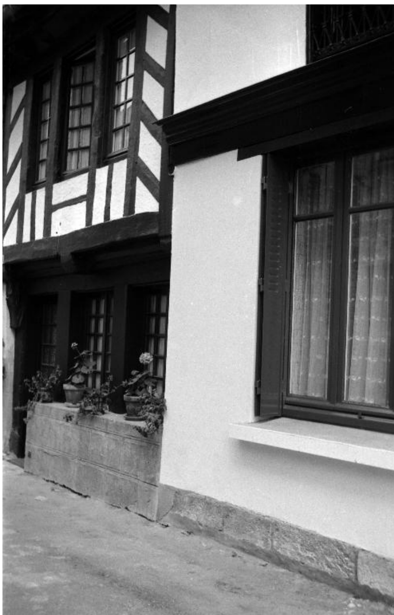
Vue prise du nord-ouest (état en 1969)
