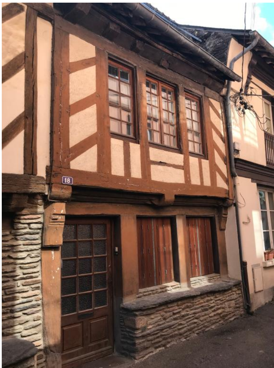
Maison à droite. Vue générale
