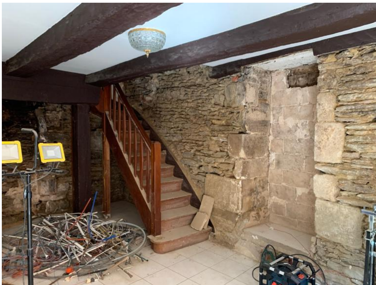
Maison à droite. Rez-de-chaussée
