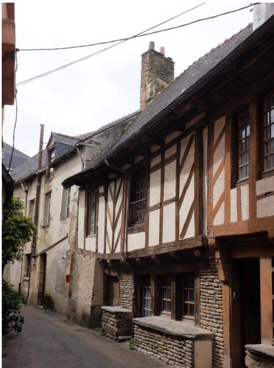
Vue générale de la maison à gauche
