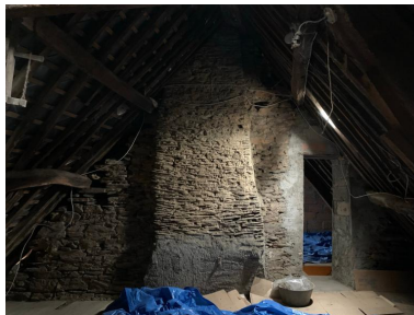
Combles avec cheminée Phot. ANTAK, Architectes du Patrimoine IVR53_20235605955NUCA
