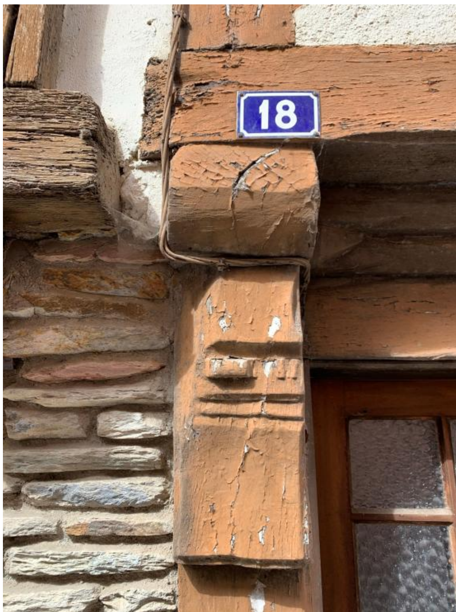
Maison à droite. Détail de console
