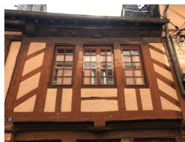
Maison à droite. Premier étage en pan de bois Phot. ANTAK, Architectes du Patrimoine IVR53_20235605941NUCA
