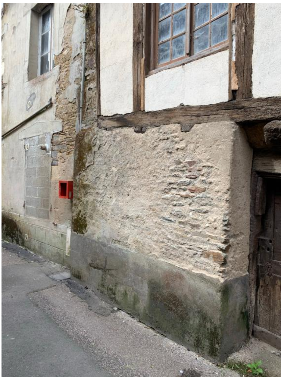
Maison à gauche. Partie sud du rez-de-chaussée
