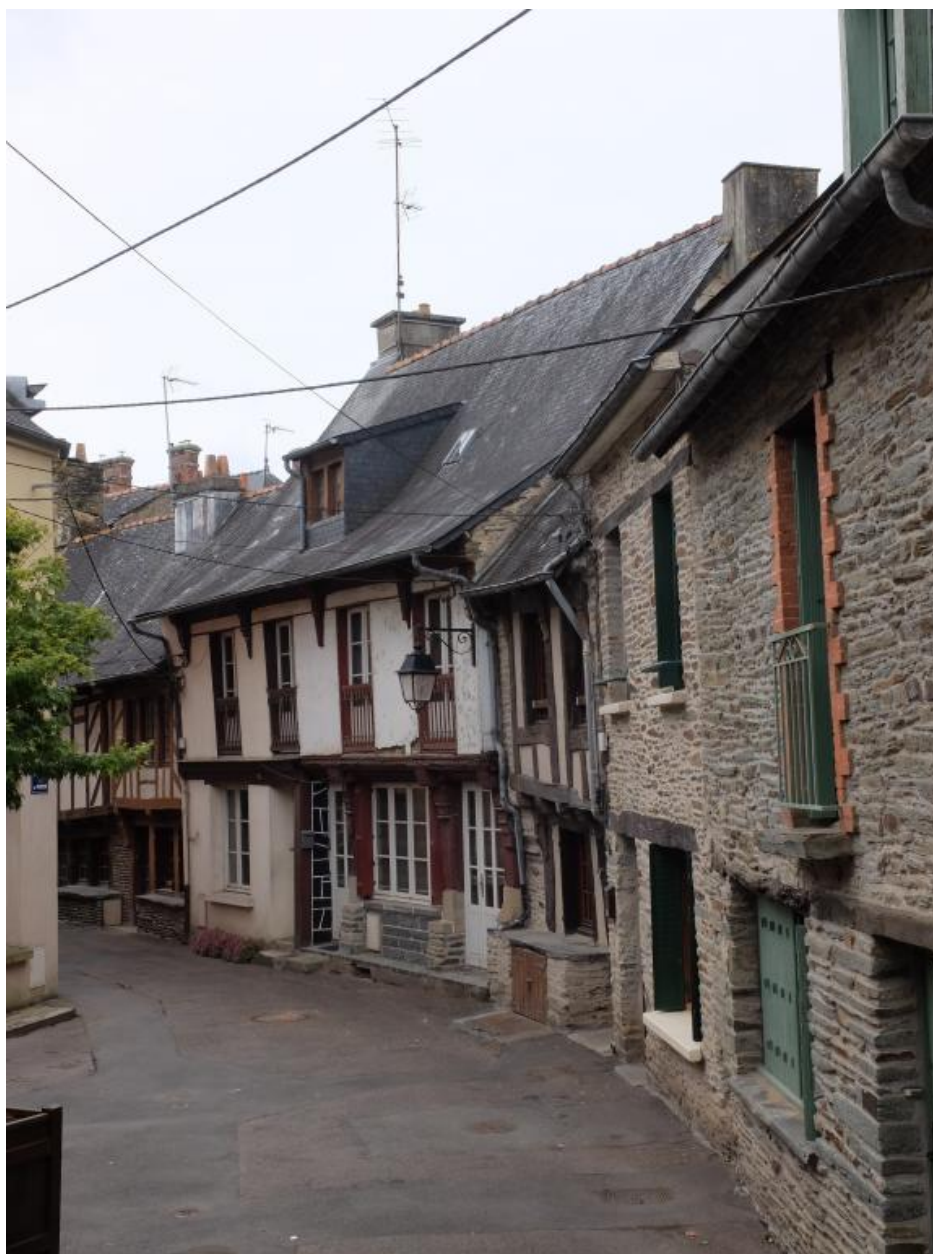
Vue de situation dans la rue aux Anglais vers le sud
