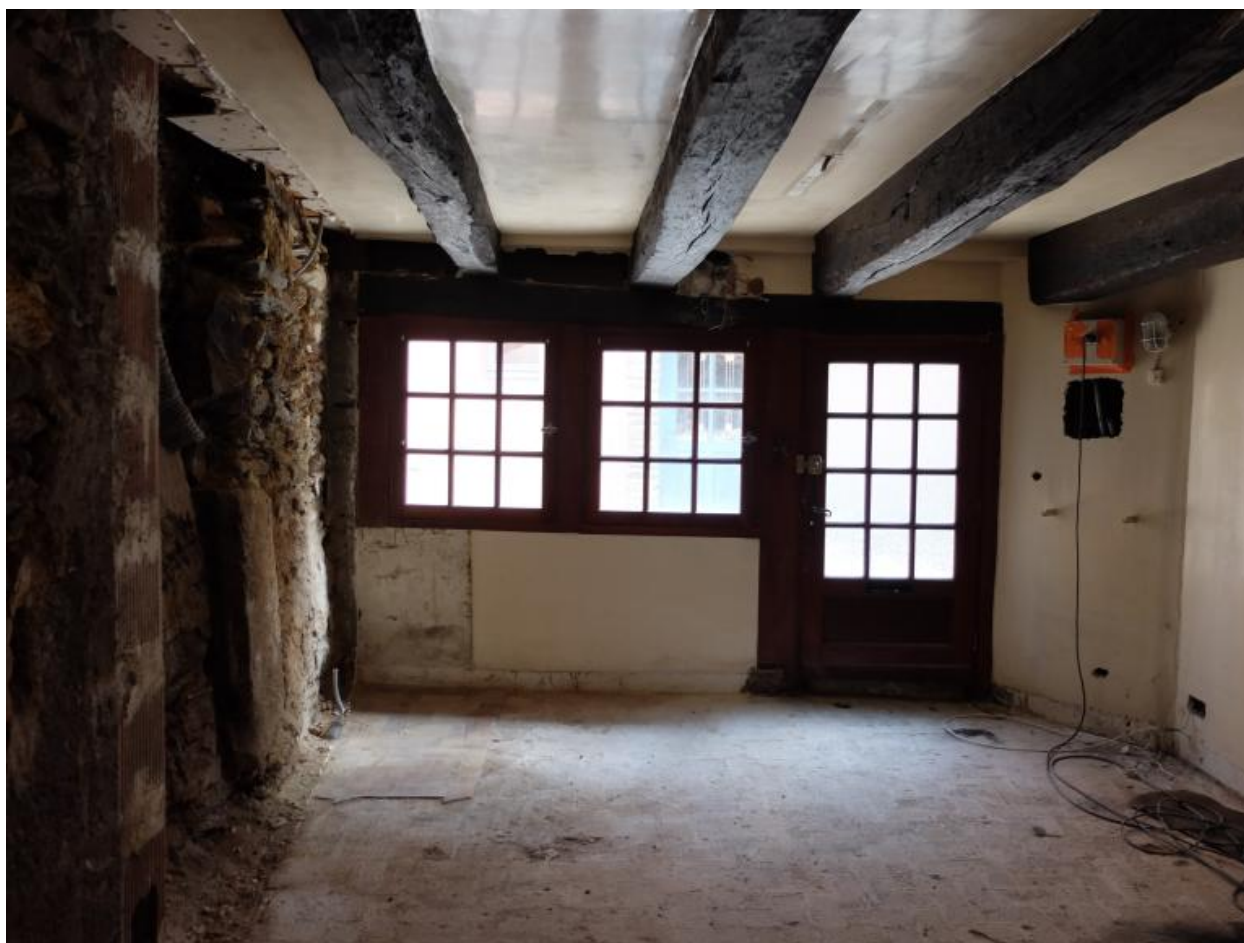
Maison à gauche. Rez-de-chaussée
