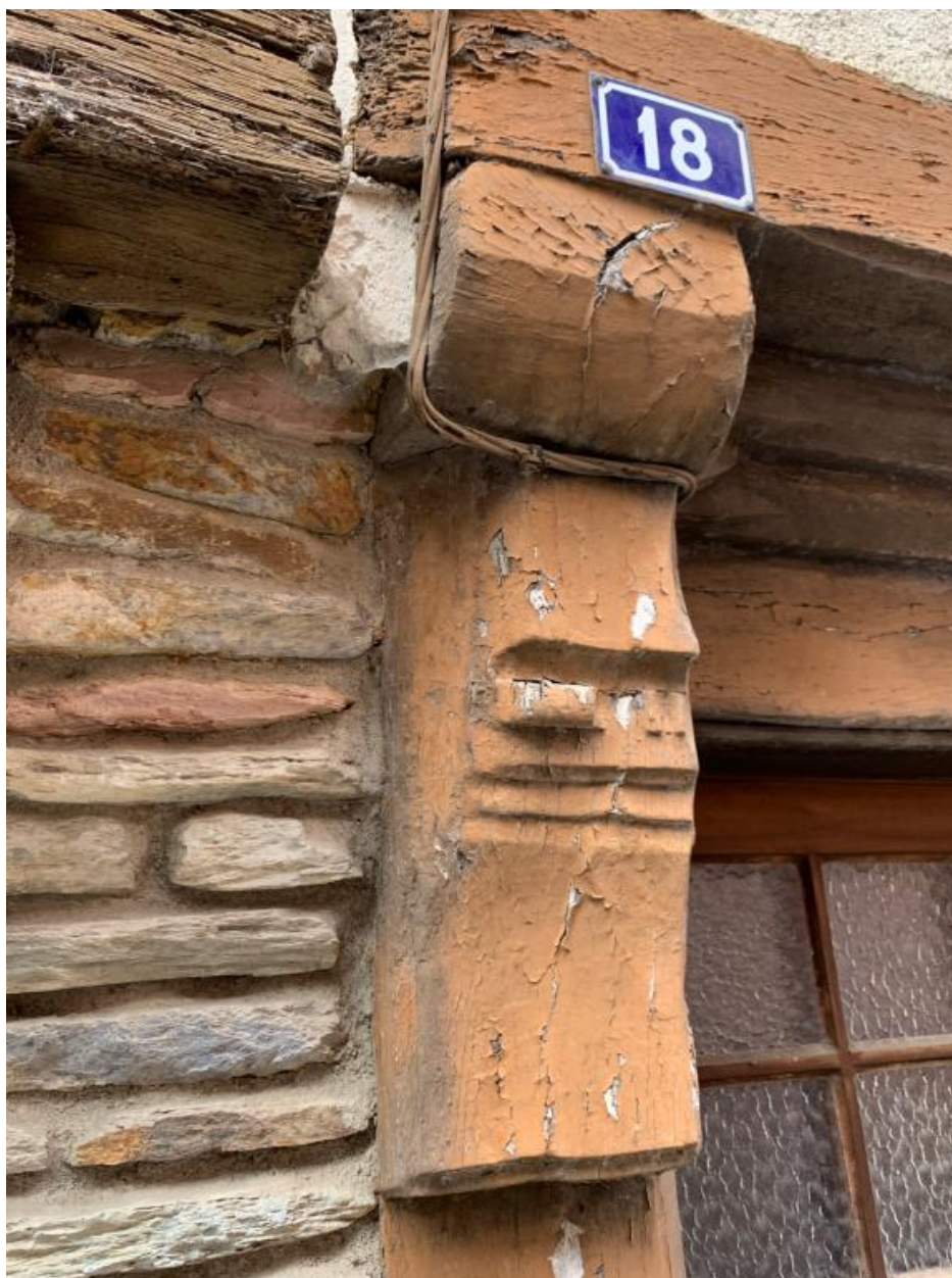
Maison à droite. Détail de console
