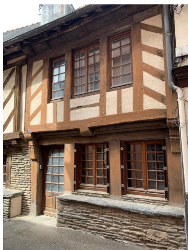
Vue générale de la maison à droite Phot. ANTAK, Architectes du Patrimoine IVR53_20235605951NUCA
