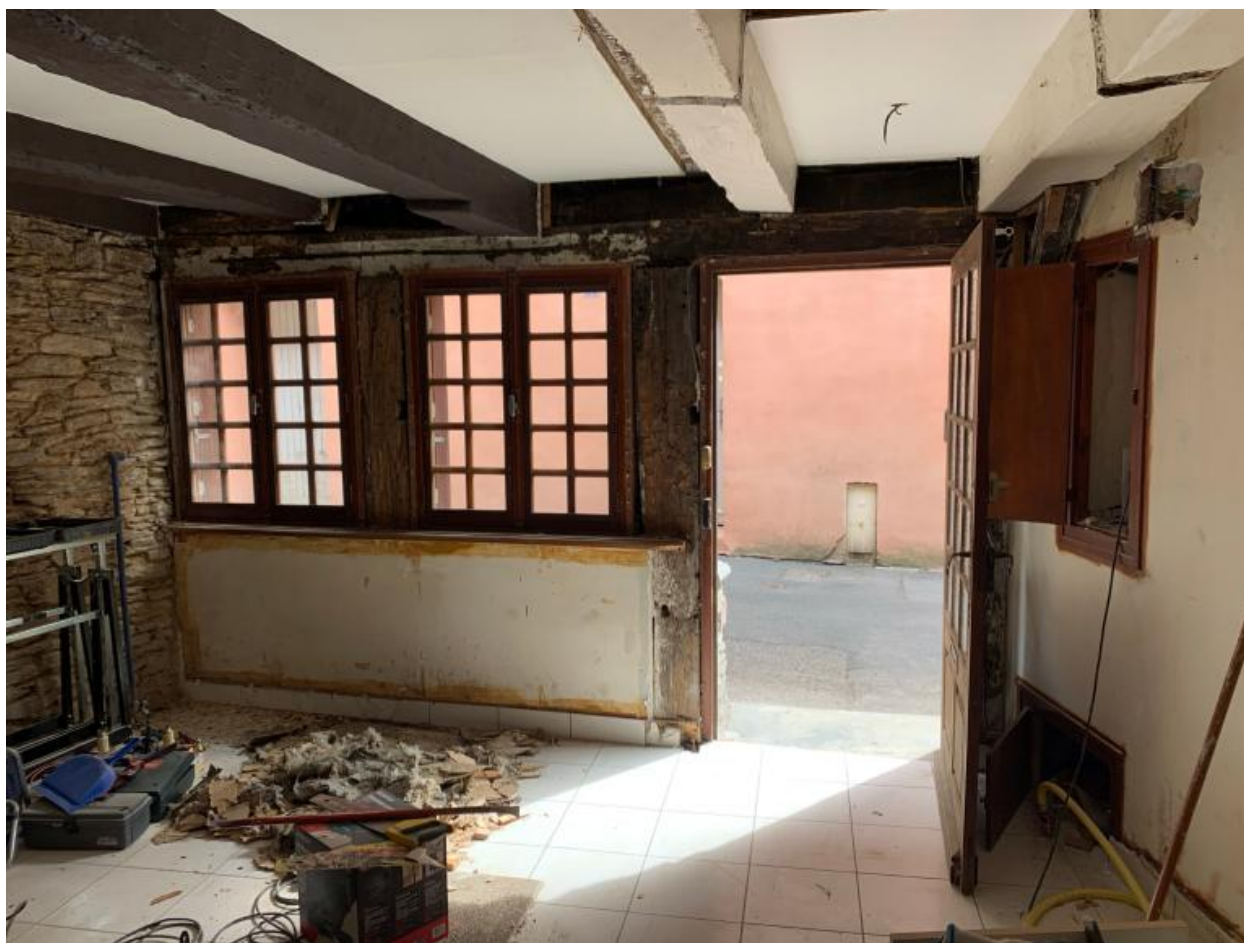
Maison à droite. Rez-de-chaussée
