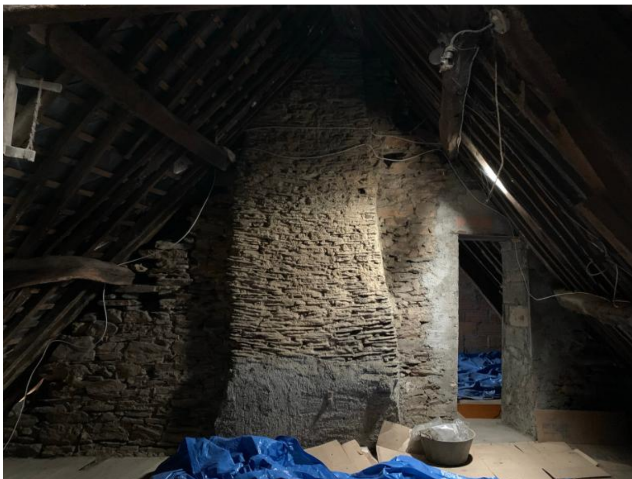
Combles avec cheminée
