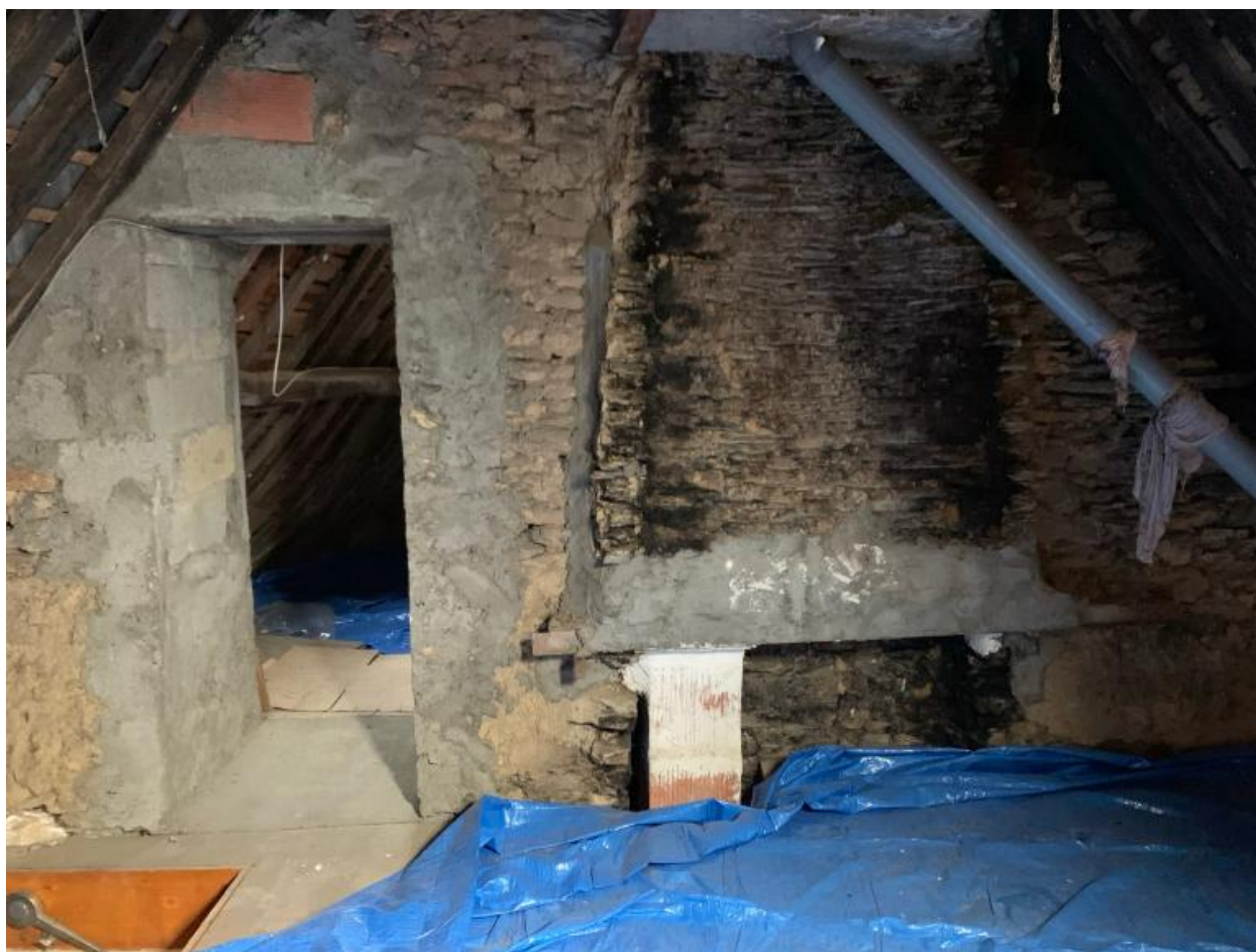
Combles avec cheminée
