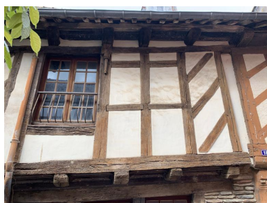
Maison à gauche. Détails du premier étage en pan de bois Phot. ANTAK, Architectes du Patrimoine IVR53_20235605945NUCA
