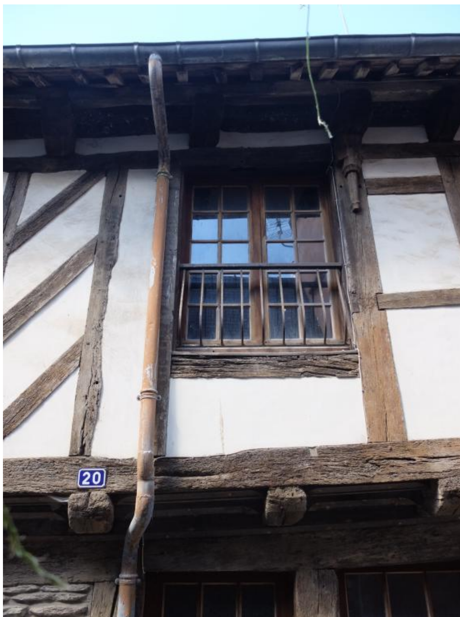
Maison à gauche. Détails du premier étage en pan de bois
