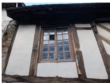
Maison à gauche. Détails du premier étage en pan de bois Phot. ANTAK, Architectes du Patrimoine IVR53_20235605929NUCA
