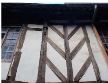
Maison à gauche. Détails du premier étage en pan de bois Phot. ANTAK, Architectes du Patrimoine IVR53_20235605930NUCA
