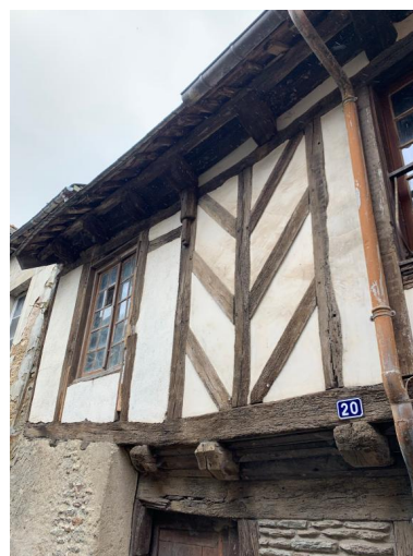
Maison à gauche. Premier étage en pan de bois Phot. ANTAK, Architectes du Patrimoine IVR53_20235605956NUCA
