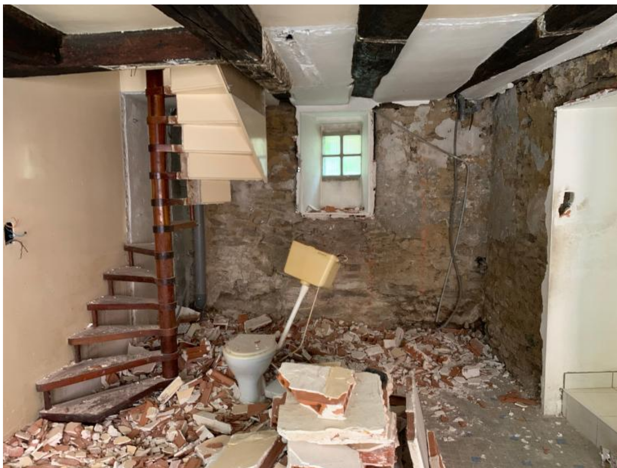
Maison à gauche. Rez-de-chaussée
