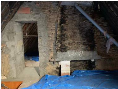
Combles avec cheminée Phot. ANTAK, Architectes du Patrimoine IVR53_20235605953NUCA
