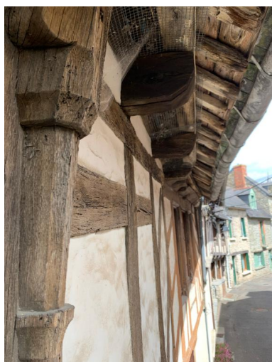
Détail d'un pigeatre Phot. ANTAK, Architectes du Patrimoine IVR53_20235605954NUCA
