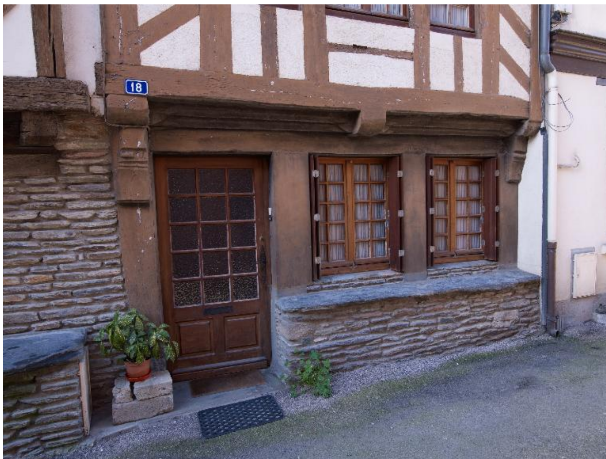
Rez-de-chaussée (état en 2012)
