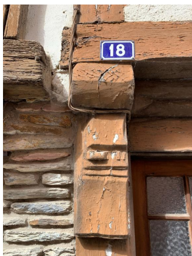
Maison à droite. Détail de console Phot. ANTAK, Architectes du Patrimoine IVR53_20235605943NUCA
