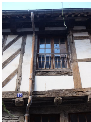
Maison à gauche. Détails du premier étage en pan de bois Phot. ANTAK, Architectes du Patrimoine IVR53_20235605931NUCA
