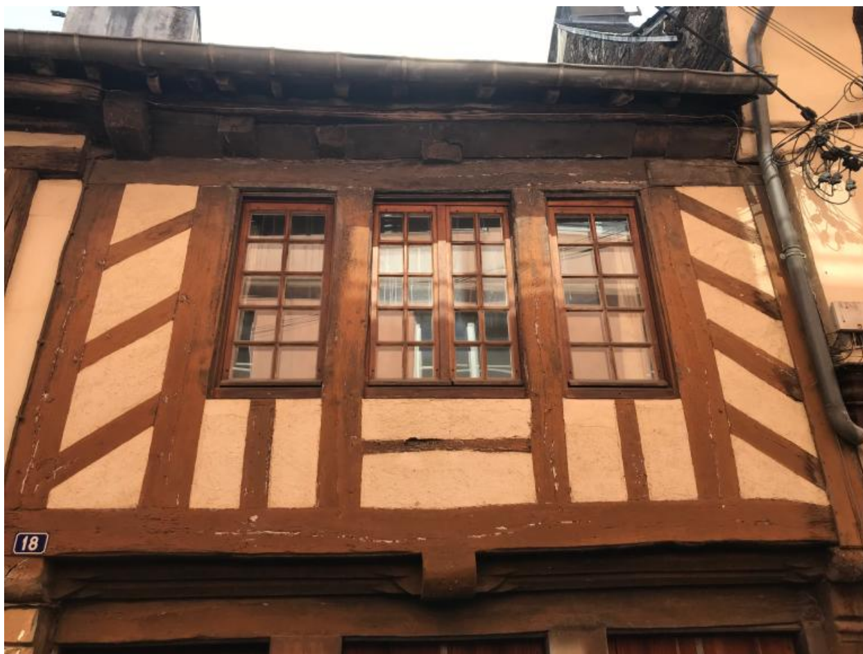
Maison à droite. Premier étage en pan de bois
