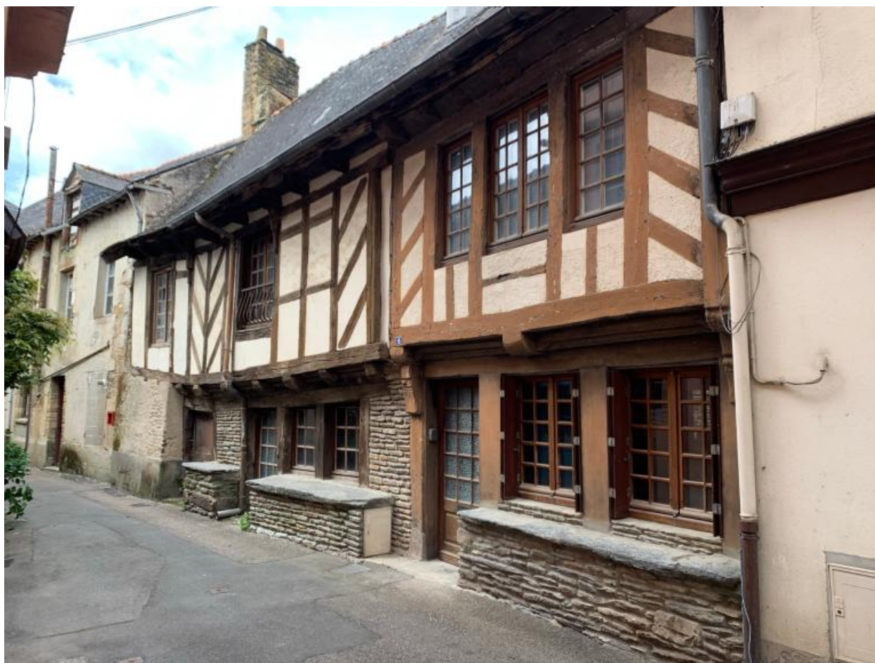
Vue générale de l'alignement des deux maisons
