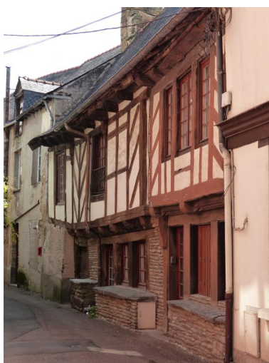
Vue générale de l'alignement des deux maisons
