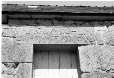
Façade sud est : détail de l'inscription Phot. Brulon IVR53_19662200510Z
