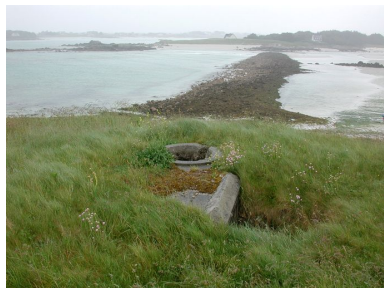
Vue générale (état en 2003). En arrière-plan, les vestiges de l'ancienne digue du Curnic Phot. Guillaume Lécuillier IVR53_20032902528NUCA
