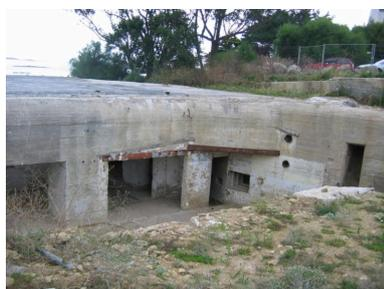
Vue du chantier de transformation du bunker en maison d'habitation : les nouvelles ouvertures ont été sciées avec un câble diamant dans les murs de 2 m d'épaisseur, août 2008 (photographie d'Atlantikwall Superforum, La Taupe)
