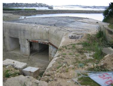
Vue du chantier de transformation du bunker en maison d'habitation : les nouvelles ouvertures ont été sciées avec un câble diamant dans les murs de 2 m d'épaisseur, août 2008 (photographie d'Atlantikwall Superforum, La Taupe)
