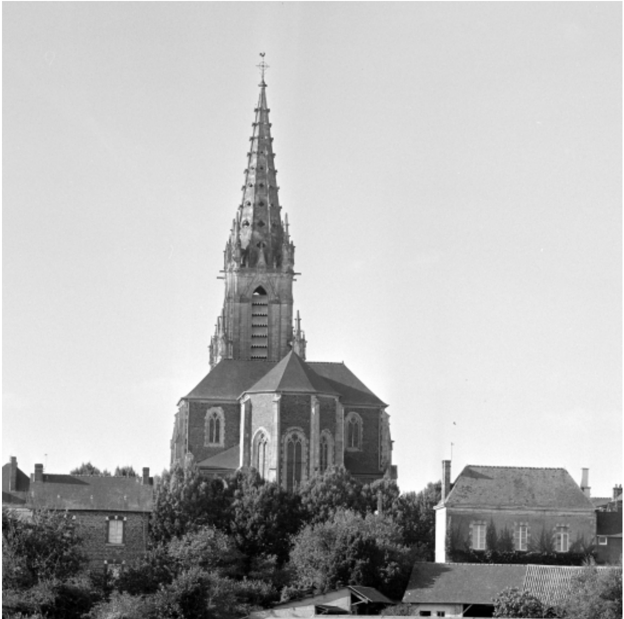
Elévation Est : vue générale (état en 1994).
