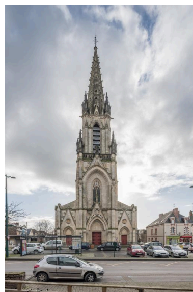
Vue générale nord-ouest Phot. Charlotte Barraud IVR53_2018350005NUCA
