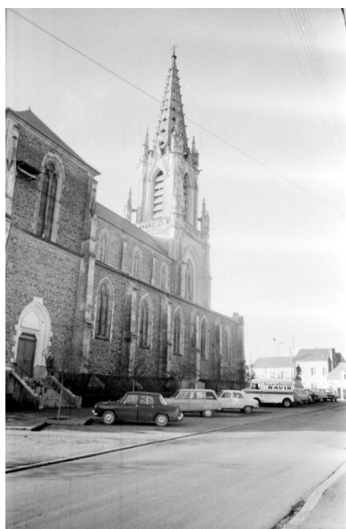
Elévation nord (état en 1973). Phot. Liliane Auberge IVR53_19733505522Z
