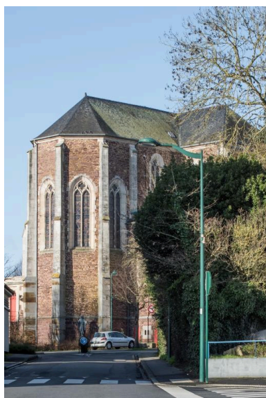
Vue du chevet Phot. Charlotte Barraud IVR53_2018350003NUCA
