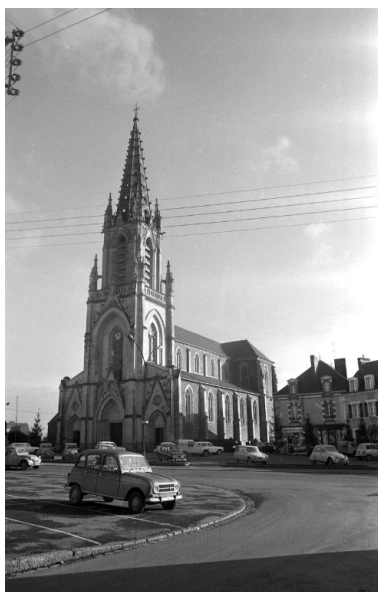
Vue générale (état en 1973). Phot. Liliane Auberge IVR53_19733505514Z
