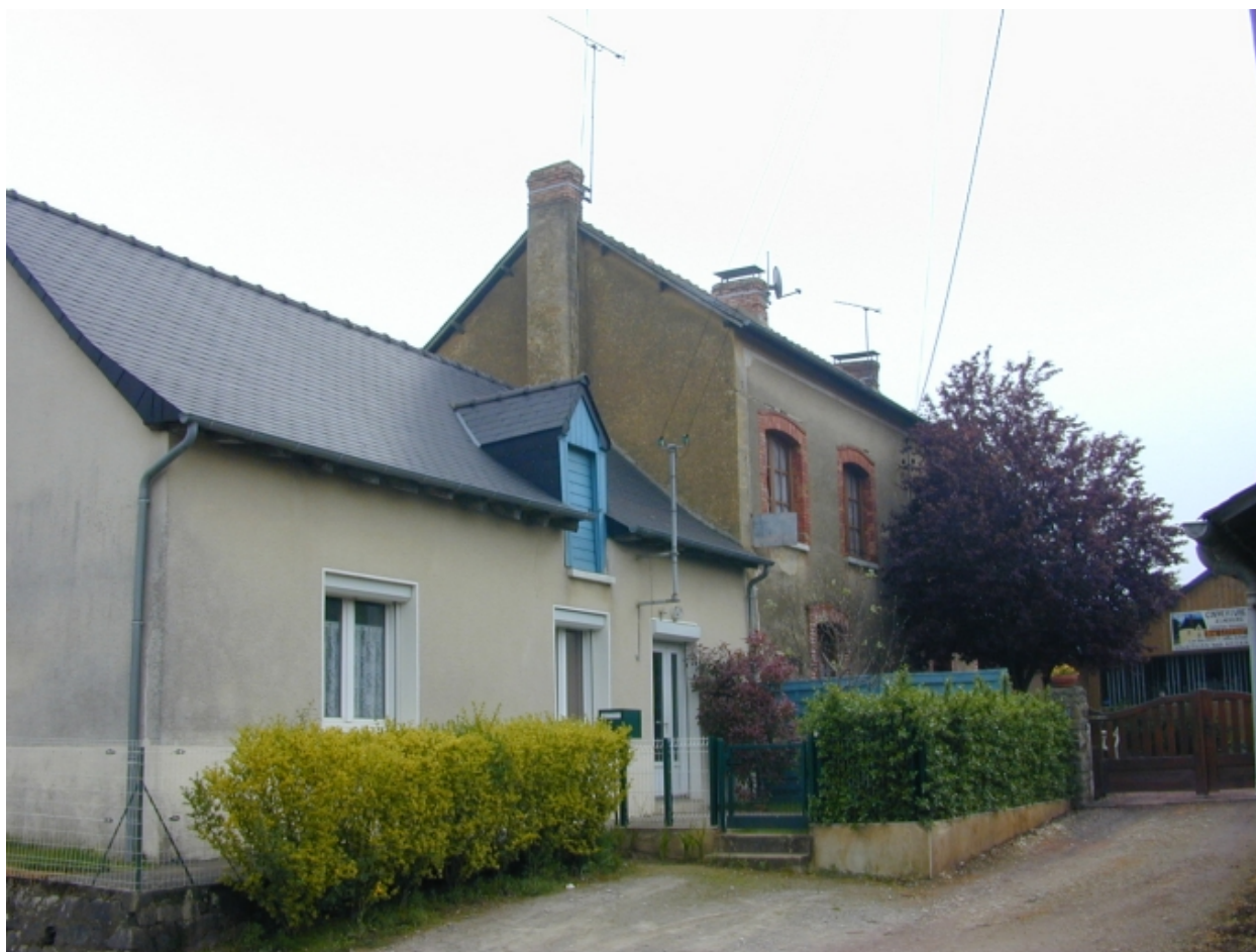
Maison au second plan sur l'image : vue générale ouest
