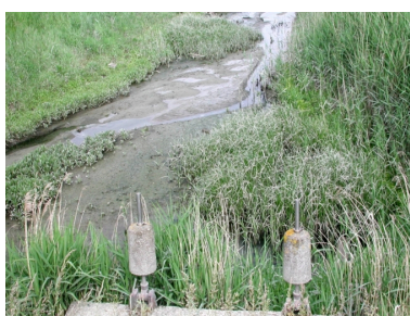
Double porte à marée du ruisseau La Corderie (rivière d'Yffiniac) Phot. Guy Prigent IVR53_20032204162NUCA
