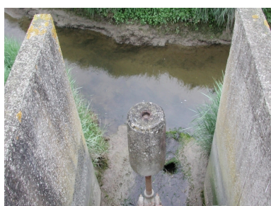
Ecluse : porte à marée du saint- Jean avec son contre-poids Phot. Guy Prigent IVR53_20032204167NUCA
