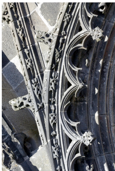
Détail du gâble du portail sud Phot. Alain Dagorn
