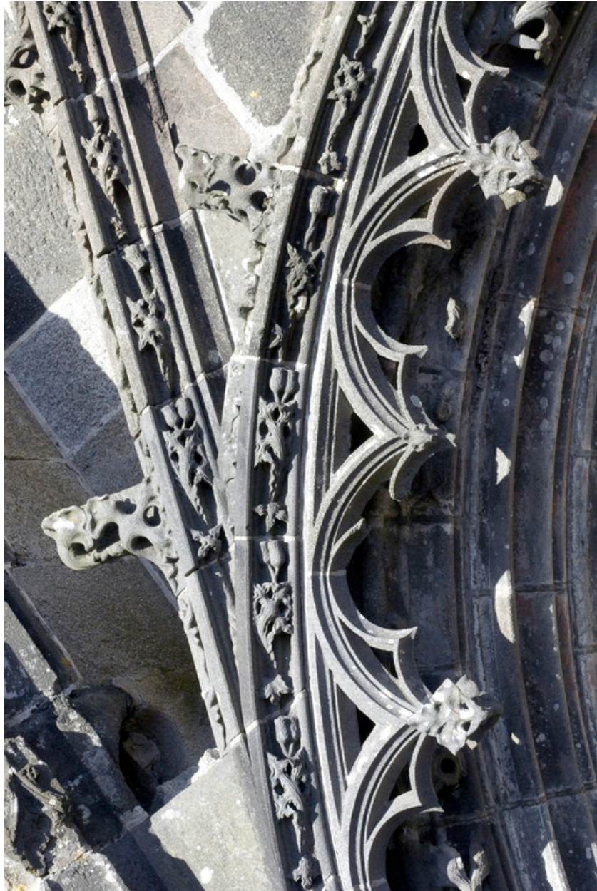
Détail du gâble du portail sud
