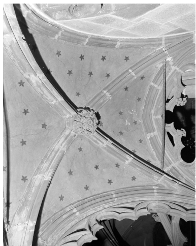
Jubé, détail du voûtement Phot. François Dagorn IVR53_19742900358X
