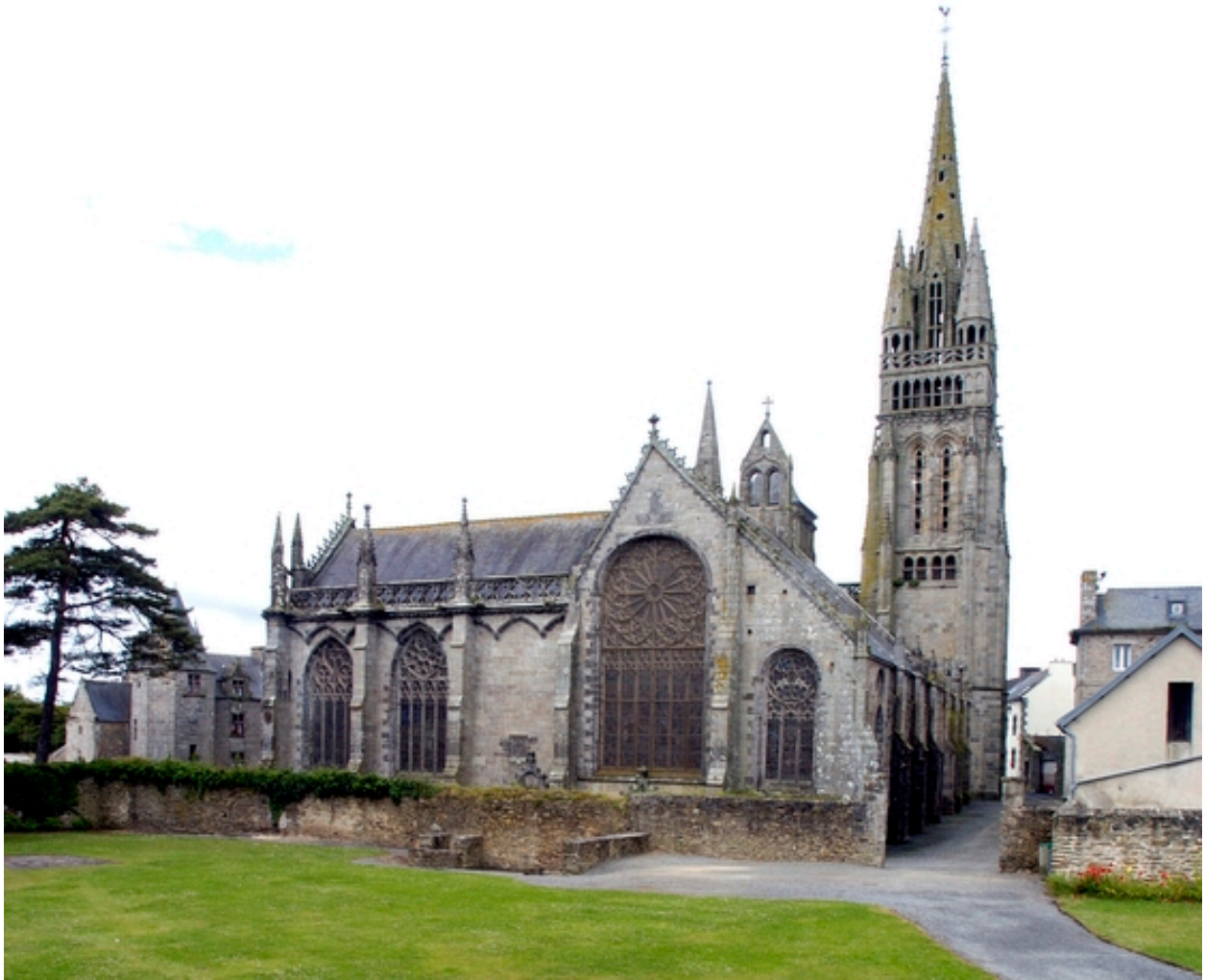
Vue générale prise de l'est
