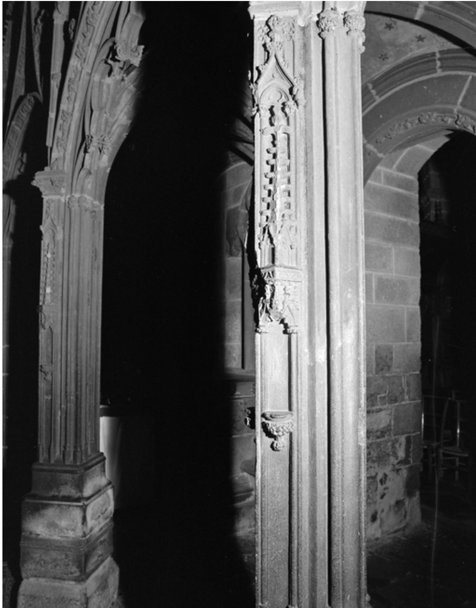
Jubé, détail de niche sur poteaux
