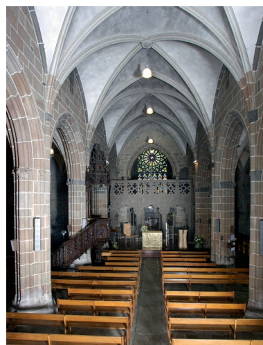
Vue axiale de la nef vers le chœur Phot. Alain Dagorn IVR53_20082900209NUCA
