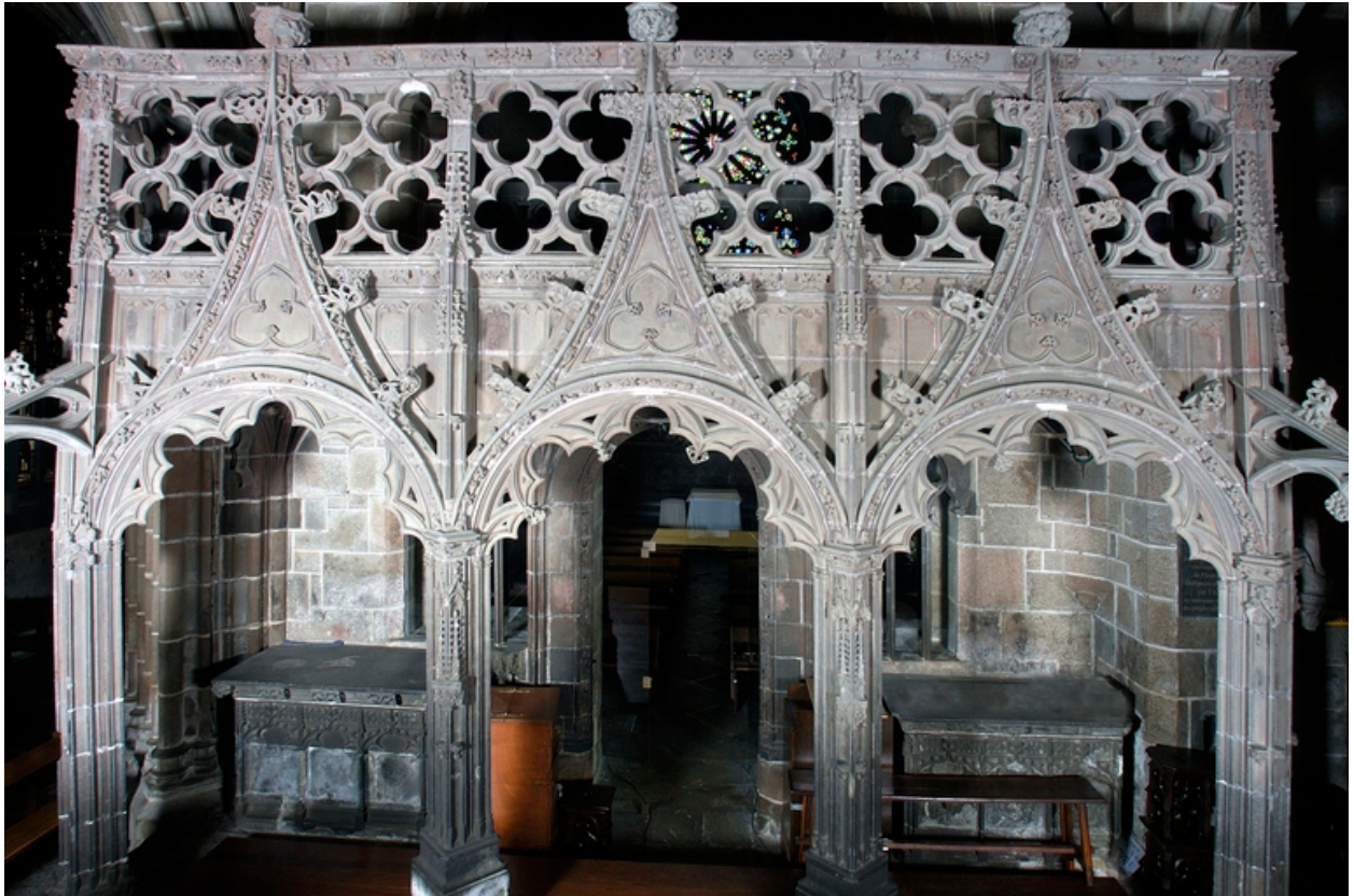
Façade ouest du jubé
