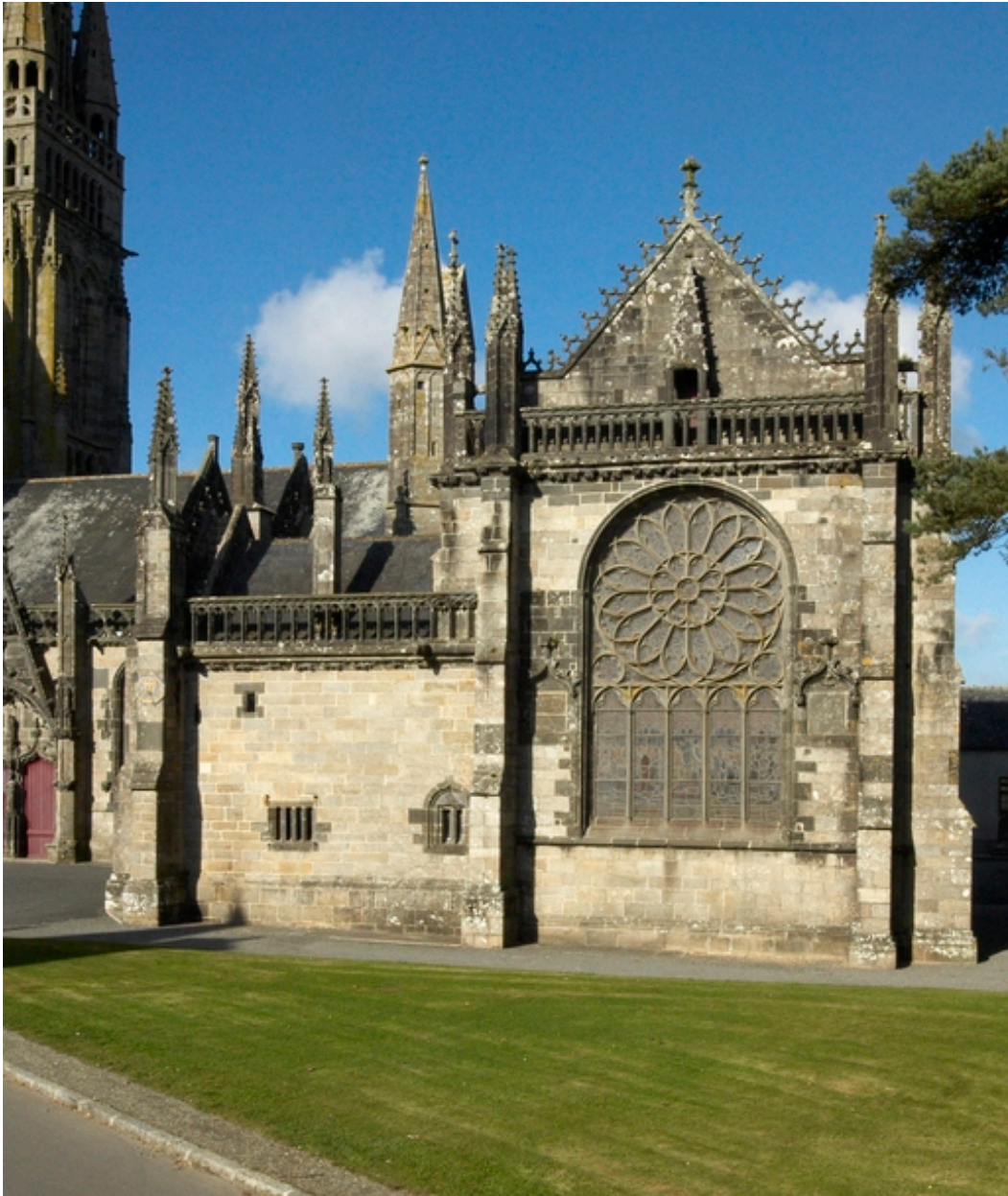
La sacristie et la chapelle de croix vues du sud
