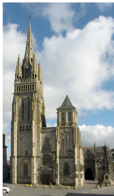
Vue générale de la façade ouest Phot. Alain Dagorn IVR53_20082900199NUCA
