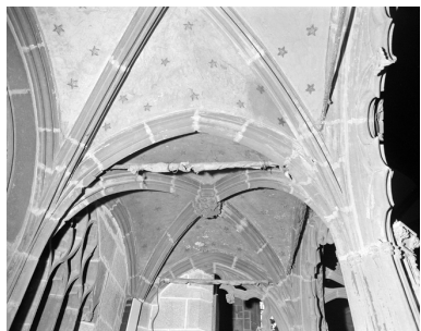
Jubé, détail du voûtement Phot. François Dagorn IVR53_19742900355X
