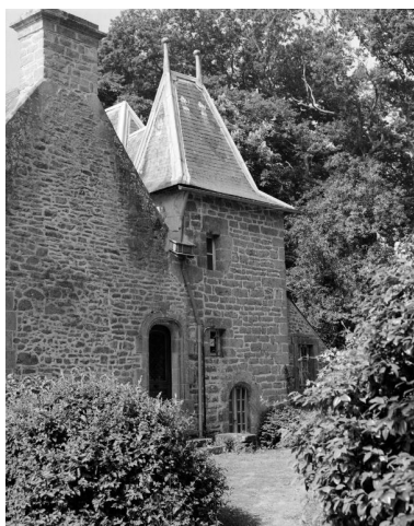
Tour d'escalier XVIIe siècle et pignon nord du corps de logis XVIe siècle. Phot. Guy Artur, Phot. Norbert Lambart IVR53_19925600915X
