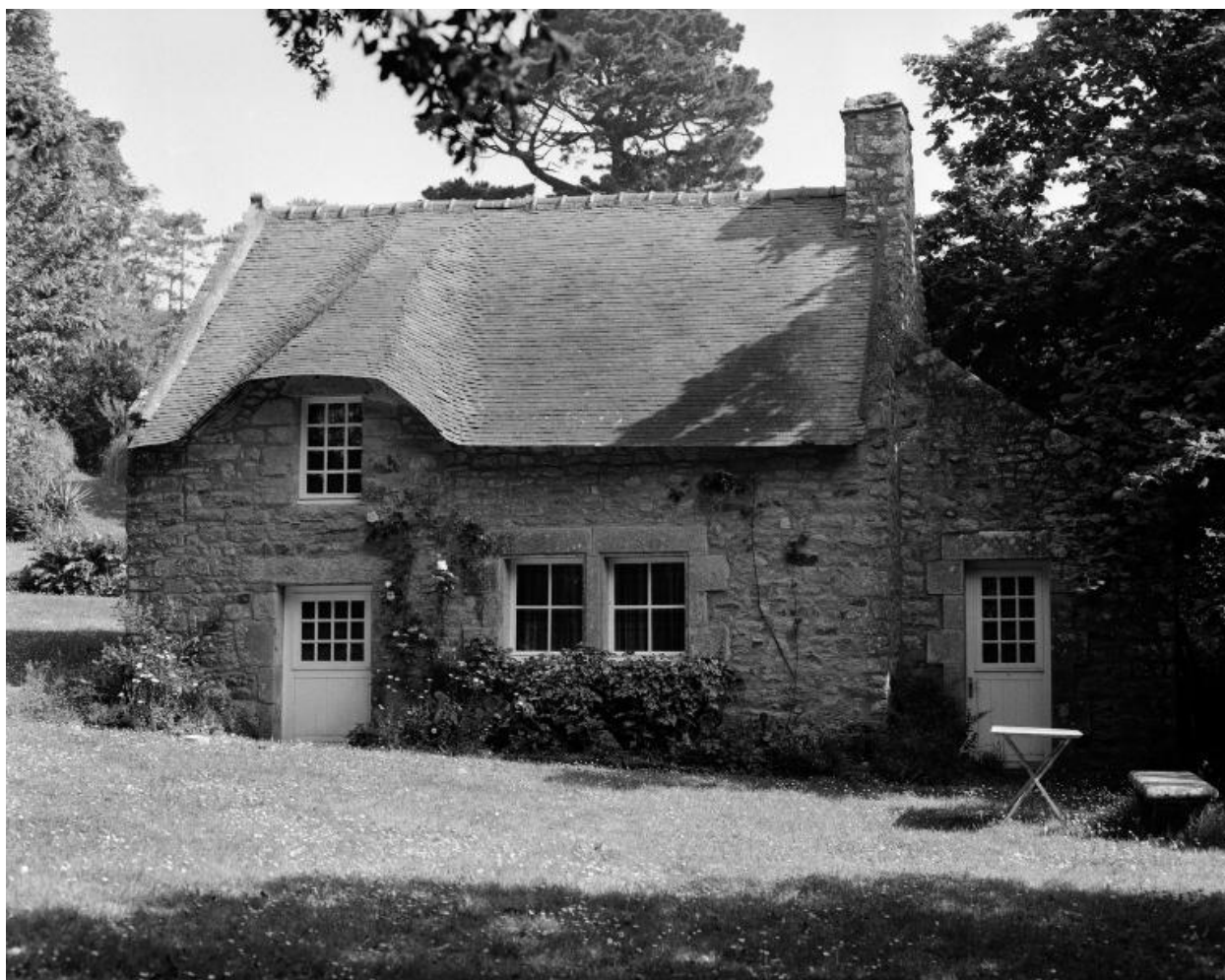
Moulin ou logis du moulin, élévation ouest.
