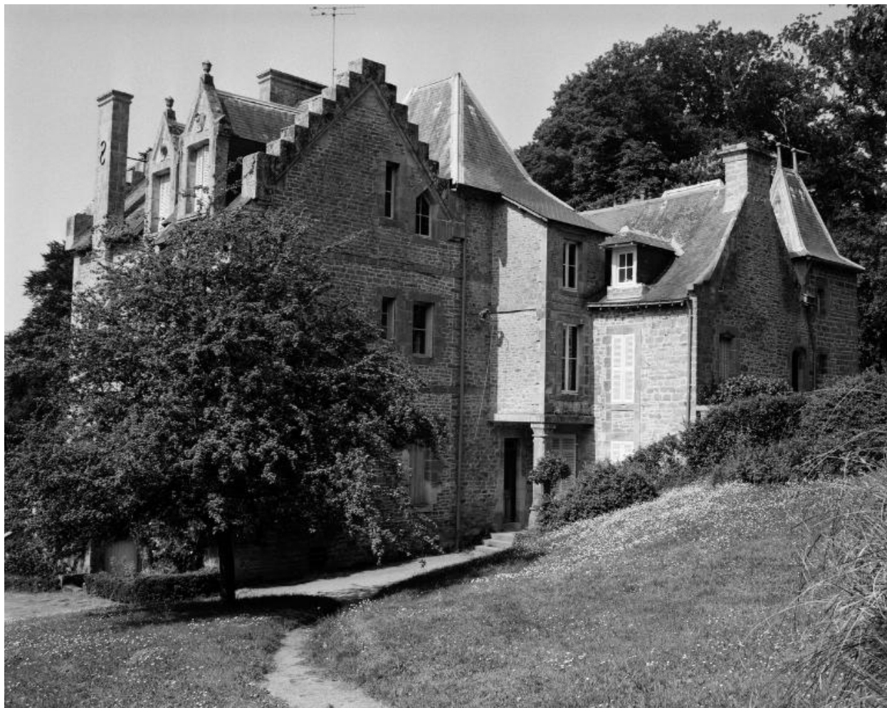
Vue générale nord-est.
