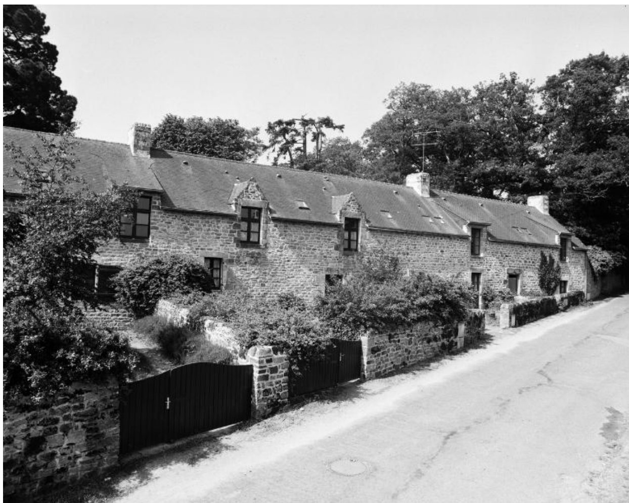
Ferme, élévation nord.
