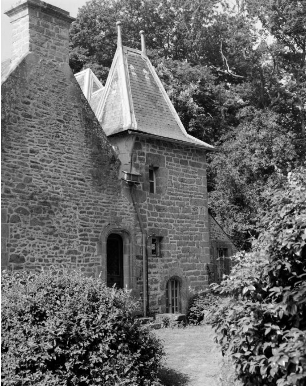
Tour d'escalier XVIIe siècle et pignon nord du corps de logis XVIe siècle.
