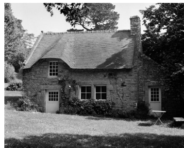
Moulin ou logis du moulin, élévation ouest. Phot. Guy Artur, Phot. Norbert Lambart IVR53_19925600907X
