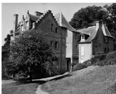
Vue générale nord-est. Phot. Guy Artur, Phot. Norbert Lambart IVR53_19925600914X
