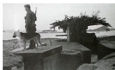
Vue d'un bunker - encuvement pour canon de 5 cm KwK (collection particulière). A gauche, en arrière- plan, on aperçoit la Passe aux Moutons et l'île Callot. Il s'agit d'une photographie de propagande : le soldat accompagné d'un berger allemand semble poser... Autr. Anonyme IVR53_20022901775NUCA
