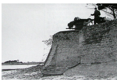
Vue d'un bunker - encuvement pour canon de 5 cm KwK (collection particulière). A gauche, en arrière-plan à gauche, on aperçoit l'île Callot. Il s'agit d'une photographie de propagande Autr. Anonyme IVR53_20022901774NUCA
