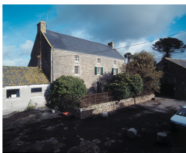
Vue générale sud-ouest Phot. Bernard Bègne IVR53_19995600134XA
