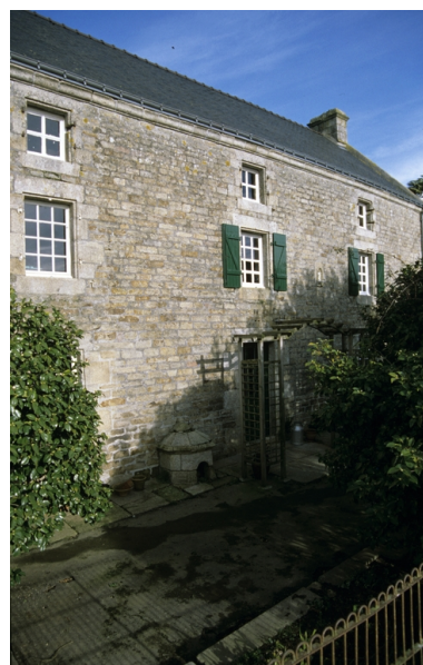
Vue générale sud-ouest. Phot. Bernard Bègne IVR53_19995600268ZA
