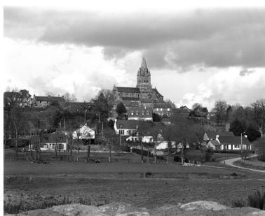
Elévation sud ; vue de situation Phot. Guy Artur, Phot. Norbert Lambart IVR53_19953500078X
