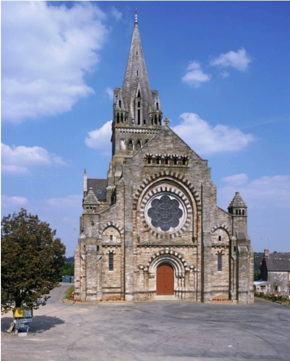
Vue générale ouest
