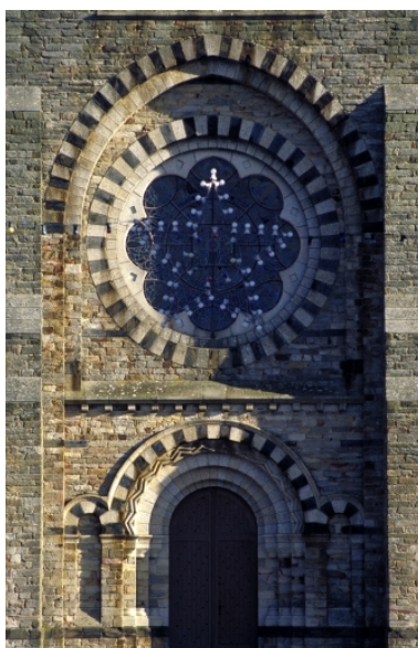
Elévation ouest ; détail Phot. Claude Quillivic IVR53_19943502948ZA
