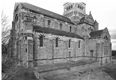
Elévation sud-ouest ; vue générale Phot. Guy Artur, Phot. Norbert Lambart IVR53_19953500081X
