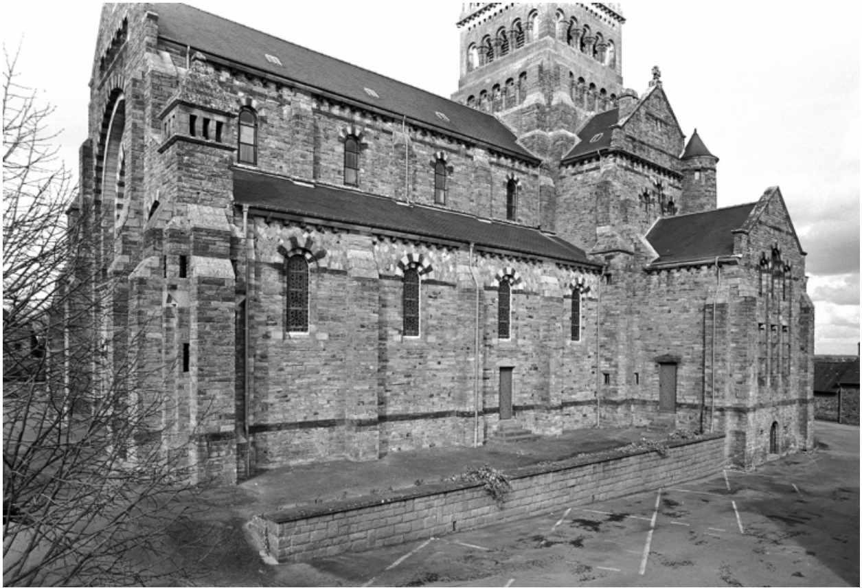
Elévation sud-ouest ; vue générale
