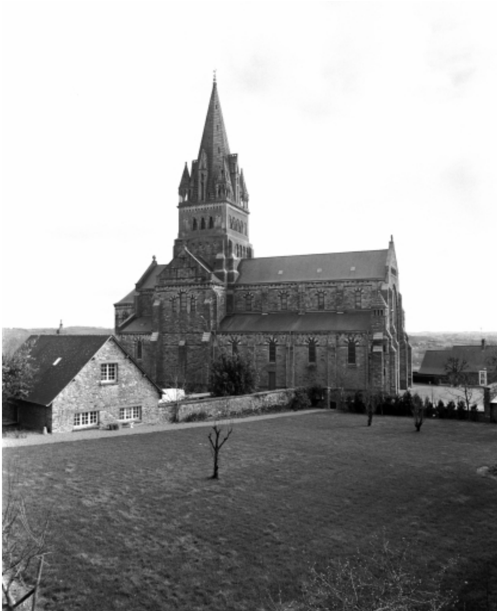
Vue générale nord
