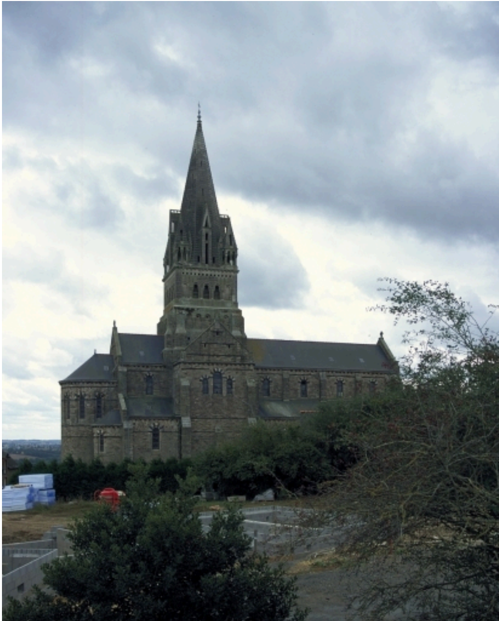
Vue générale nord
