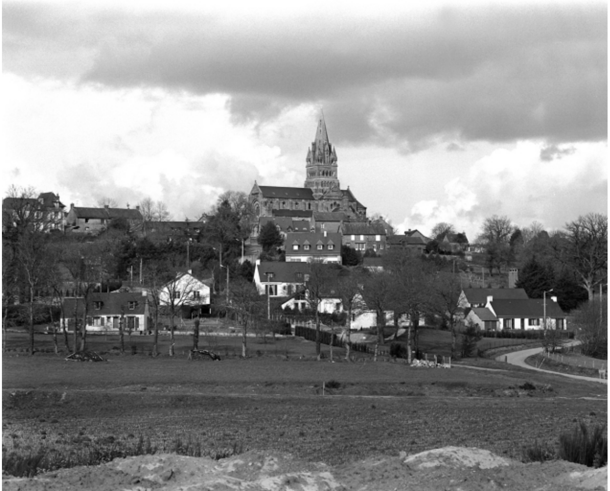
Elévation sud ; vue de situation
