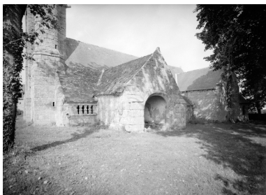
Vue générale sud-ouest Phot. François Dagorn IVR53_19742200989V
