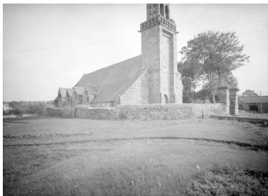
Vue générale nord-ouest Phot. François Dagorn IVR53_19742200986V
