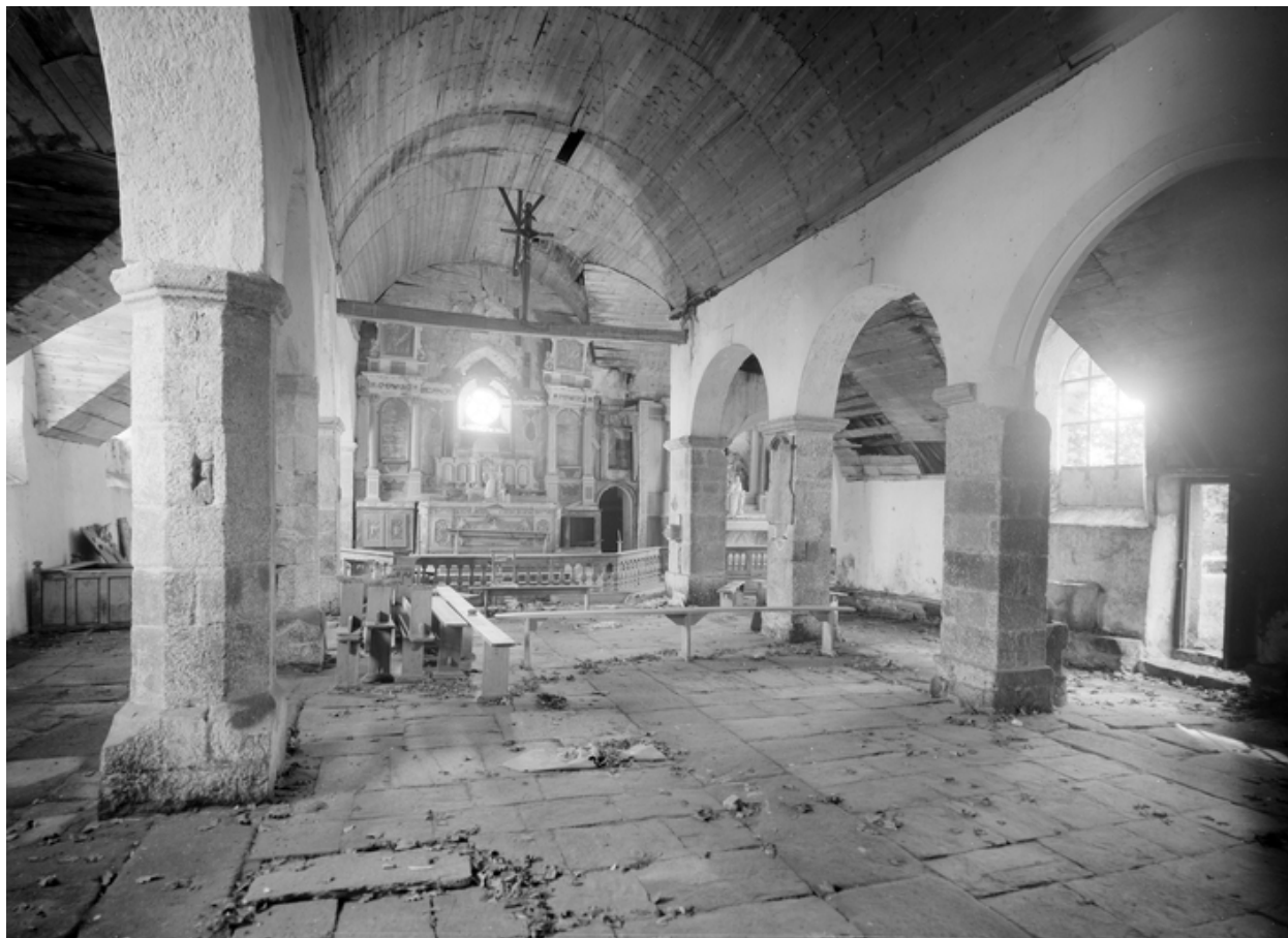
Vue générale d'ouest en est
