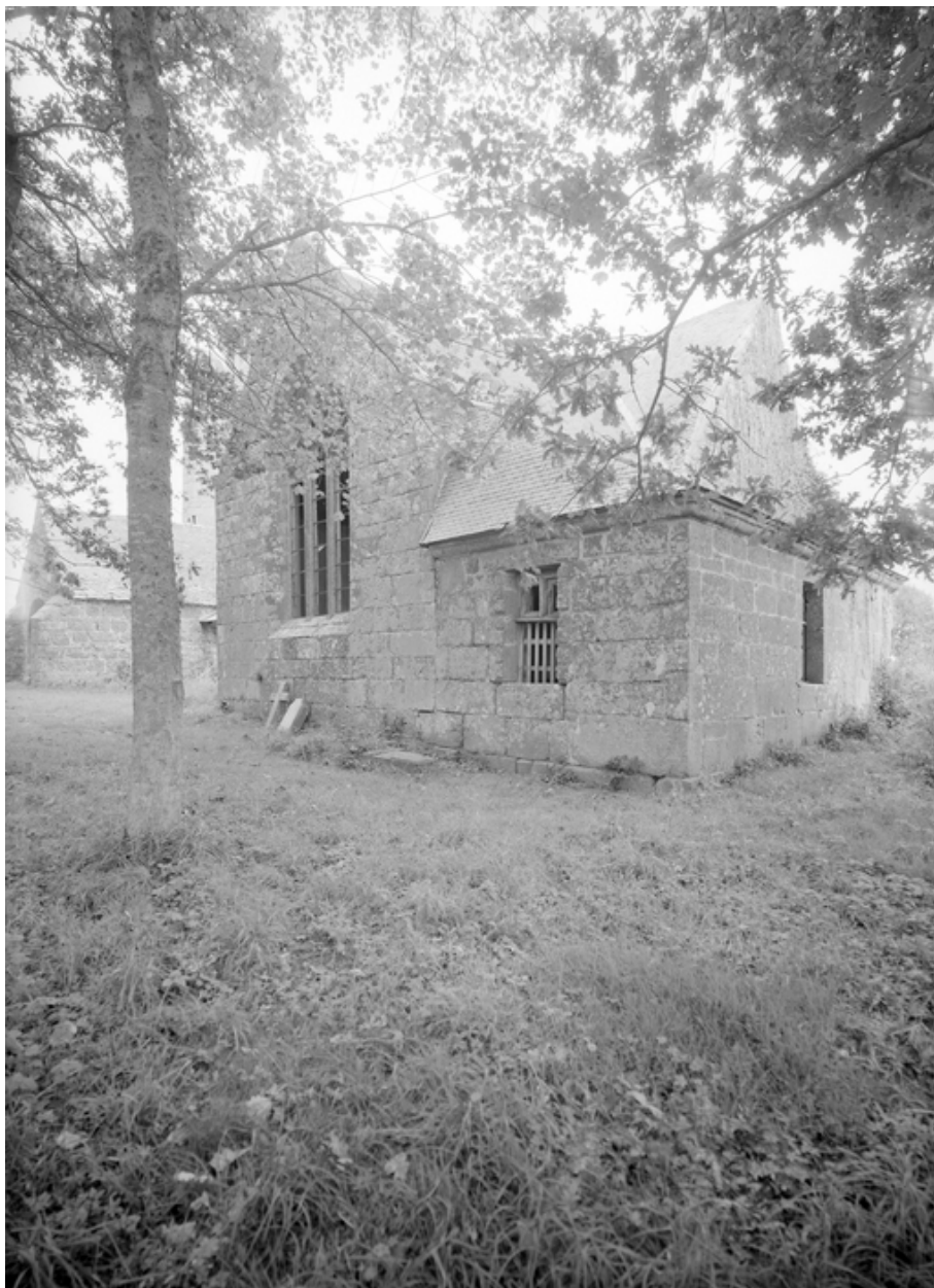
vue générale sud-est de la sacristie
