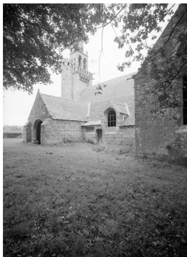
Vue générale sud Phot. François Dagorn IVR53_19742200898V
