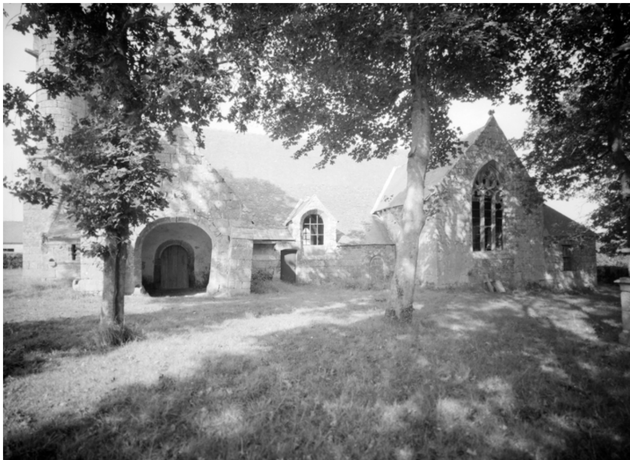
Face sud : vue générale
