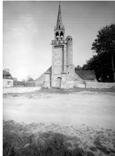
Vue générale ouest Phot. François Dagorn IVR53_19742200985V
