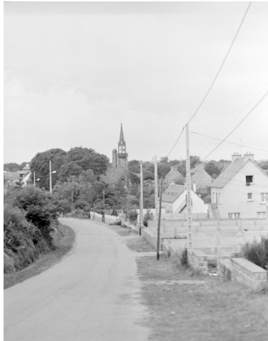
Vue de situation est de la chapelle Phot. François Dagorn IVR53_19742200902X
