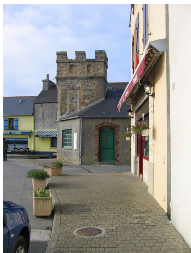
Vue latérale de la Tour du Fret Phot. Françoise Péron IVR53_20062908599NUCA
