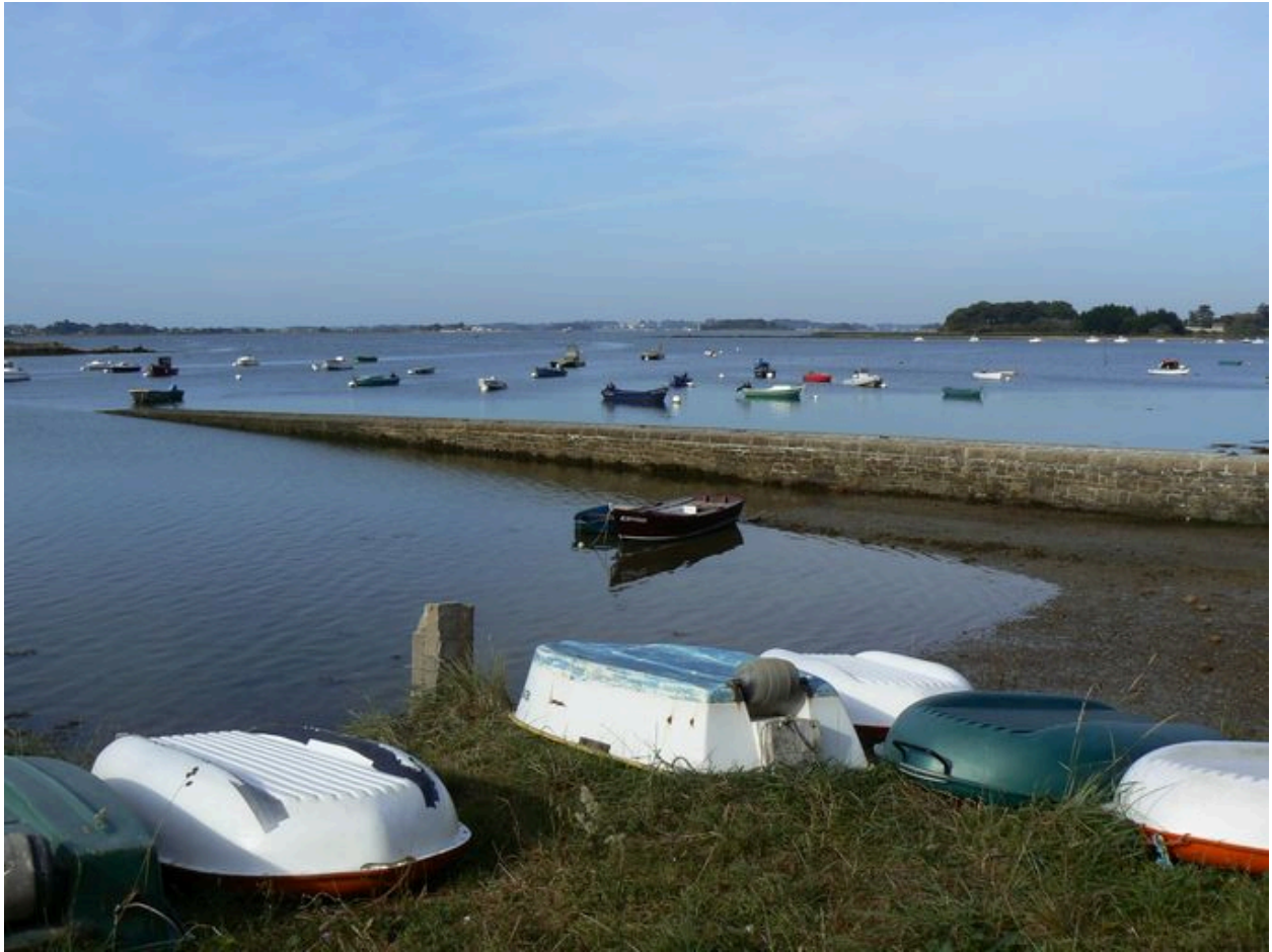
Vue générale de la cale de Badel
