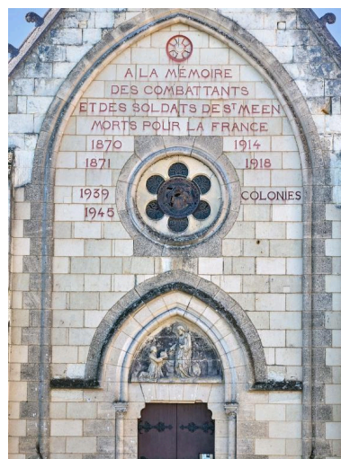
Façade est, inscriptions en mémoire des soldats morts pour la France depuis 1870 Phot. Bernard Bègne IVR53_20223500929NUCA
