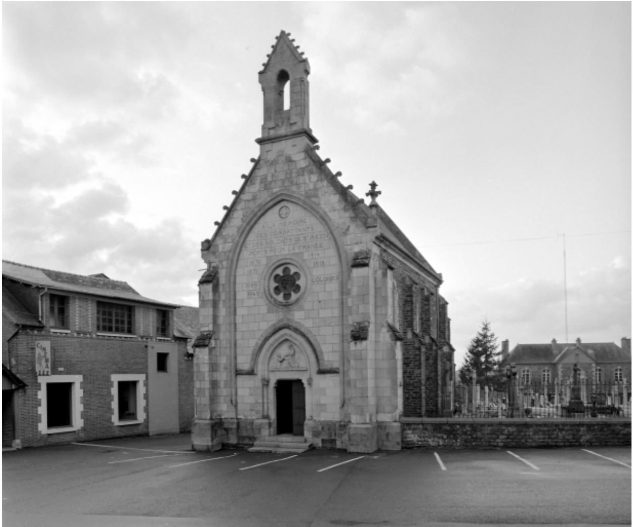
Elévation Nord-Est : vue de situation
