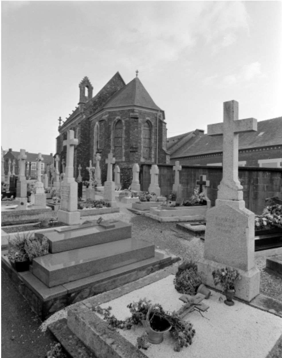
Elévation Sud-Ouest : vue de situation
