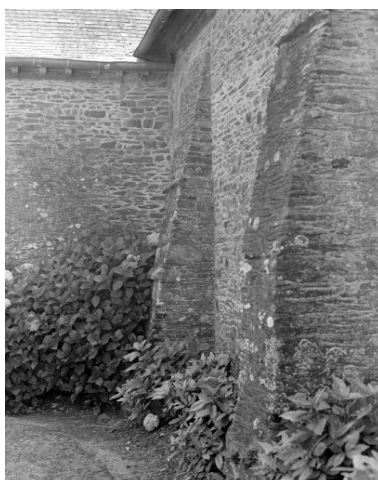
Elévation nord, détail du 5ème contrefort. Phot. Guy Artur, Phot. Norbert Lambart IVR53_19843500304X
