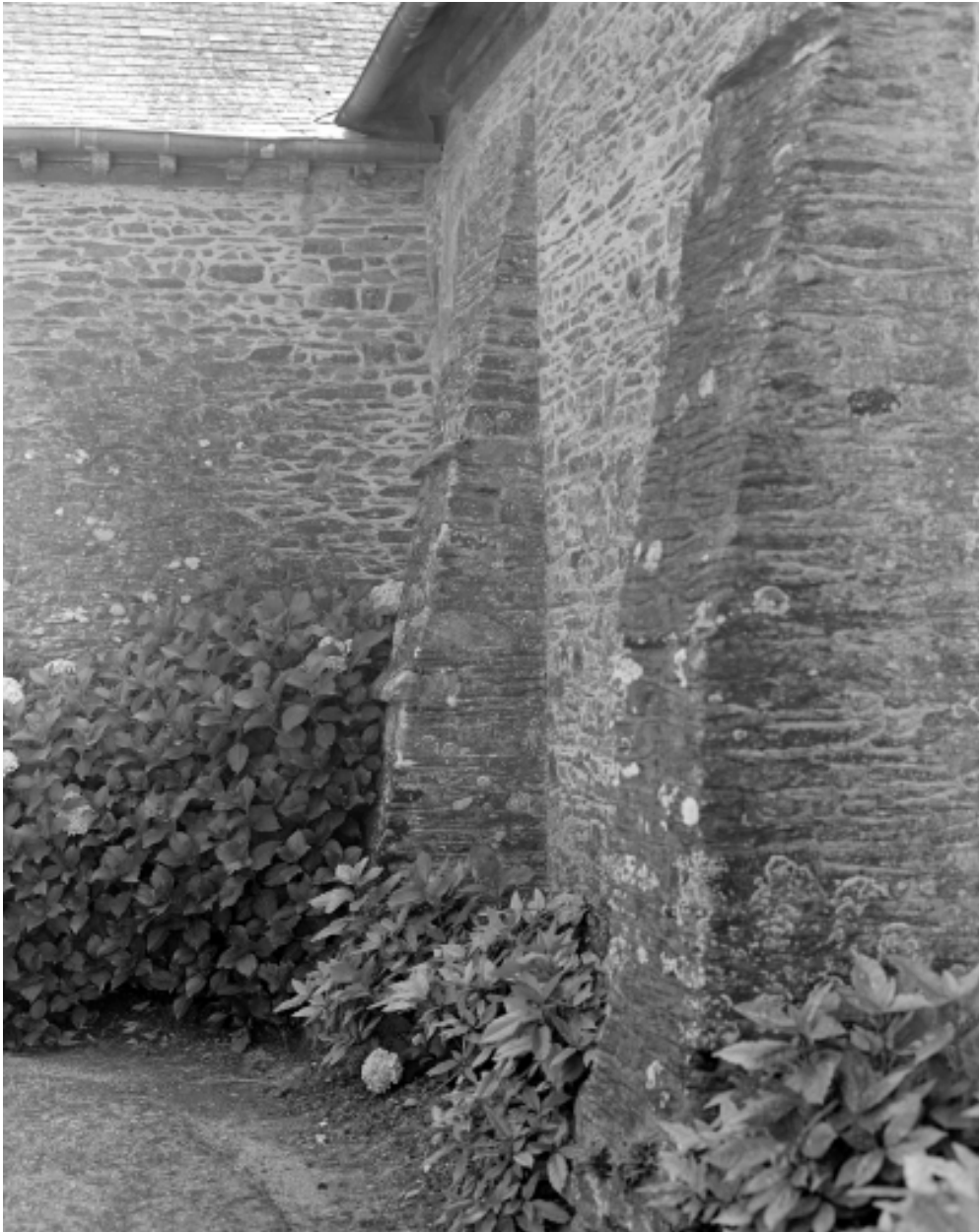
Elévation nord, détail du 5ème contrefort.
