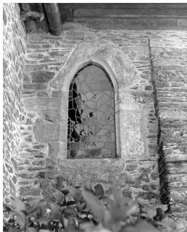
Elévation nord, détail de la petite fenêtre. Phot. Guy Artur, Phot. Norbert Lambart IVR53_19843500305X
