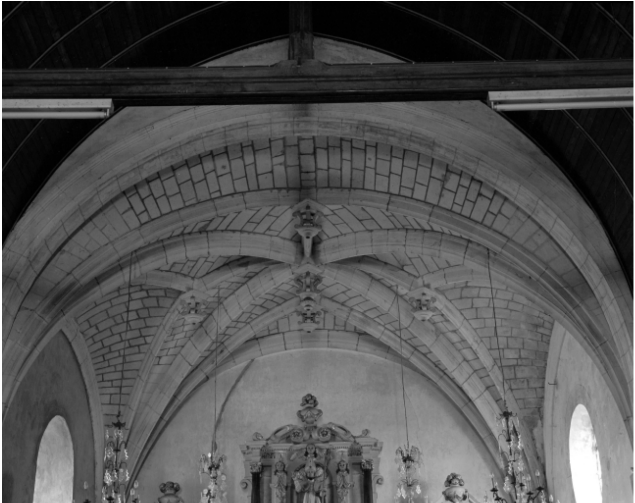
Voûte du chœur, vue générale.
