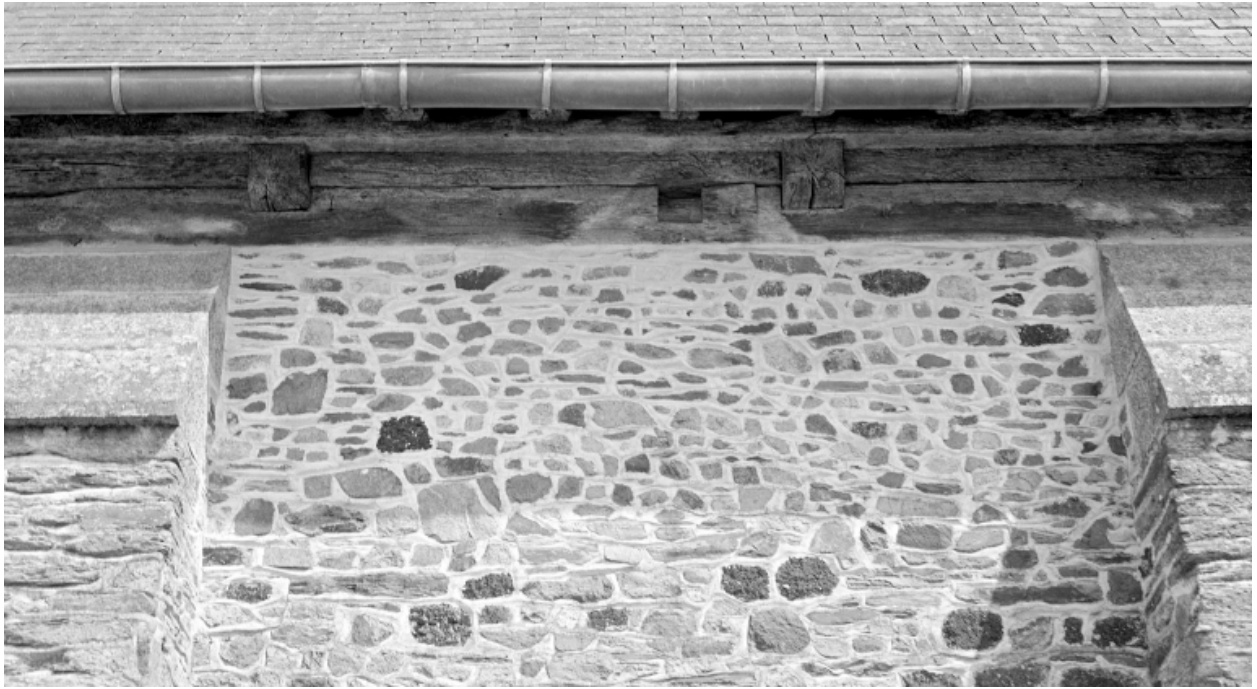
Elévation sud, détail de la sablière au-dessus de la porte.
