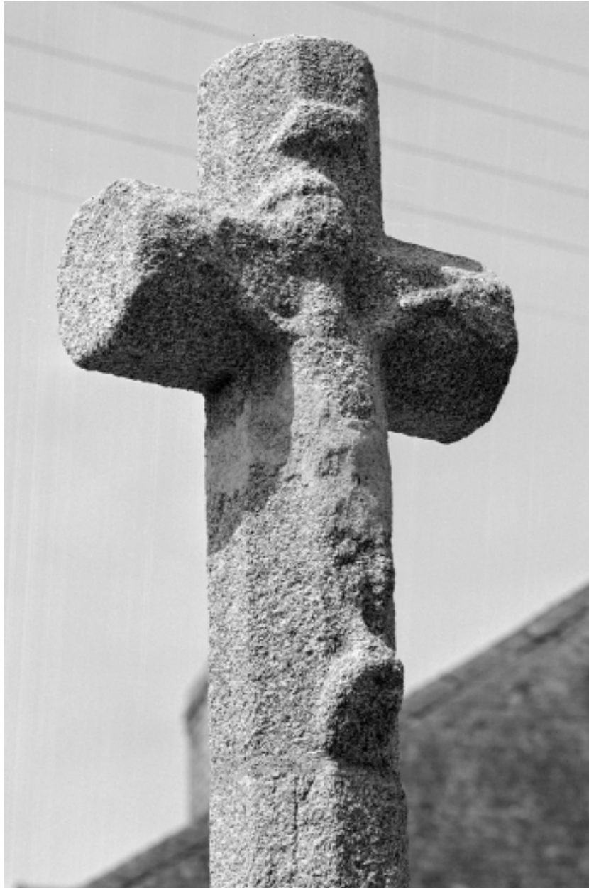
Croix du cimetière, détail du croisillon.
