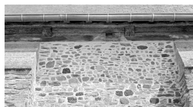
Elévation sud, détail de la sablière au-dessus de la porte. Phot. Guy Artur, Phot. Norbert Lambart IVR53_19843500315X
