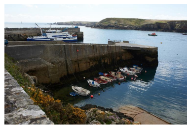
Môle du Stiff, côté ouest Phot. Marine Michel IVR53_20142900401NUCA
