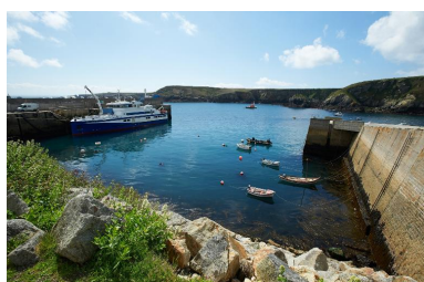
Môle du Stiff et digue Jarlan Phot. Marine Michel IVR53_20142900406NUCA
