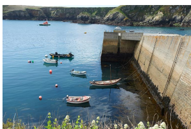
Môle du Stiff, côté est Phot. Marine Michel IVR53_20142900405NUCA
