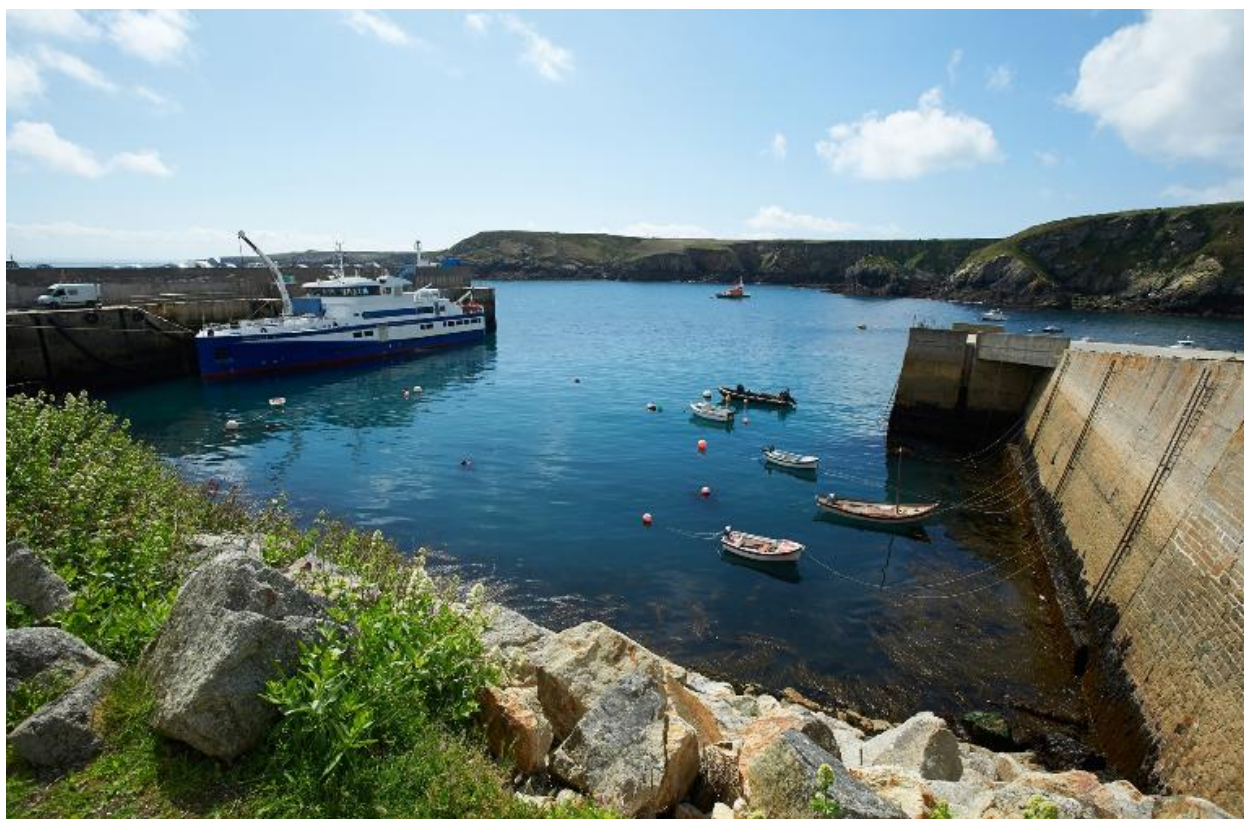
Môle du Stiff et digue Jarlan
