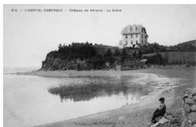
Vue de situation depuis la grève Phot. Elise Lauranceau IVR53_20042905492NUCB
