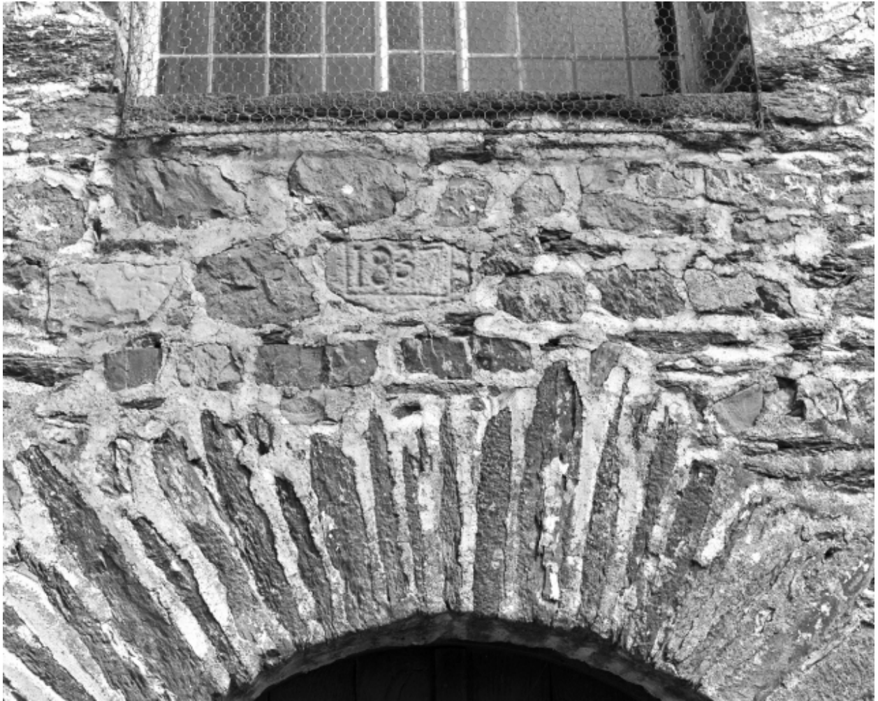
Elévation ouest, porte ; détail de l'inscription
