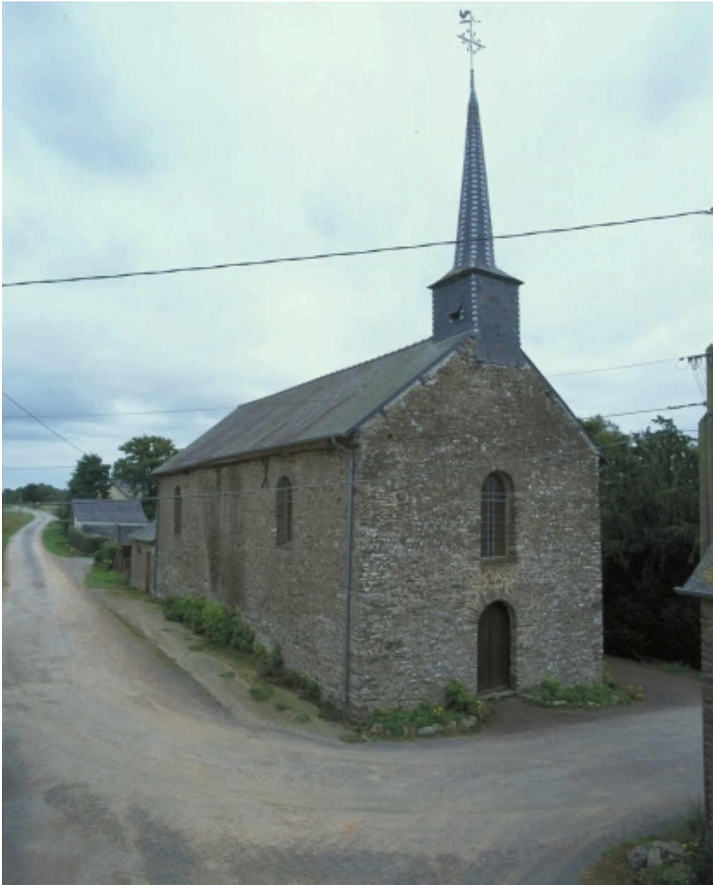
Elévation nord ouest
