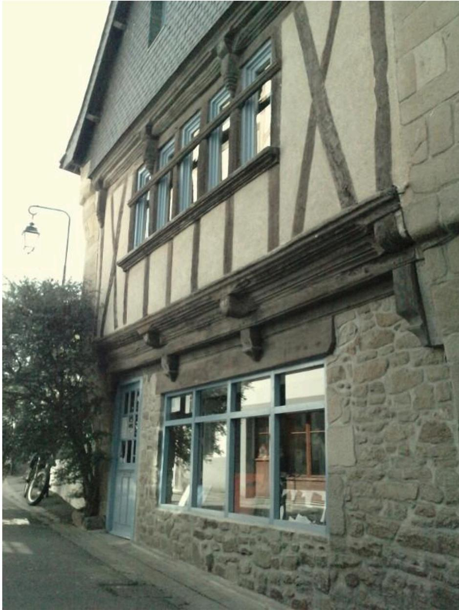
Façade en pan de bois avec encorbellement sur solives et détail du rez-de-chaussée maçonné
