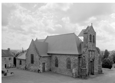
Élévation Nord-Ouest : vue générale Phot. Guy Artur, Phot. Norbert Lambart IVR53_19943501303X
