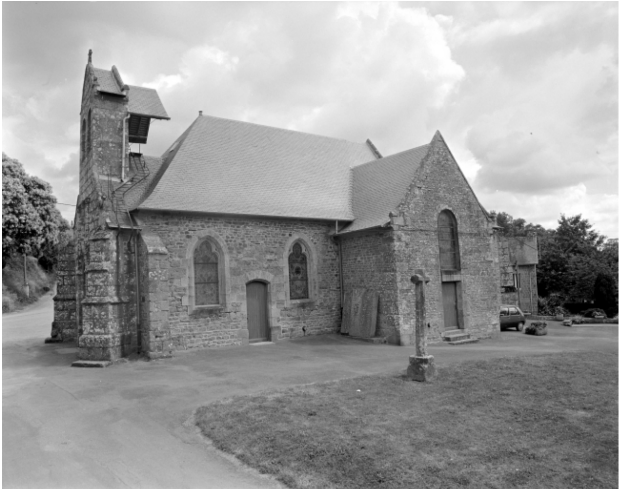
Elévation Sud : vue générale
