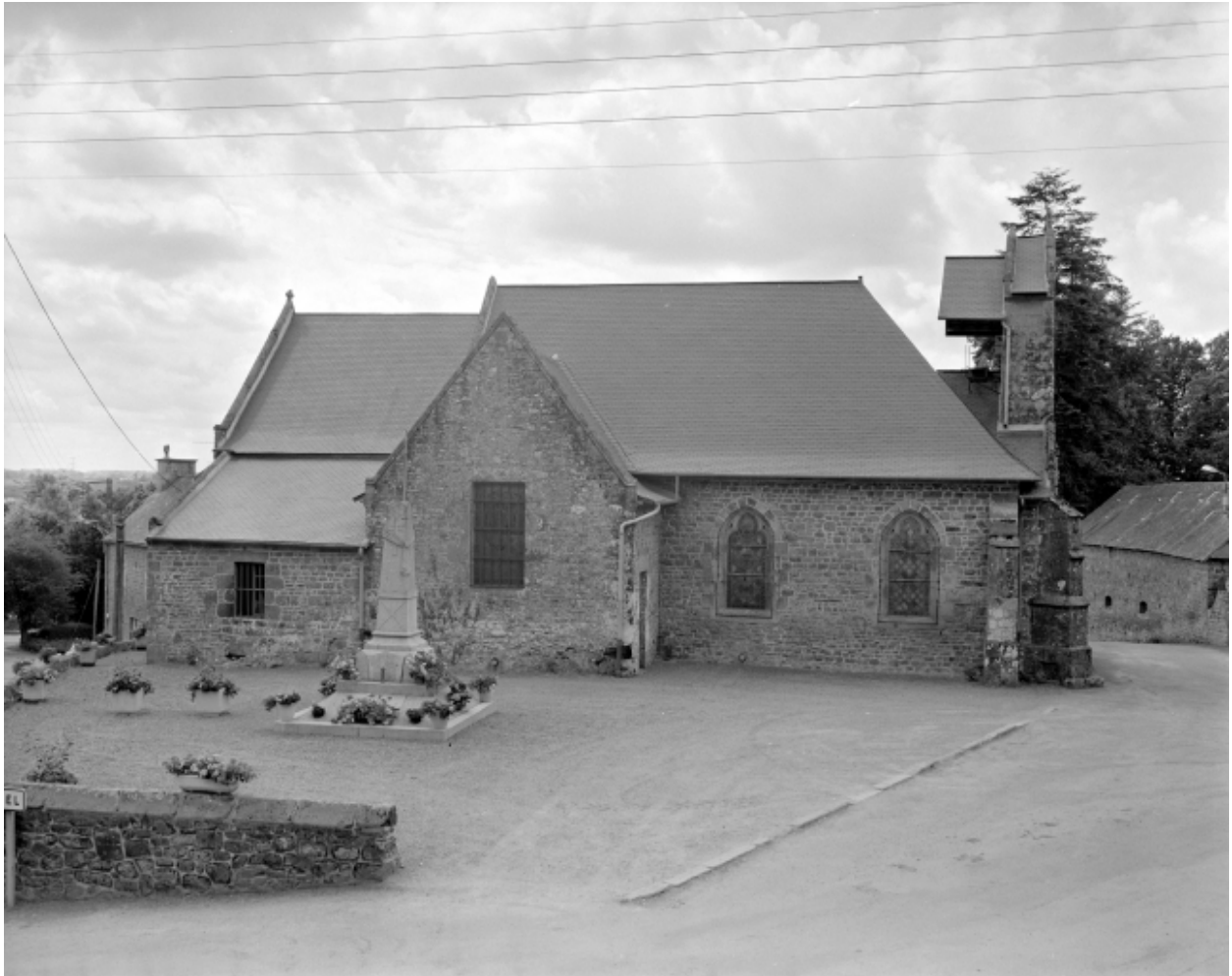
Elévation Nord : vue générale
