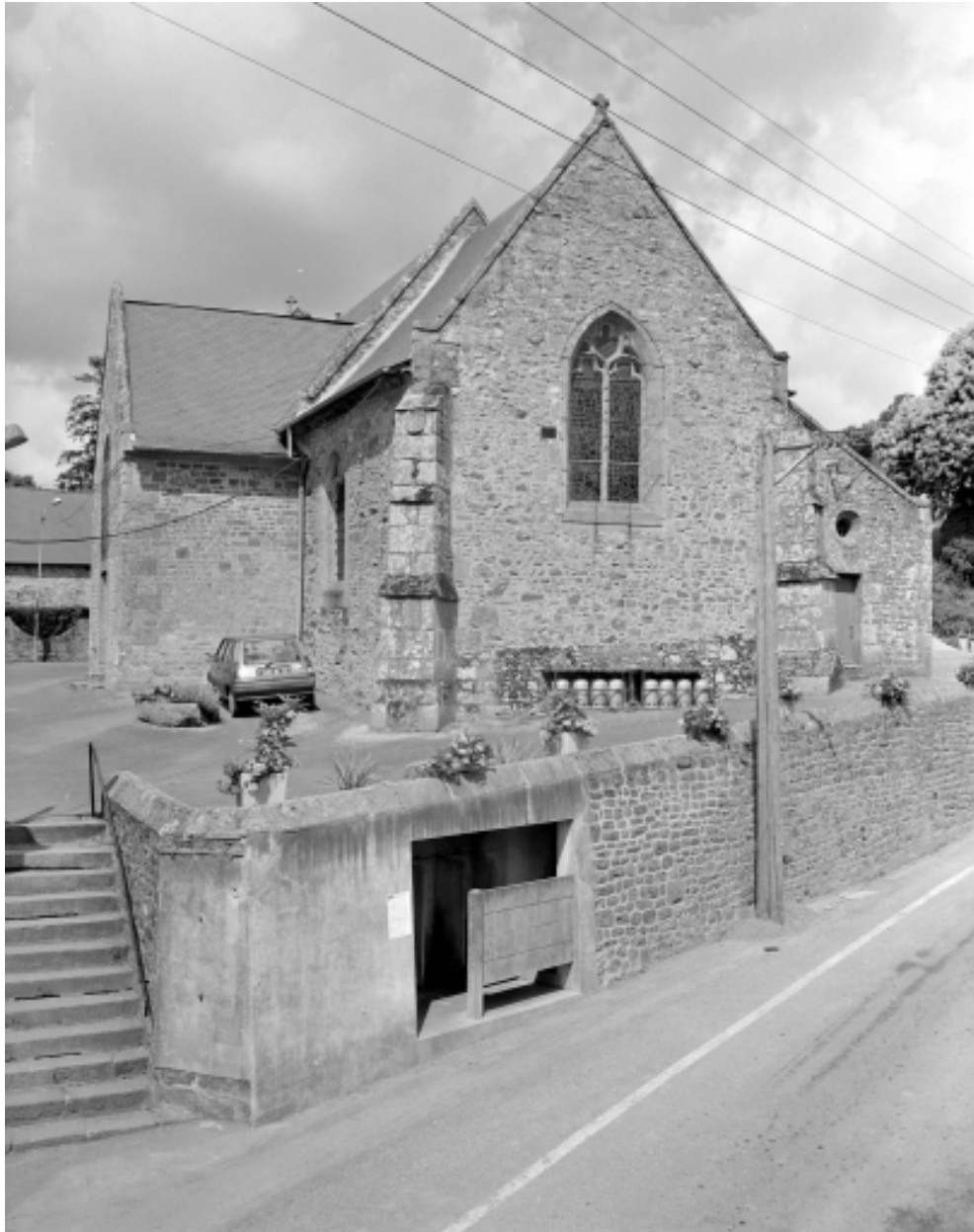
Elévation Est : vue générale
