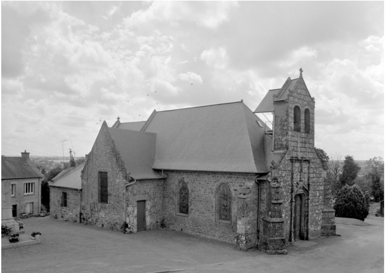
Elévation Nord-Ouest : vue générale
