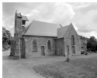
Élévation Sud : vue générale Phot. Guy Artur, Phot. Norbert Lambart IVR53_19943501301X
