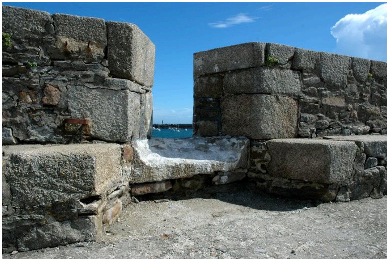
Vue de l'embrasure débouchée (état en 2004)
