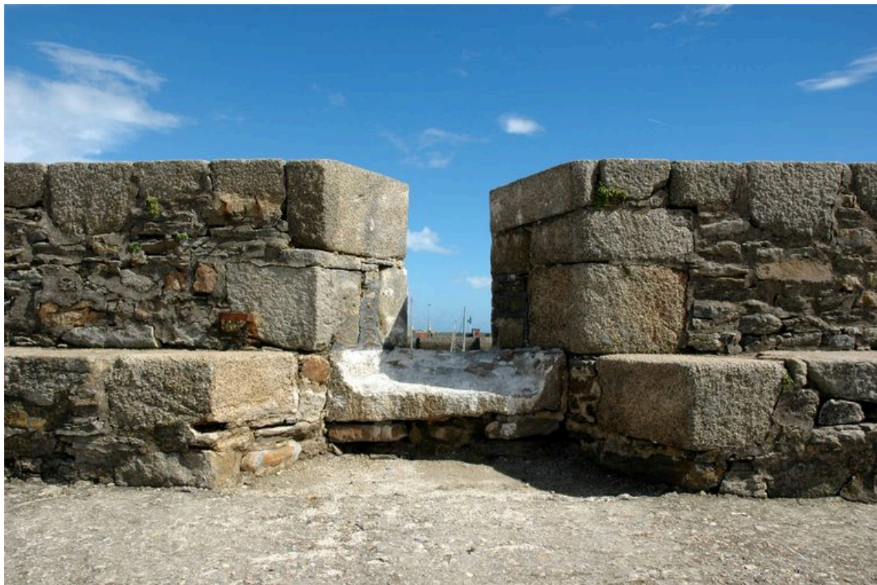
Vue de l'embrasure débouchée (état en 2004)
