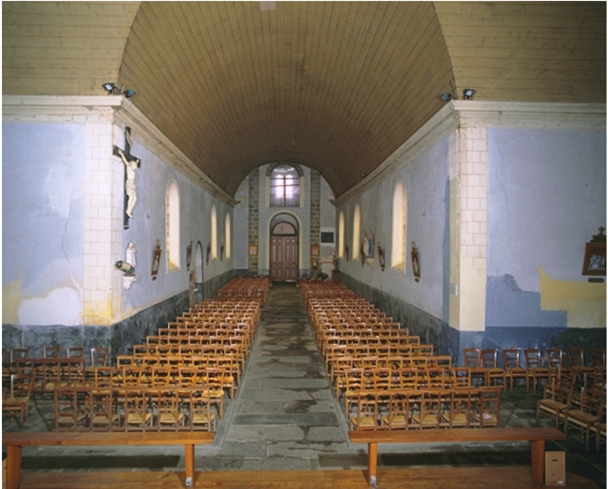
Vue générale vers la nef
