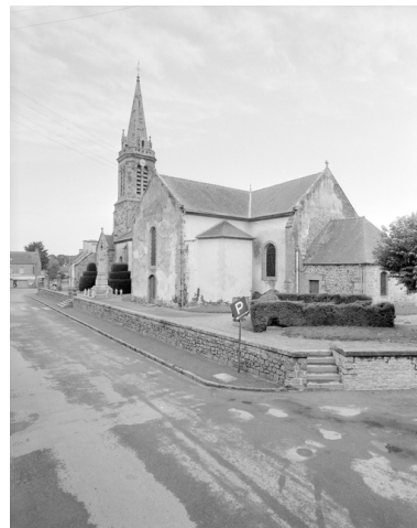
Vue générale sud est Phot. Guy Artur, Phot. Norbert Lambart IVR53_19943501785X
