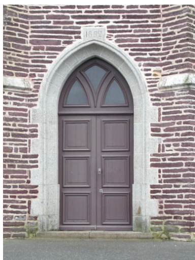
Porte ouest Phot. Stéphanie Ménard IVR53_20063505019NUCA
