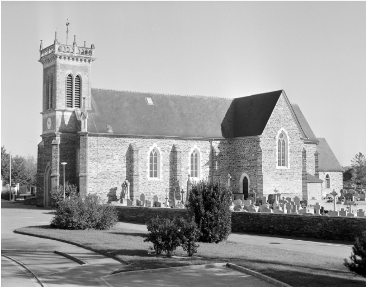
Elévation Sud : vue générale
