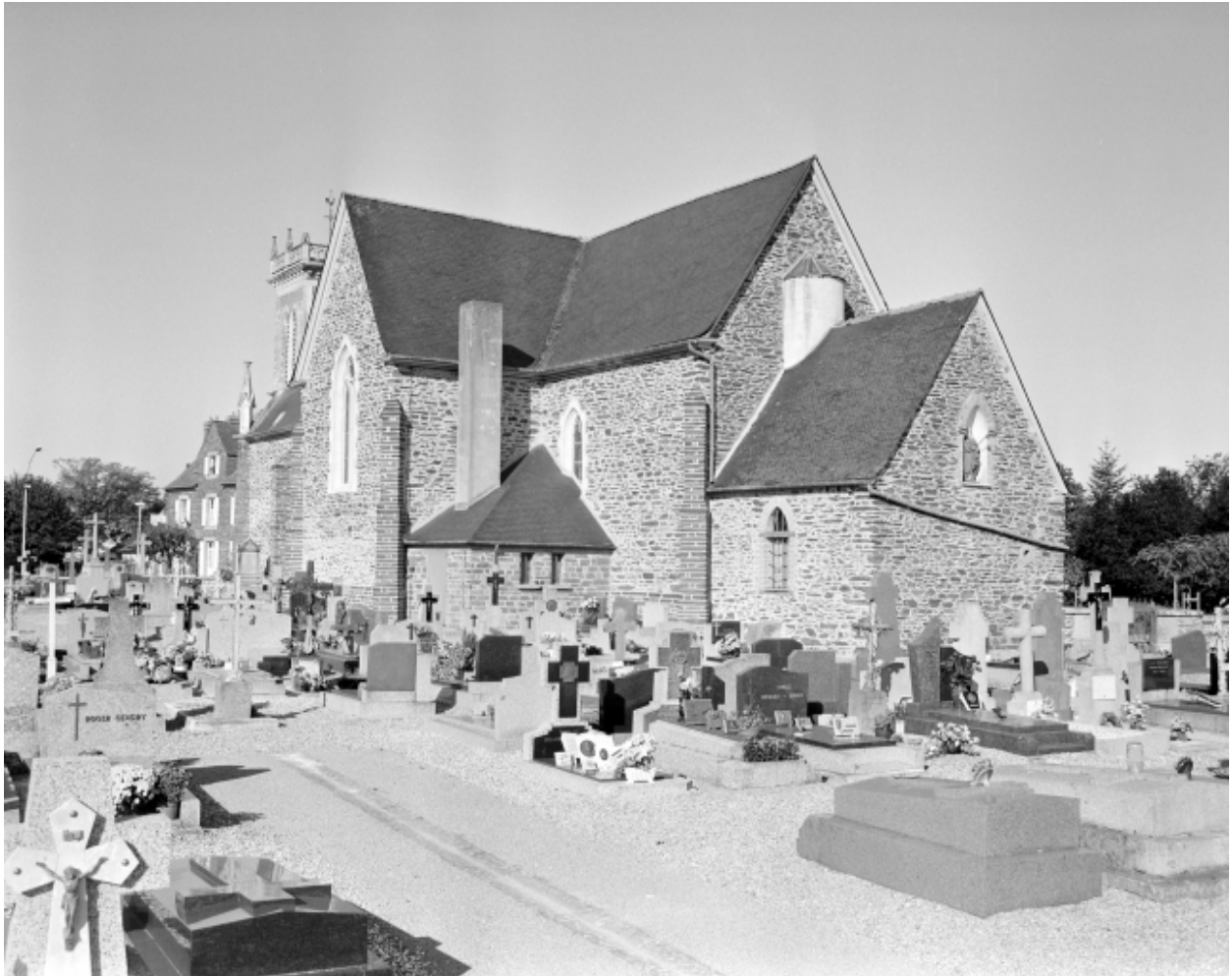
Elévation Est : vue générale
