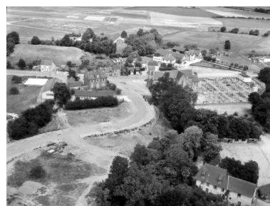
Eglise paroissiale, vue aérienne vers le nord-ouest. Phot. G.A.L.A.T. IVR53_19843500800V
