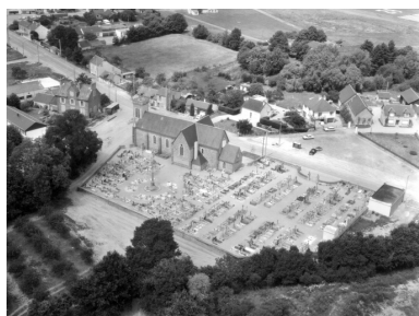
Eglise paroissiale, vue aérienne vers le nord ouest. Phot. G.A.L.A.T. IVR53_19843500819V
