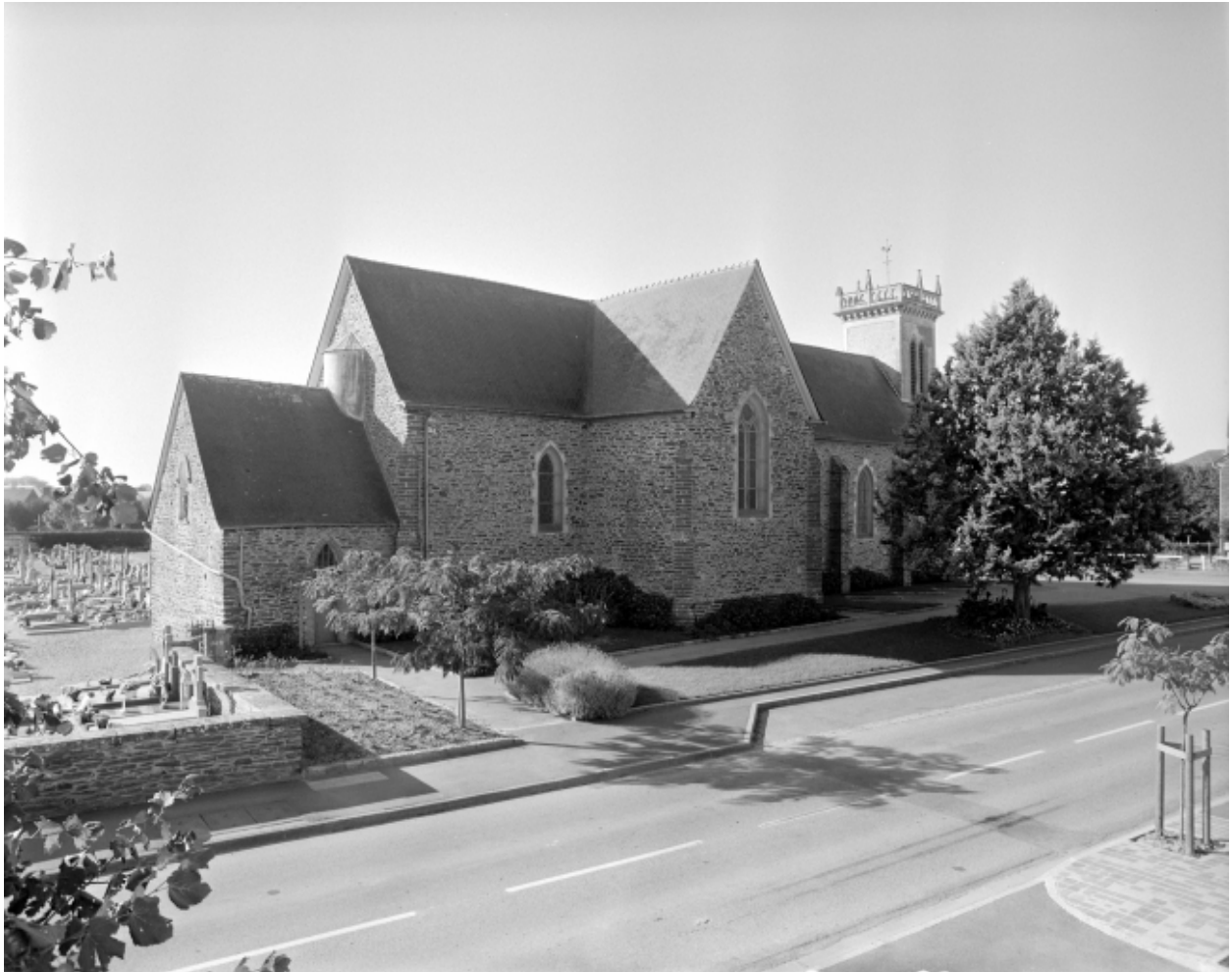
Elévation Nord : vue générale
