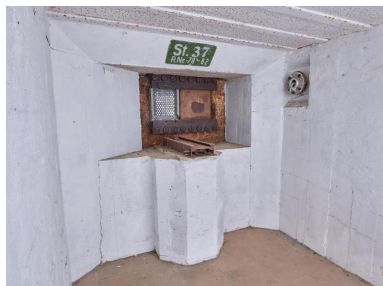
Vue de la chambre de combat : support d'affût de la mitrailleuse et créneau blindé (St. 37). Au-dessus du poste de tir, cartouche avec marquage. A droite, clapet de surpression du système de ventilation Phot. Bernard Bègne IVR53_20235600742NUCA
