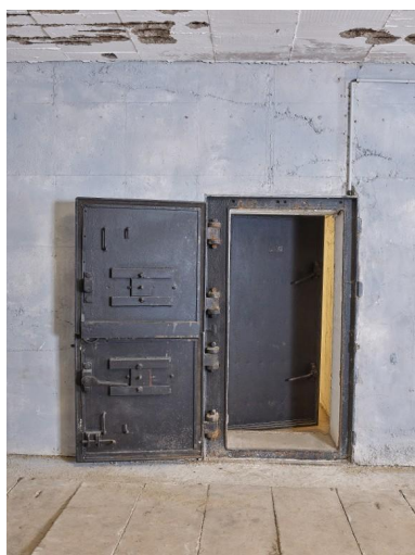
Vue de l'accès à la chambre de combat nord : porte blindée à deux vantaux et porte étanche Phot. Bernard Bègne IVR53_20235600733NUCA
