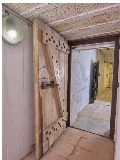
Vue de la porte en bois des trois chambres de combat sud (depuis l'intérieur). La porte est d'origine
