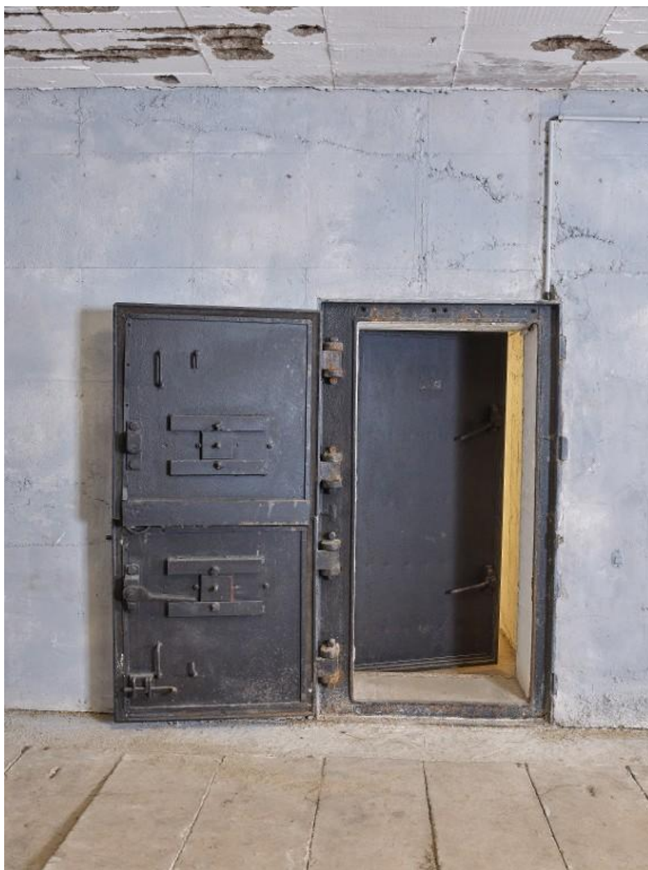
Vue de l'accès à la chambre de combat nord : porte blindée à deux vantaux et porte étanche
