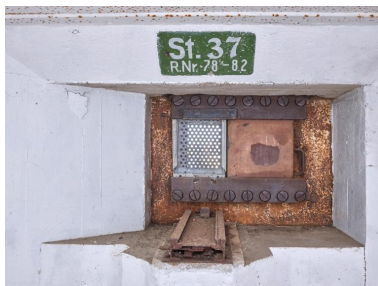
Vue de la chambre de combat : support d'affût de la mitrailleuse et créneau blindé. Au-dessus du poste de tir, cartouche avec marquage. On peut lire : St. 37 ; R.Nr. 78-82 Phot. Bernard Bègne IVR53_20235600743NUCA
