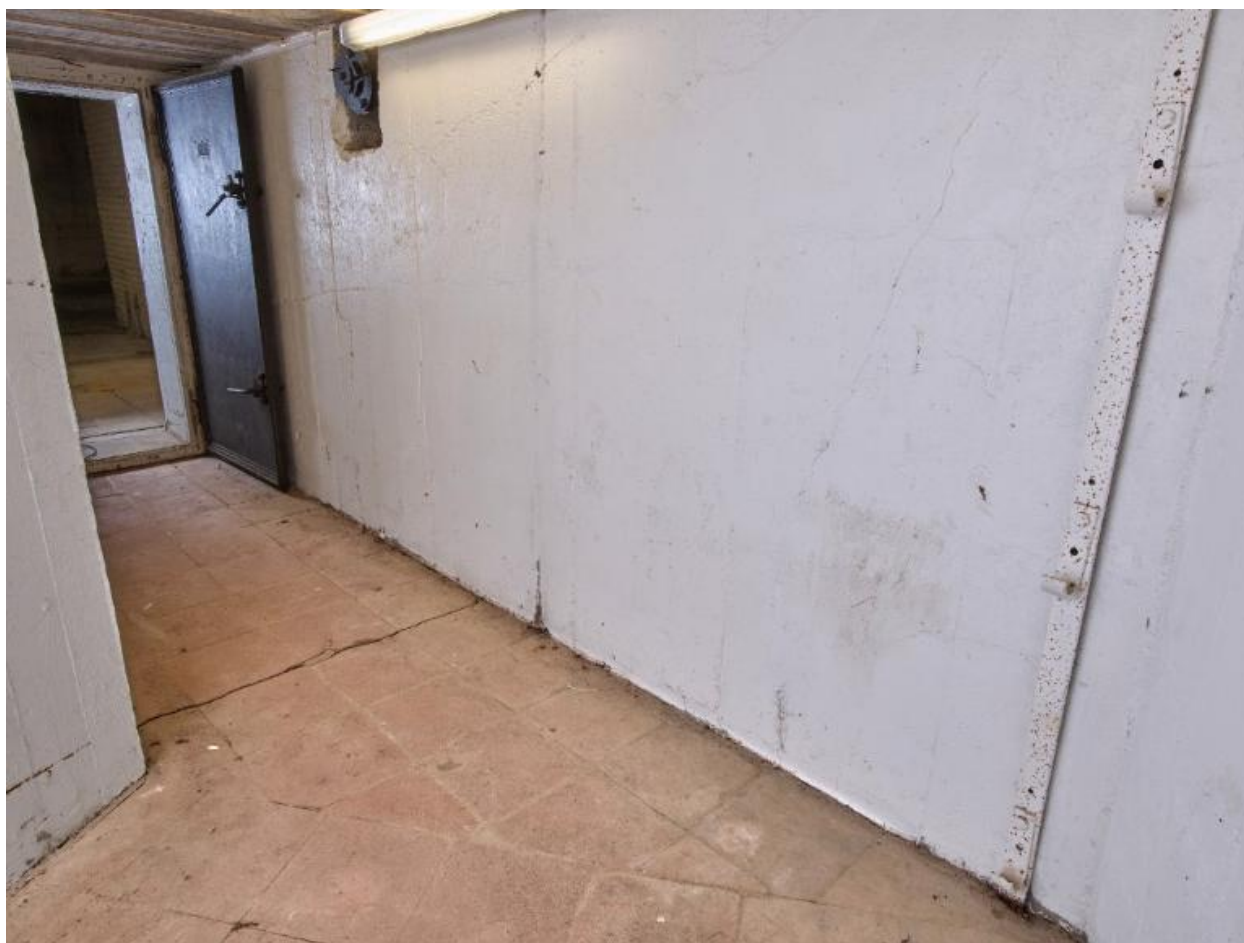
Vue du couloir d'accès de la chambre de combat nord : au fond, porte étanche ; au premier plan à droite, fixations murales pour trois couchettes tubulaires
