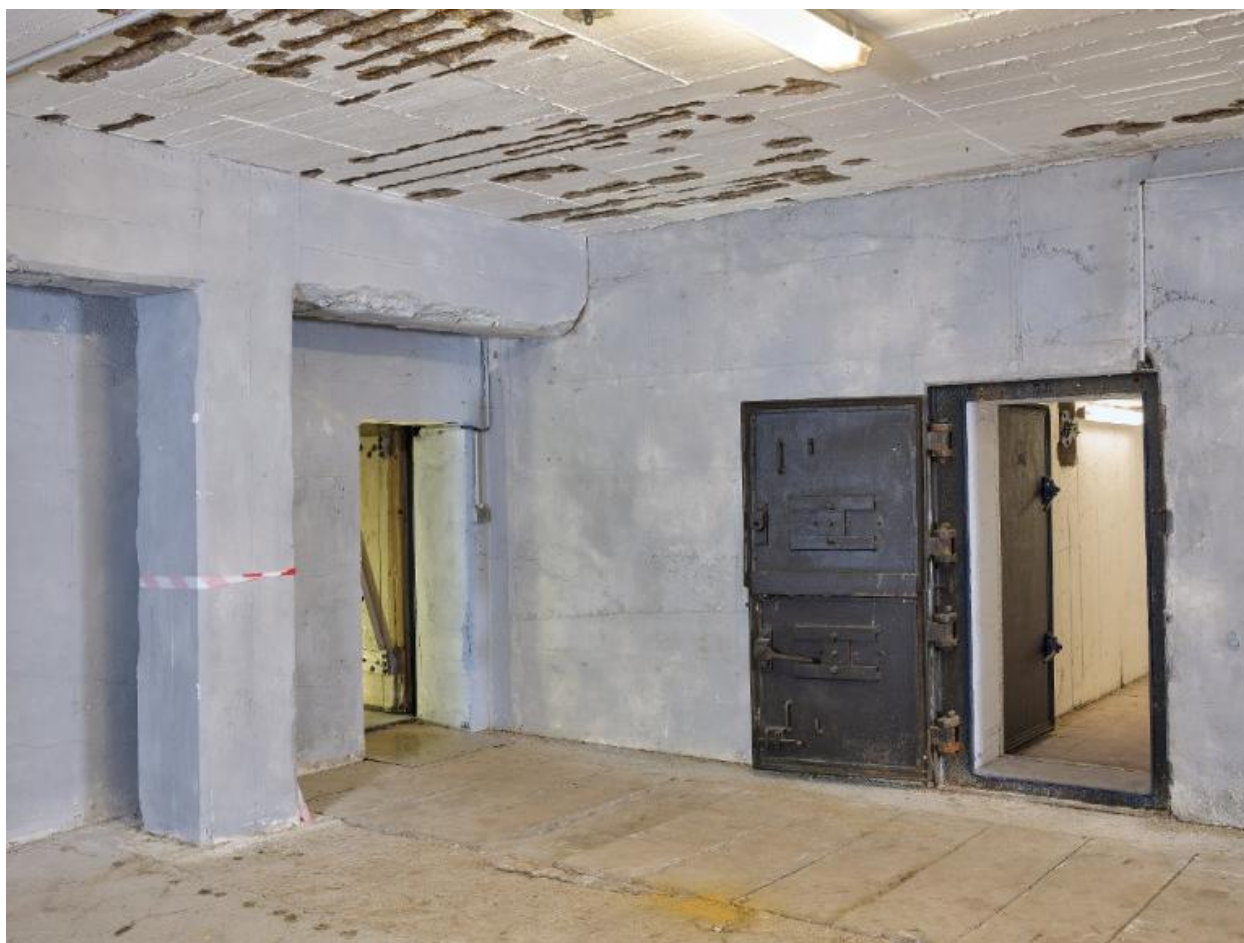
Vue des accès à la chambre de combat nord à droite (porte blindée à deux vantaux et porte étanche) et aux trois chambres de combat sud à gauche (porte en bois)
