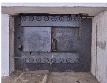
Vue de la chambre de combat nord : détail du créneau blindé (St. 36). Le volet blindé mesure 8 cm d'épaisseur Phot. Bernard Bègne IVR53_20235600735NUCA
