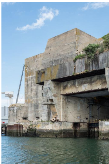
Vue de situation de la casemate pour quatre mitrailleuses flanquant l'angle ouest du bunker "KIII". Cet angle est surmonté par un encuvement pour canon antiaérien. A droite, alvéole A Phot. Charlotte Barraud IVR53_20215600596NUCA
