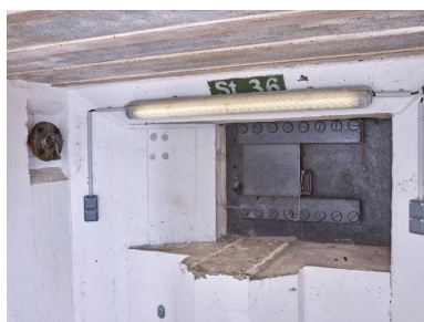
Vue de la chambre de combat nord : support d'affût de la mitrailleuse et créneau blindé ; au-dessus, cartouche avec marquage. On peut lire : St. 36. A gauche, clapet de surpression du système de ventilation. Le système d'éclairage masque le cartouche Phot. Bernard Bègne IVR53_20235600734NUCA
