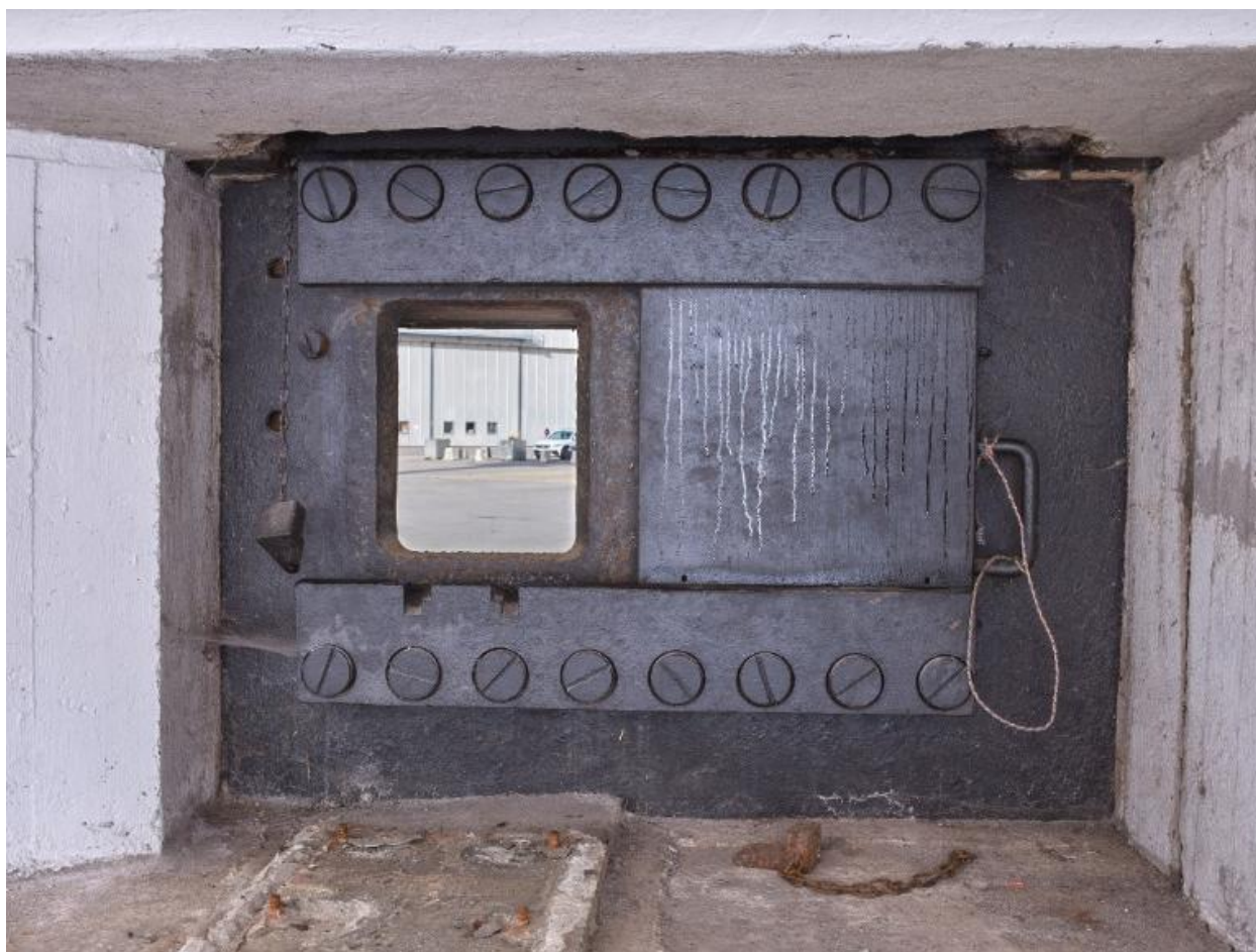
Vue de la chambre de combat nord (St. 36) : détail du créneau blindé et panorama sur le bunker KI. Le volet blindé mesure 8 cm d'épaisseur.
