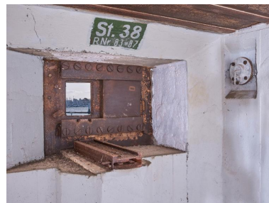
Vue de la chambre de combat sud : support d'affût de la mitrailleuse et créneau blindé. Au-dessus du poste de tir, cartouche avec marquage. On peut lire : St. 38 ; R.Nr. 83-87. A droite, clapet de surpression du système de ventilation Phot. Bernard Bègne IVR53_20235600744NUCA
