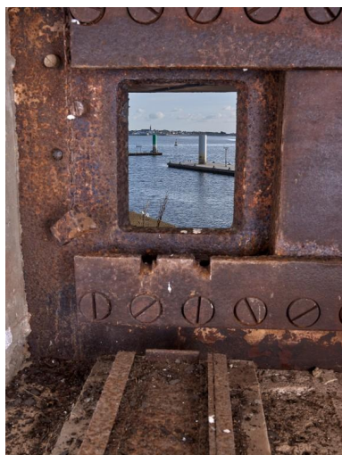
Vue de la chambre de combat sud : panorama de tir à travers le créneau blindé (St. 38). Au premier-plan, sellette d'affût de la mitrailleuse Phot. Bernard Bègne IVR53_20235600745NUCA
