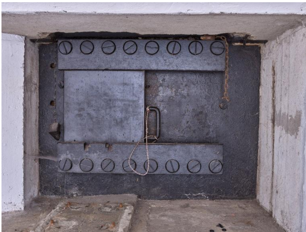
Vue de la chambre de combat nord : détail du créneau blindé (St. 36). Le volet blindé mesure 8 cm d'épaisseur
