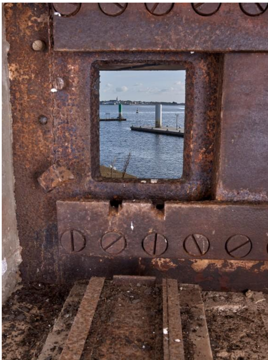
Vue de la chambre de combat sud : panorama de tir à travers le créneau blindé (St. 38). Au premier-plan, sellette d'affût de la mitrailleuse
