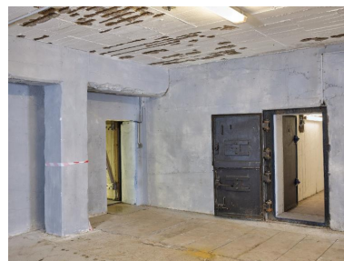
Vue des accès à la chambre de combat nord à droite (porte blindée à deux vantaux et porte étanche) et aux trois chambres de combat sud à gauche (porte en bois) Phot. Bernard Bègne IVR53_20235600732NUCA
