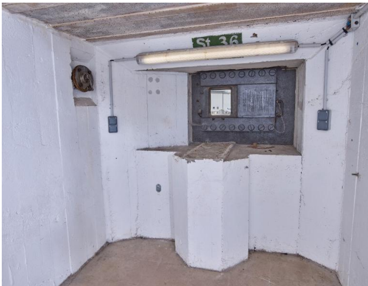
Vue de la chambre de combat nord : support d'affût de la mitrailleuse et créneau blindé ; au-dessus, cartouche avec marquage. On peut lire : St. 36. A gauche, clapet de surpression du système de ventilation. Le système d'éclairage masque le cartouche
