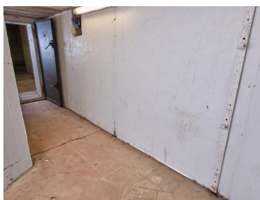
Vue du couloir d'accès de la chambre de combat nord : au fond, porte étanche ; au premier plan à droite, fixations murales pour trois couchettes tubulaires Phot. Bernard Bègne IVR53_20235600738NUCA
