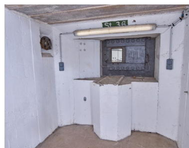
Vue de la chambre de combat nord : support d'affût de la mitrailleuse et créneau blindé ; au-dessus, cartouche avec marquage. On peut lire : St. 36. A gauche, clapet de surpression du système de ventilation. Le système d'éclairage masque le cartouche Phot. Bernard Bègne IVR53_20235600737NUCA
