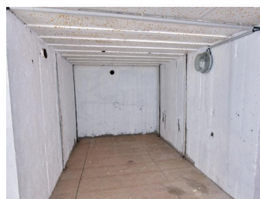
Vue du logement des soldats. Les murs et le plafond conservent les traces de fixations murales et crochets de suspension pour des couchettes tubulaires. Les entrées de tuyau servent au système de ventilation (envoi de l'air vers les chambres de combat) Phot. Bernard Bègne IVR53_20235600740NUCA
