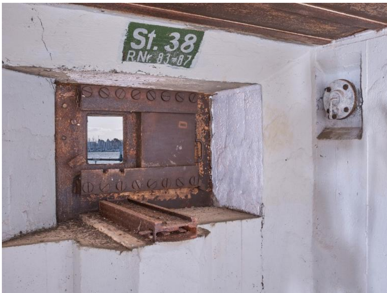
Vue de la chambre de combat sud : support d'affût de la mitrailleuse et créneau blindé. Au-dessus du poste de tir, cartouche avec marquage. On peut lire : St. 38 ; R.Nr. 83-87. A droite, clapet de surpression du système de ventilation
