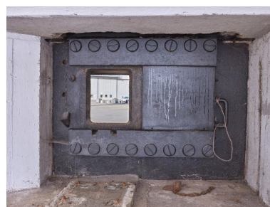
Vue de la chambre de combat nord (St. 36) : détail du créneau blindé et panorama sur le bunker KI. Le volet blindé mesure 8 cm d'épaisseur. Phot. Bernard Bègne IVR53_20235600736NUCA
