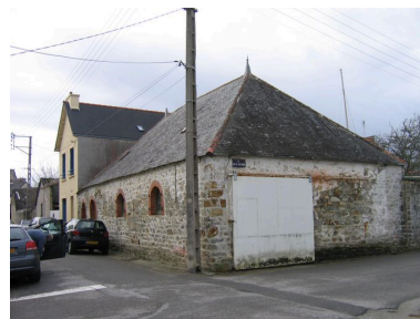
Elévation latérale de l'ancien atelier à tanner Phot. Françoise Péron IVR53_20062908353NUCA
