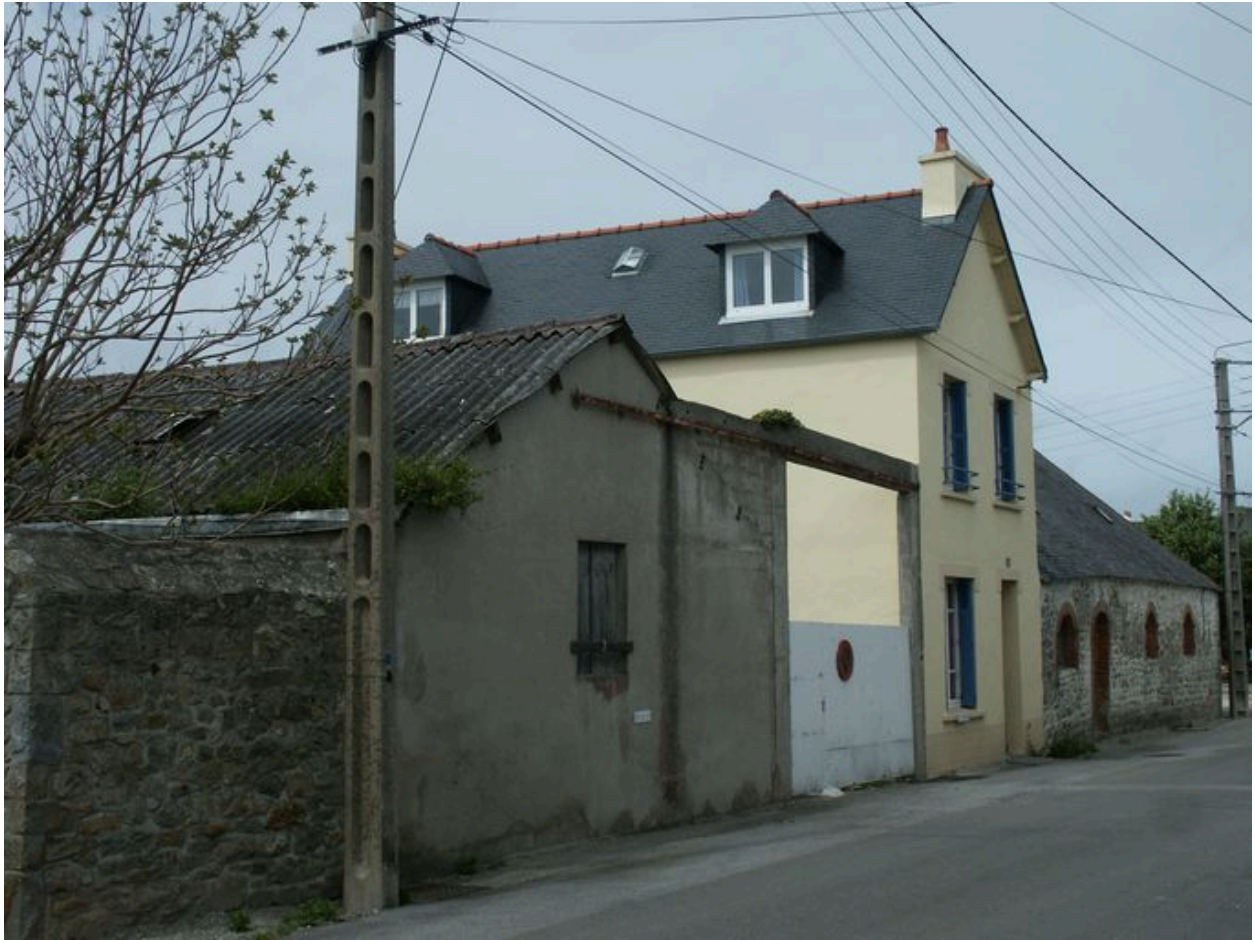
Vue d'ensemble de l'ancien atelier à tanner et maison attenante
