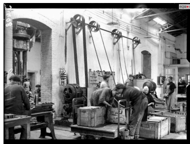
Vue intérieure d'un atelier en 1916 : mise en caisse des douilles. Cet atelier est traversé par une voie ferrée étroite, il est doté de plusieurs machines alimentées par un moteur électrique via des poulies et courroies. A gauche, la presse Saÿn-Paris de 1892 Repro. Auteur inconnu, Phot. Victor Dietsch IVR53_20252910288NUC
