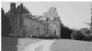
Château : élévation ouest (état en 1969) Phot. Jean-Pierre Ducouret IVR53_20115601299Z
