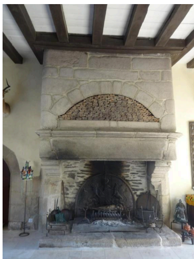
Cheminée de la grande salle (partie basse), détail Phot. Michèle Bureau IVR53_20265610764NUCA
