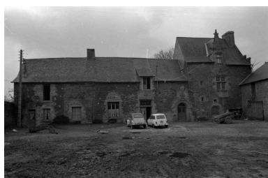
Vue générale du logis Phot. Berthou Marie, Phot. Catherine Toscer IVR53_19765605890Z
