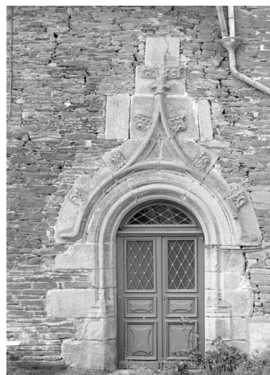
Détail de la porte. Phot. Jean-Pierre Ducouret IVR53_19845601895X
