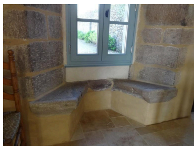
Fenêtre à coussièges à l'est (partie basse), détail Phot. Michèle Bureau IVR53_20265610766NUCA
