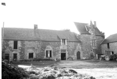
Vue générale du logis Phot. Gaussen IVR53_19675605152Z
