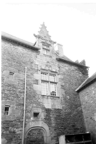
Vue rapprochée de l'élévation droite du logis Phot. Gaussen IVR53_19675605151Z
