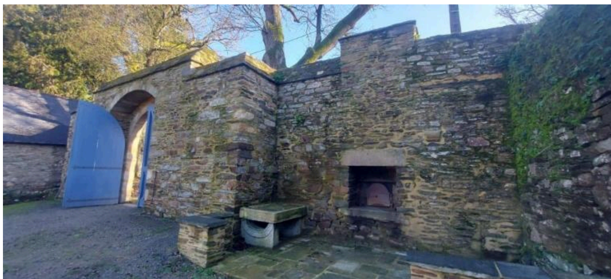
Porte charretière et four à pain, vue ouest
