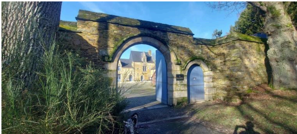
Porte charretière et porte piétonne, vue est
