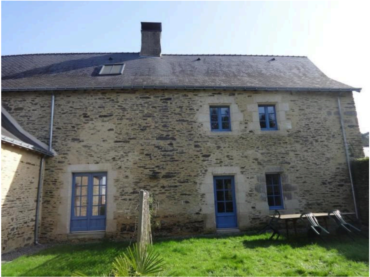
Partie basse avec les ouvertures créées en 2018, détail, élévation ouest
