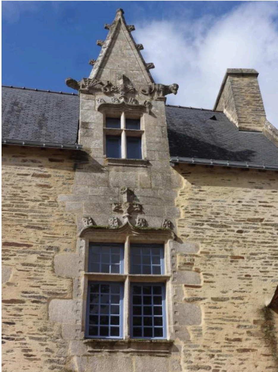
Lucarne et fenêtre d'origine, détail, élévation est
