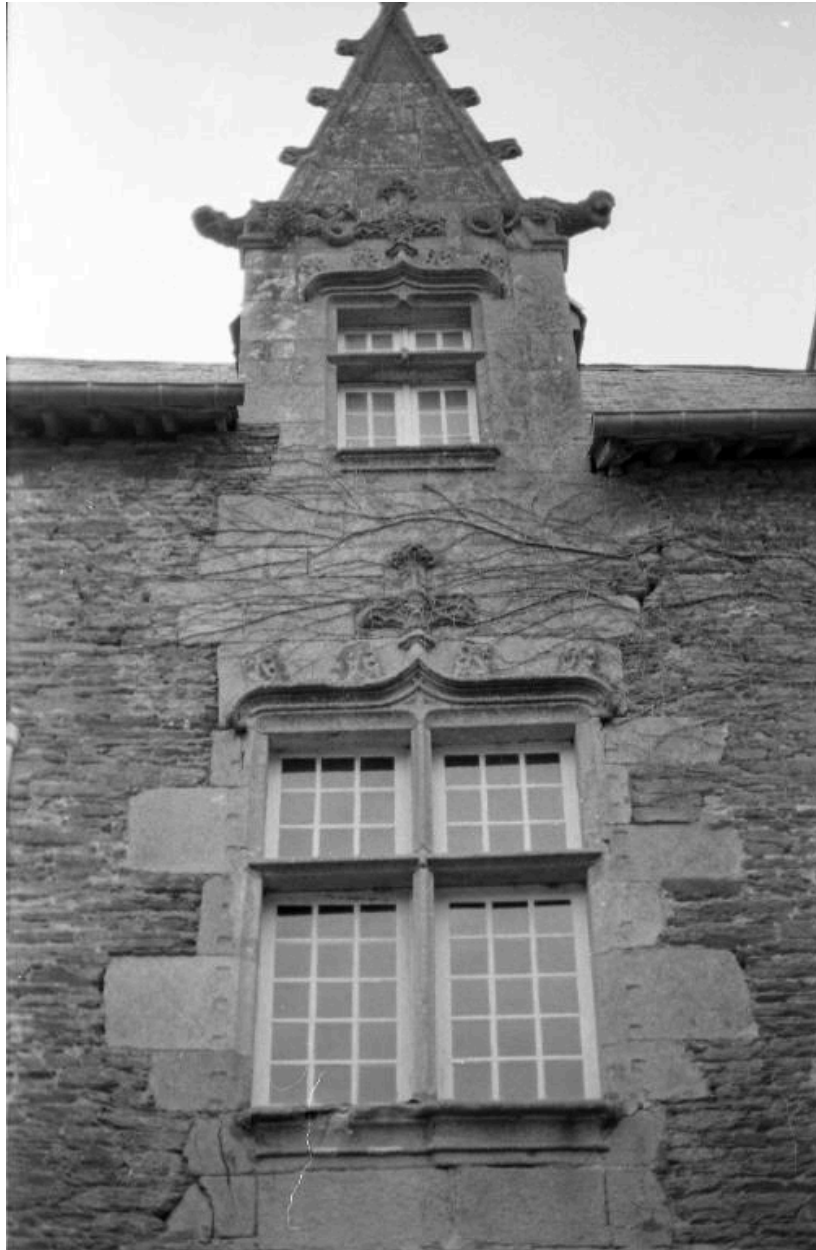
Détail de deux lucarnes à droite du logis
