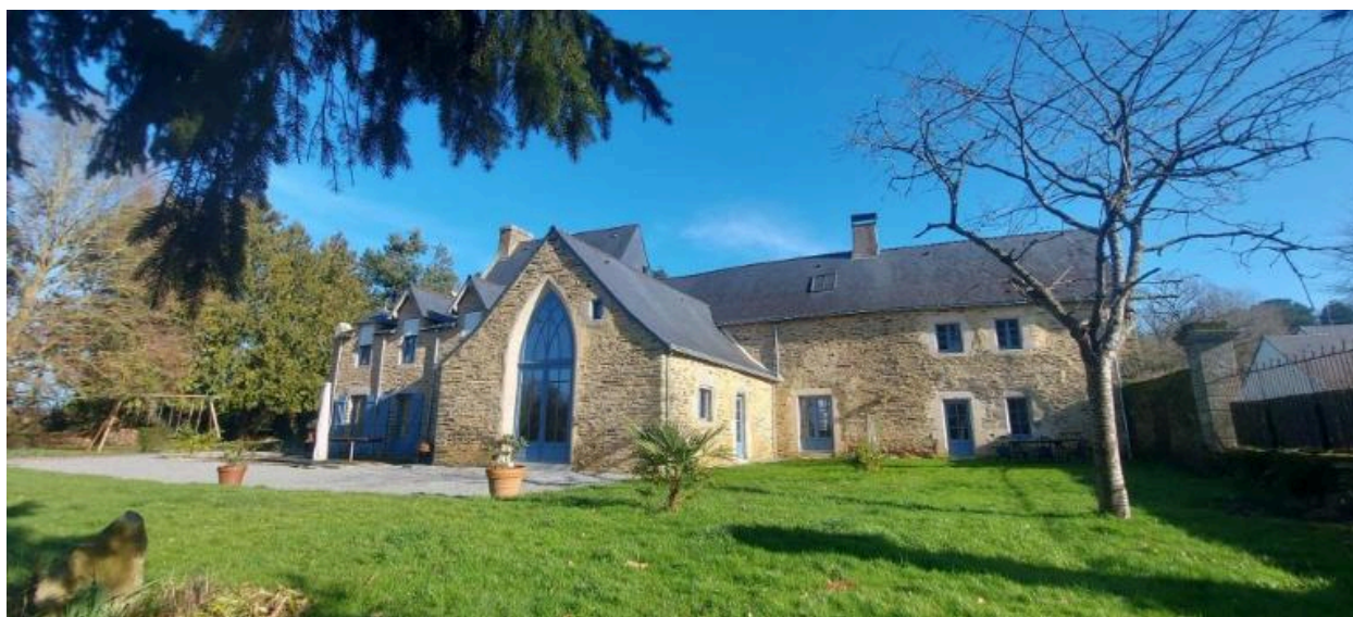
Façade ouest, vue générale
