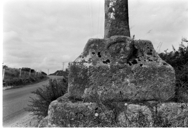
Détail de la face est du socle Phot. Didier Cadiou IVR53_19672200246Z
