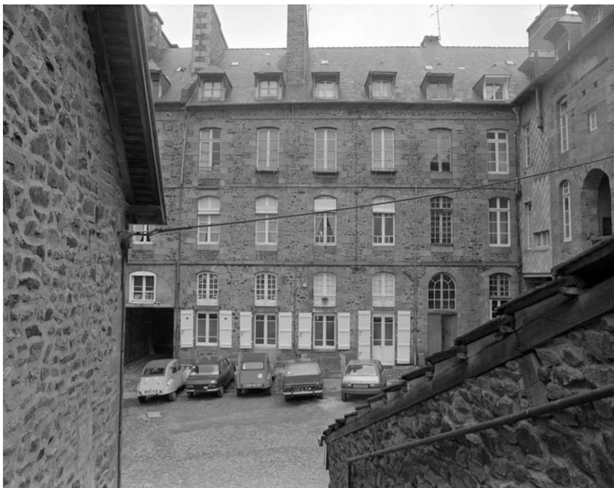
Elévation postérieure, corps principal, vue générale.
