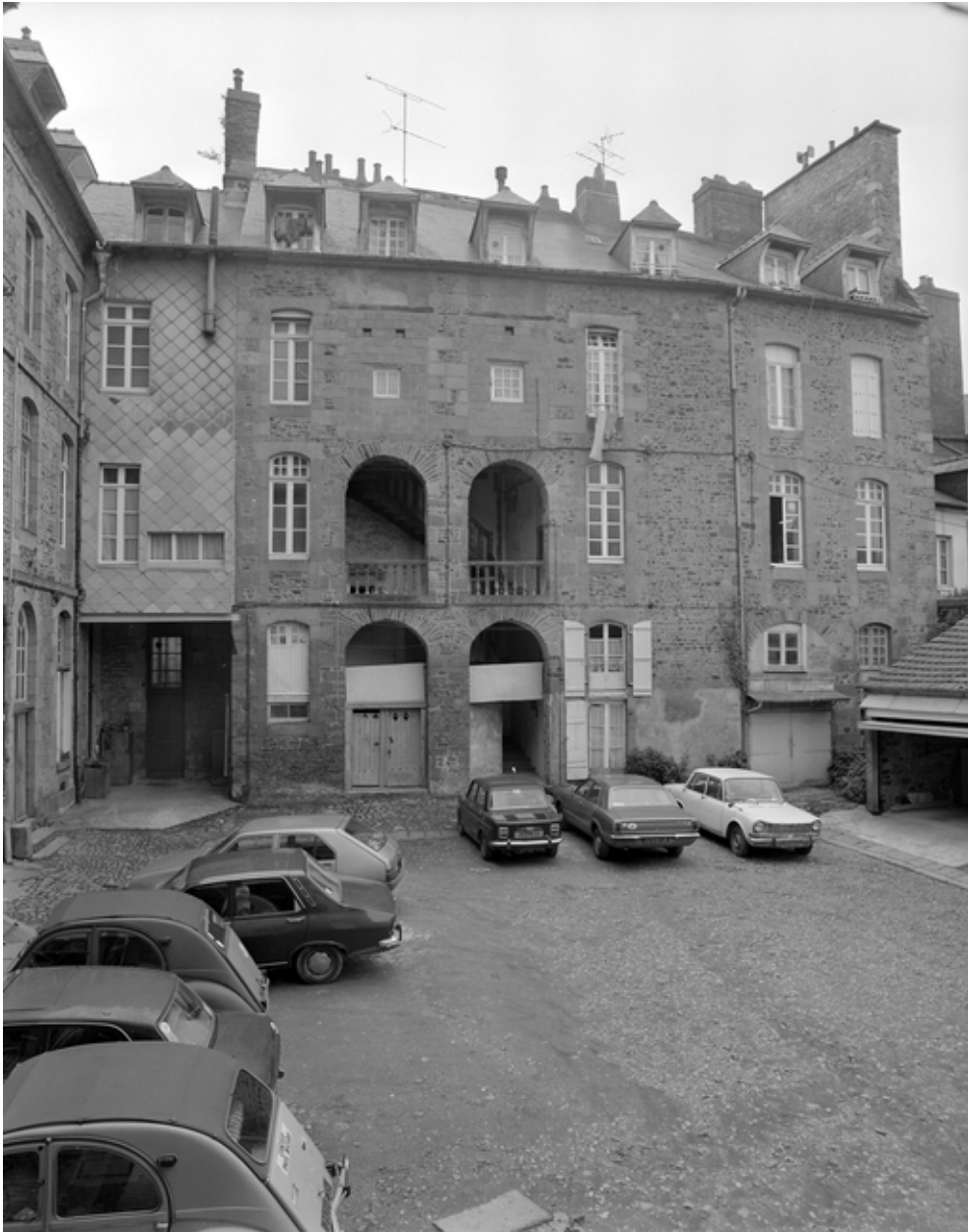
Elévation postérieure, corps latéral, vue générale.
