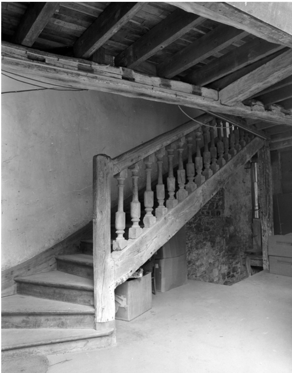
Escalier du corps latéral droit, vue générale.
