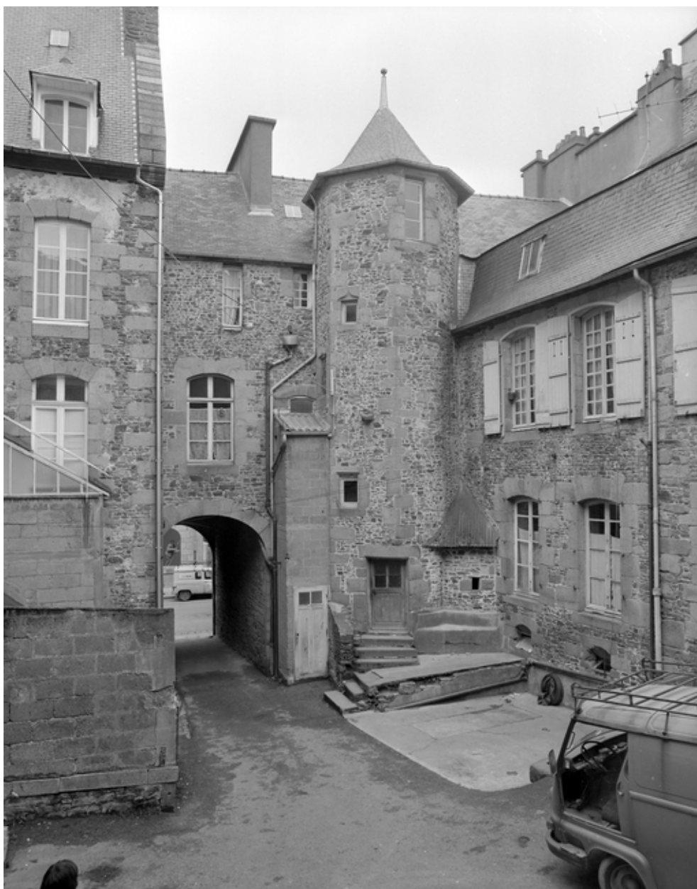
Escalier du corps latéral gauche, vue générale.
