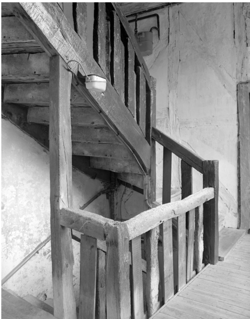
Escalier de l'aile gauche, vue générale.
