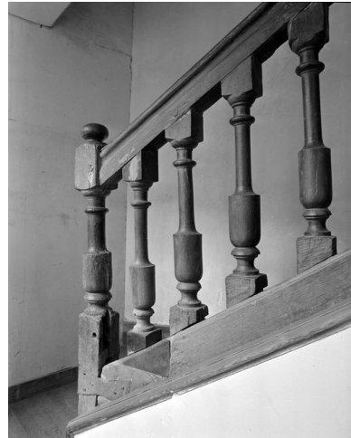
Escalier du corps latéral droit, vue de détail de la rampe. Phot. Guy Artur IVR53_19783500234X
