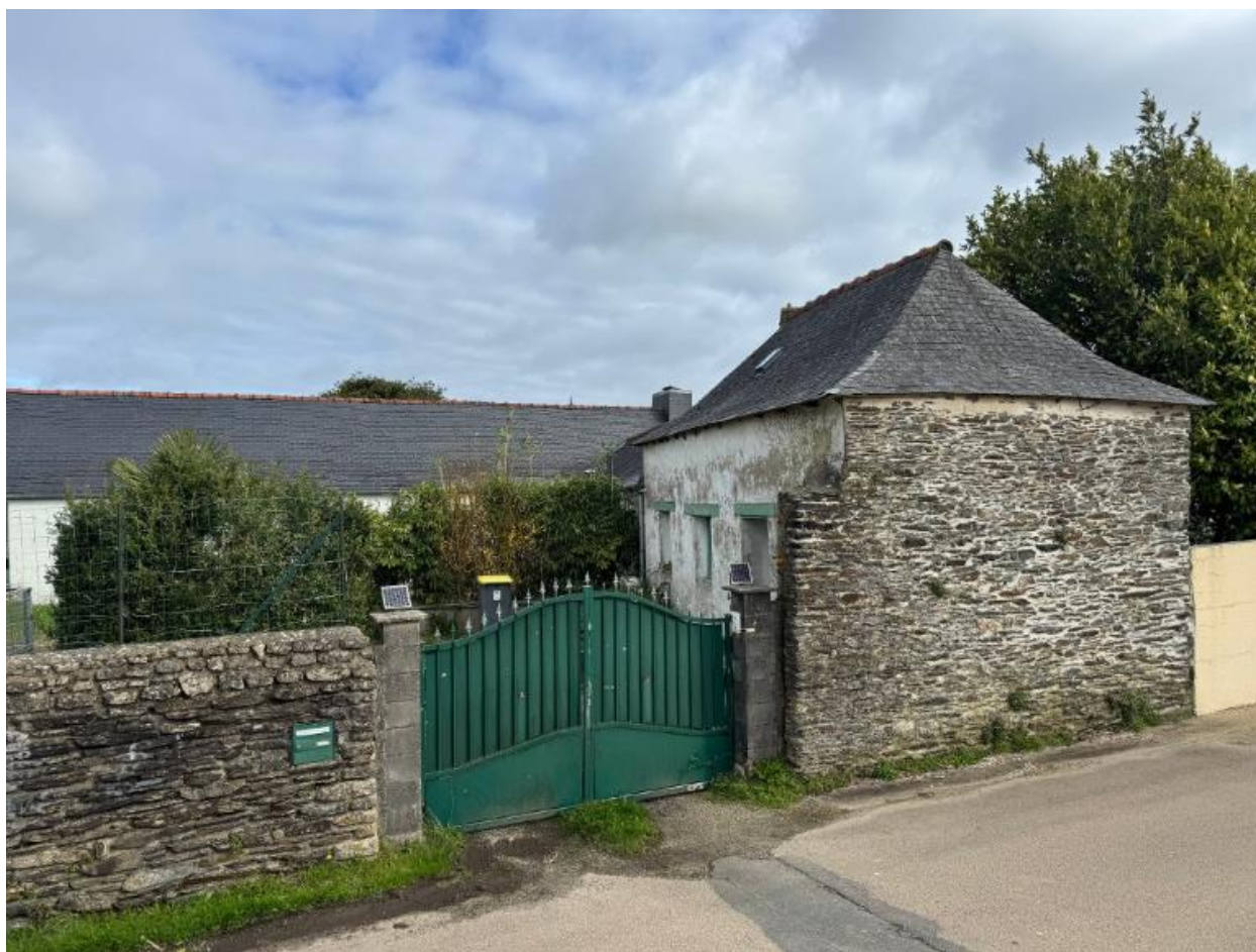
Maison du contremaître. Vue générale
