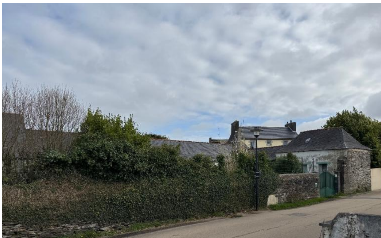
Atelier de tissage et maison du contremaître. Vue générale sud-ouest
