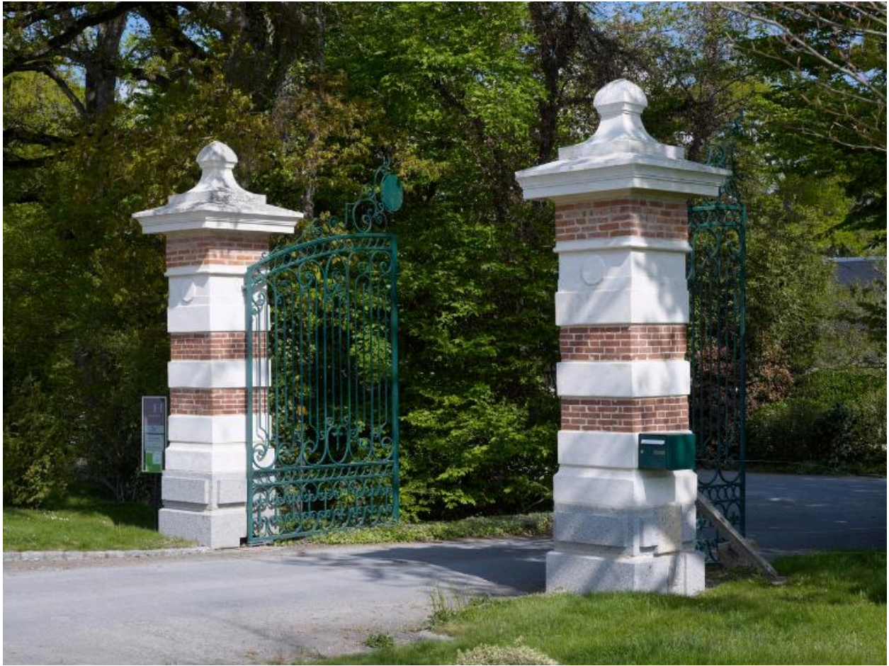
Portail et grille d'entrée du château
