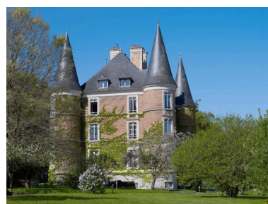
Vue générale façade est Phot. Bernard Bègne IVR53_20173500403NUCA
