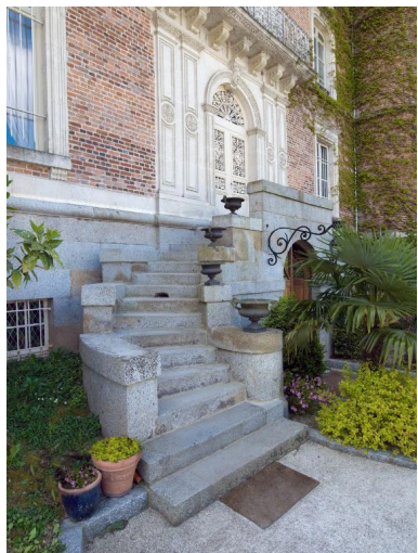
Détail de l'escalier de la façade nord Phot. Bernard Bègne IVR53_20173500427NUCA
