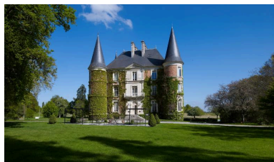
Vue générale de la façade sud Phot. Bernard Bègne IVR53_20173500408NUCA
