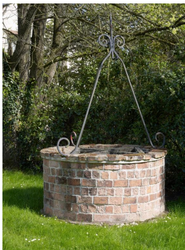
Puits en briques entre le château et les anciennes écuries Phot. Bernard Bègne IVR53_20173500431NUCA
