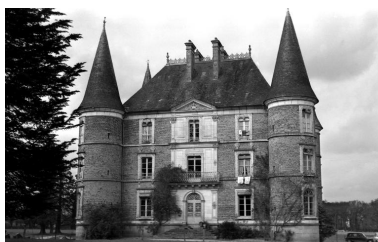
château d'Apigné – vue générale façade sud Phot. Sylvie Laffiché, Phot. Marie-Madeleine Tugores IVR53_19753506105Z
