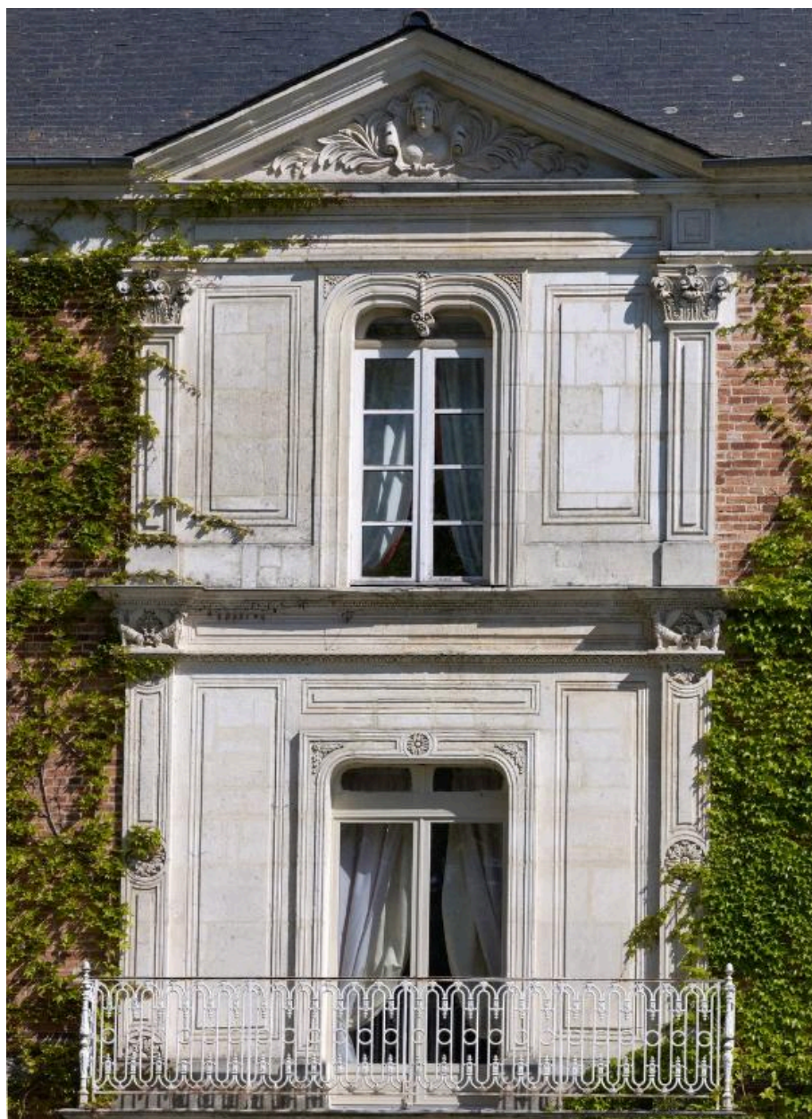
Façade sud, détail de la travée centrale
