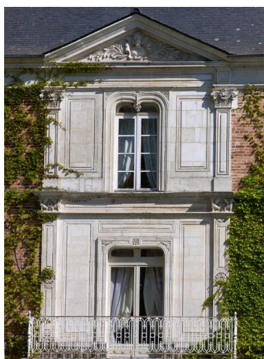
Façade sud, détail de la travée centrale Phot. Bernard Bègne IVR53_20173500415NUCA
