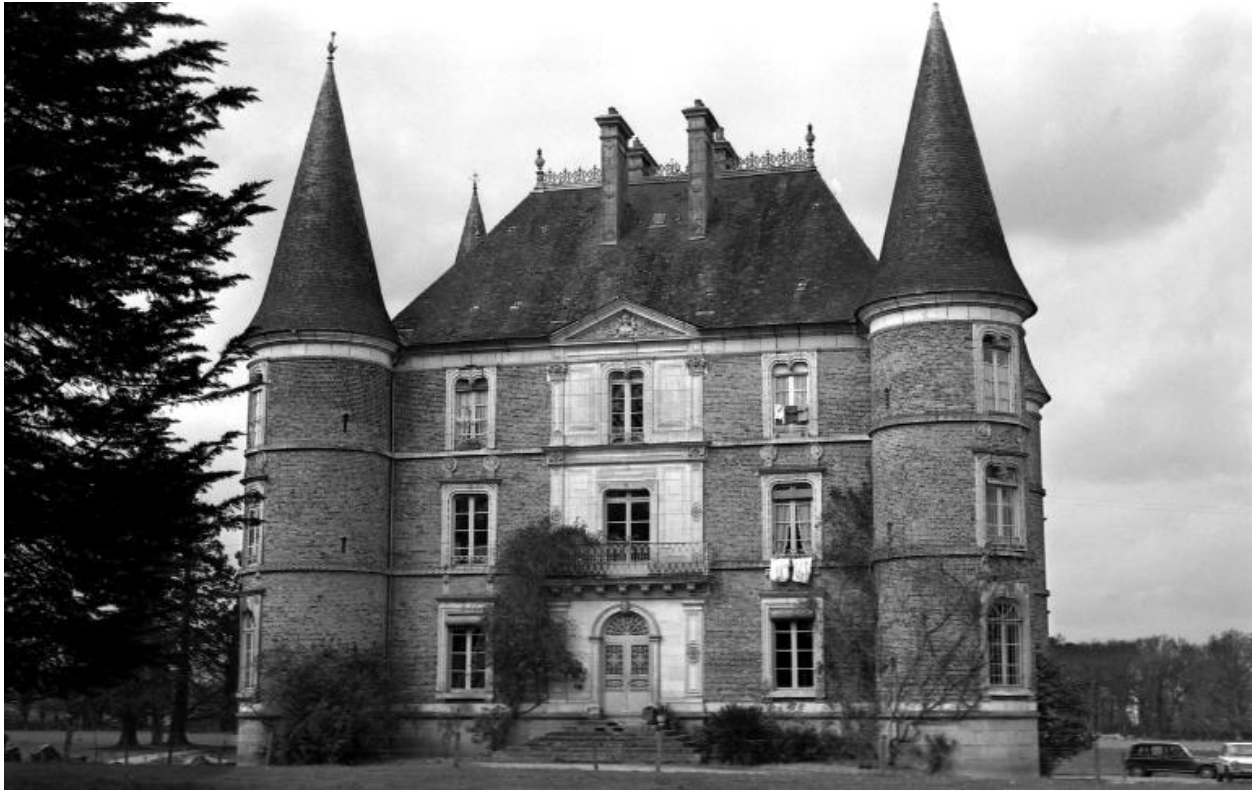
château d'Apigné – vue générale façade sud
