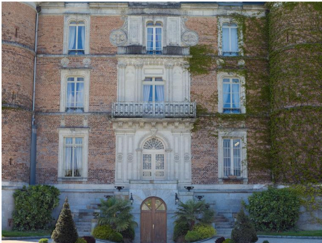
Vue rapprochée de la façade nord
