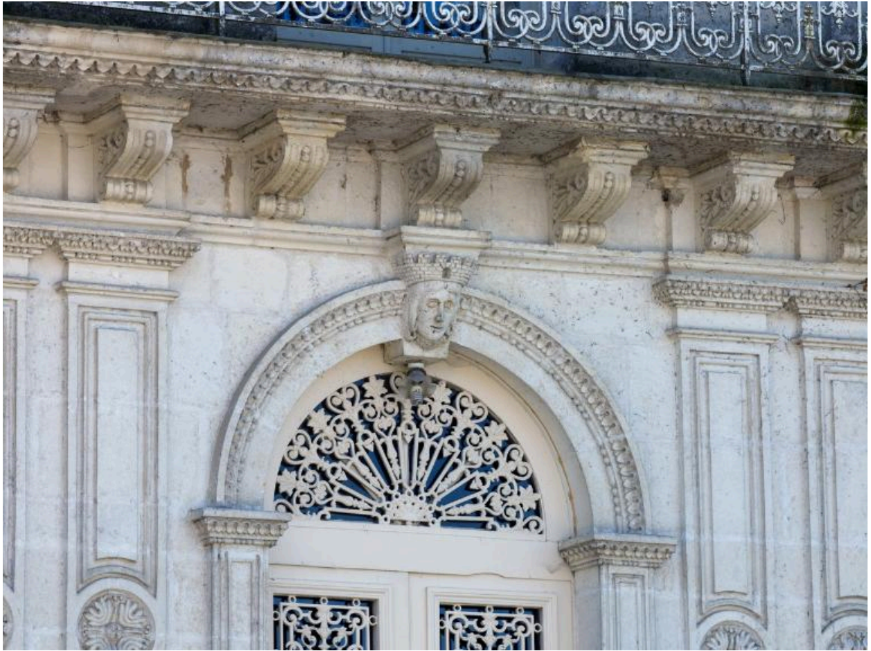
Façade sud, détail sur la porte d'entrée
