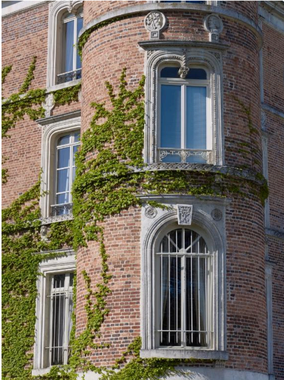
Détail de la tour formant l'angle
