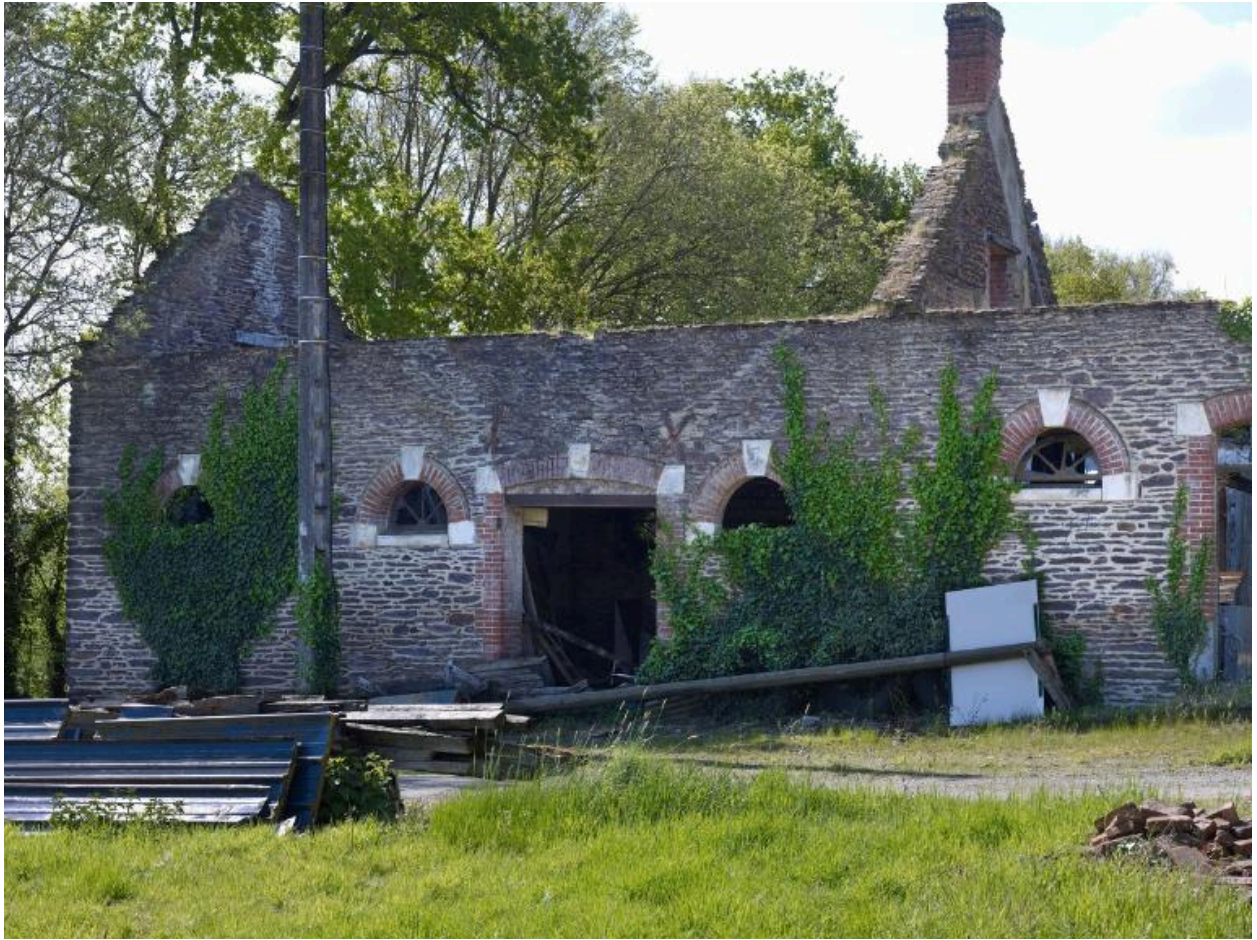
Anciennes écuries du château
