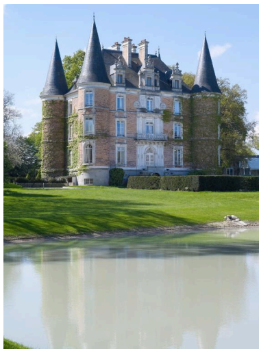
Vue biaisée de la façade nord Phot. Bernard Bègne IVR53_20173500420NUCA
