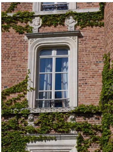
Détail d'une baie Phot. Bernard Bègne IVR53_20173500405NUCA
