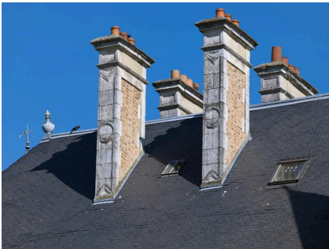
Souches de cheminée
