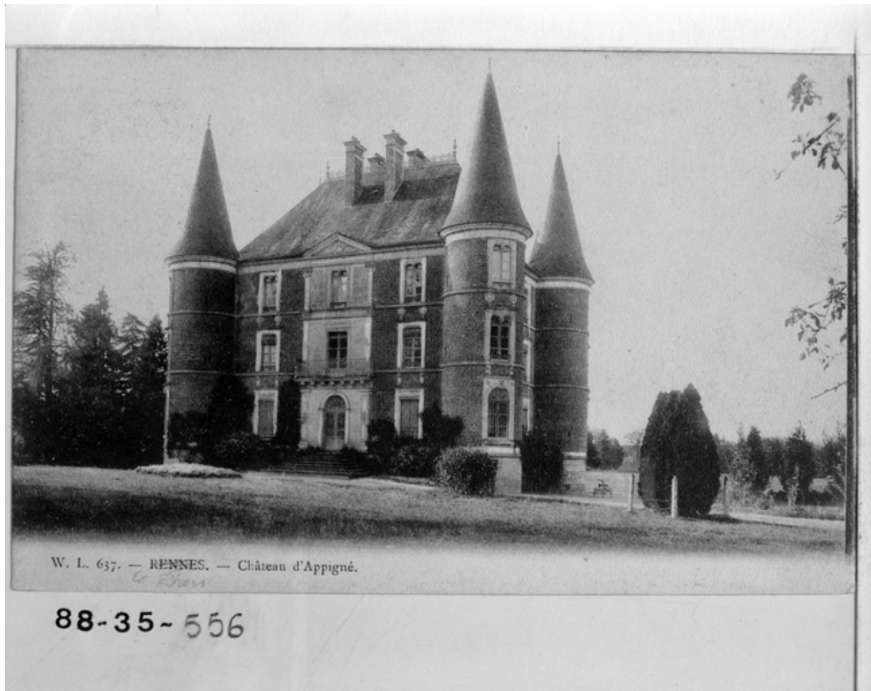
Vue générale façade sud
