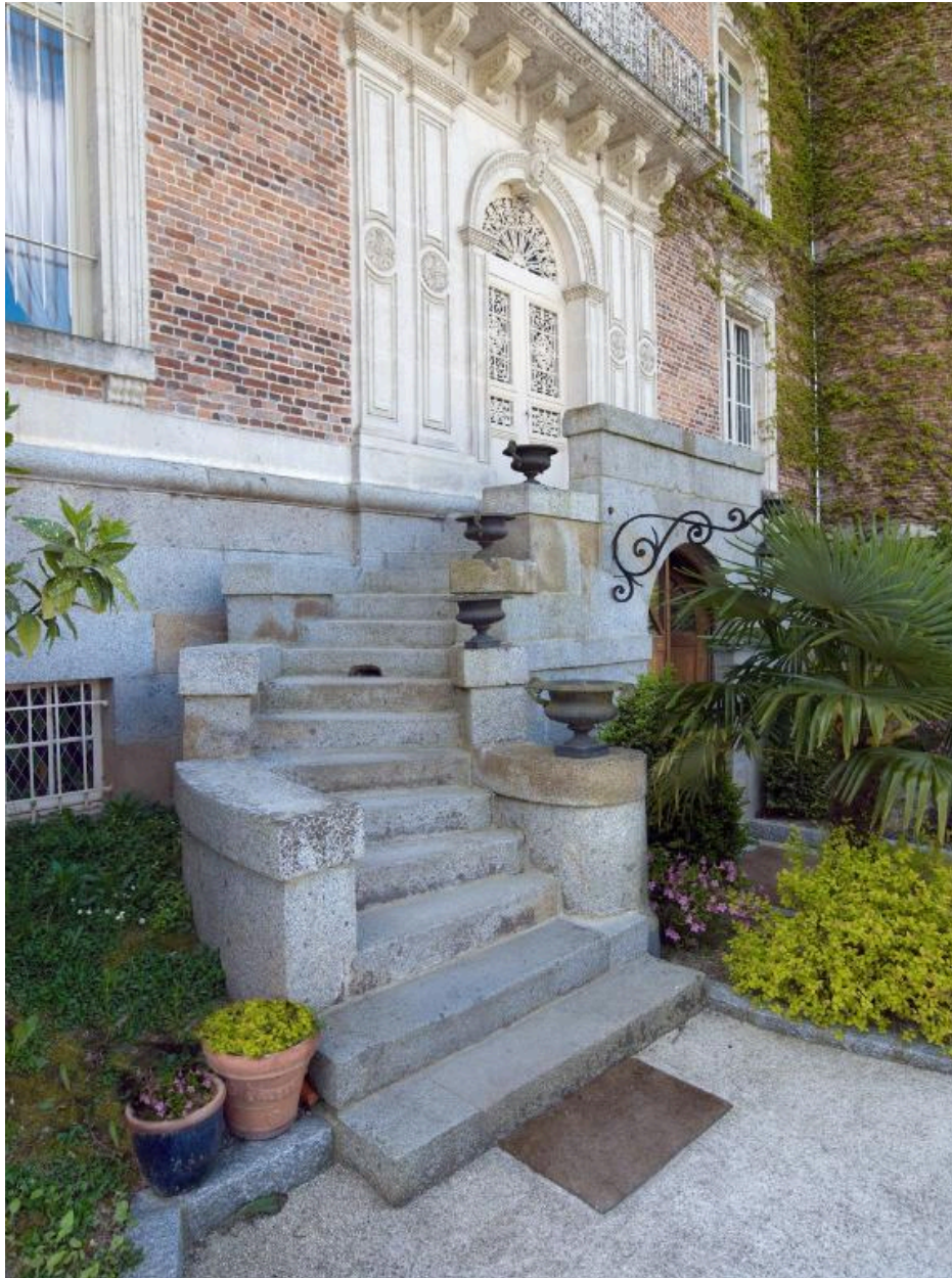
Détail de l'escalier de la façade nord
