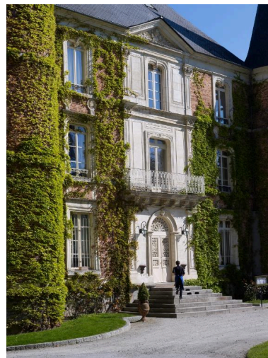
Vue biaisée de la façade sud Phot. Bernard Bègne IVR53_20173500410NUCA
