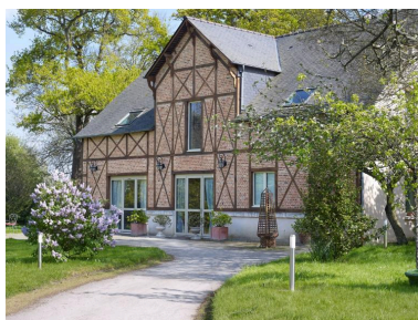
Anciennes écuries en pan de bois et brique Phot. Bernard Bègne IVR53_20173500418NUCA
