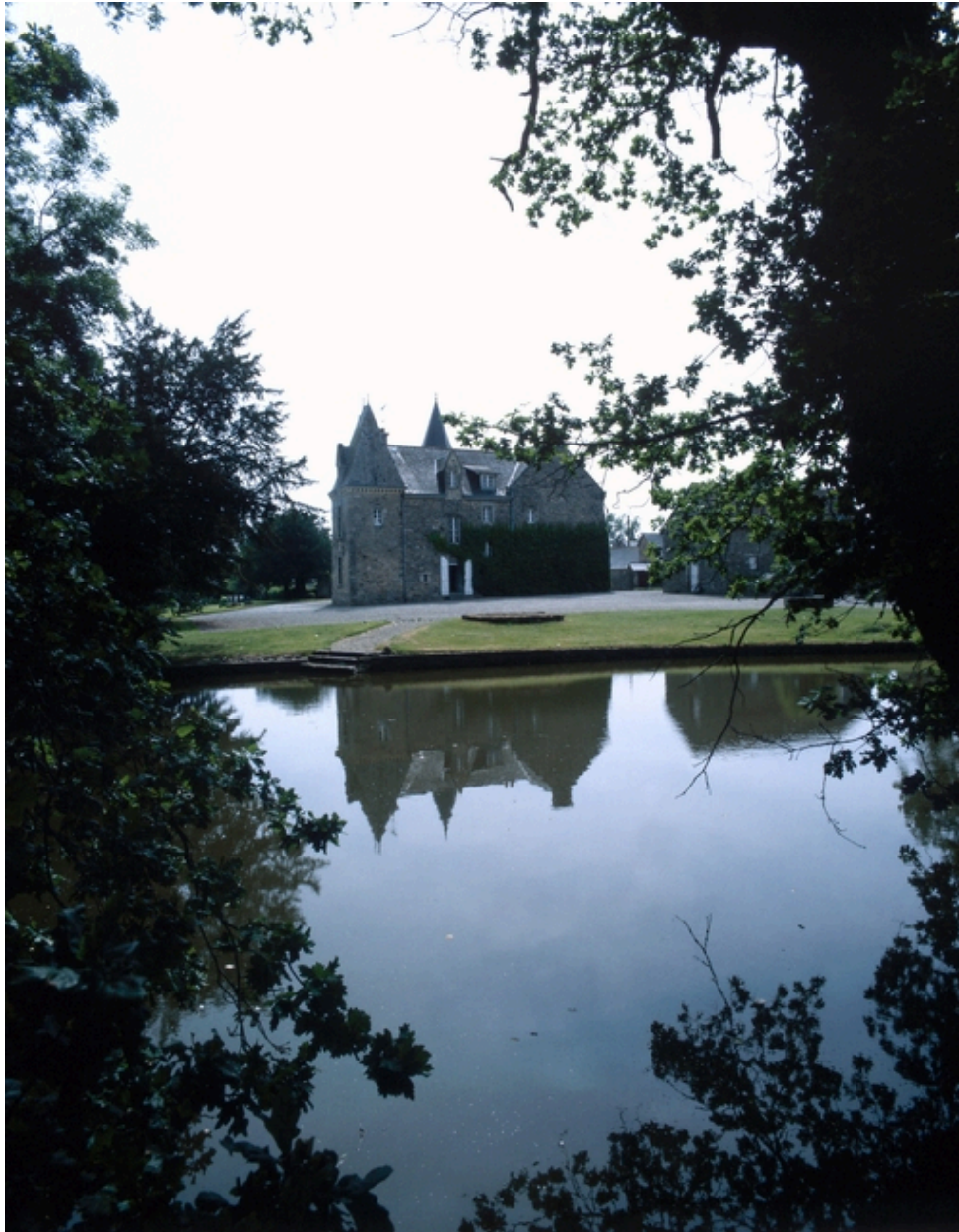
Logis, élévation ouest.
