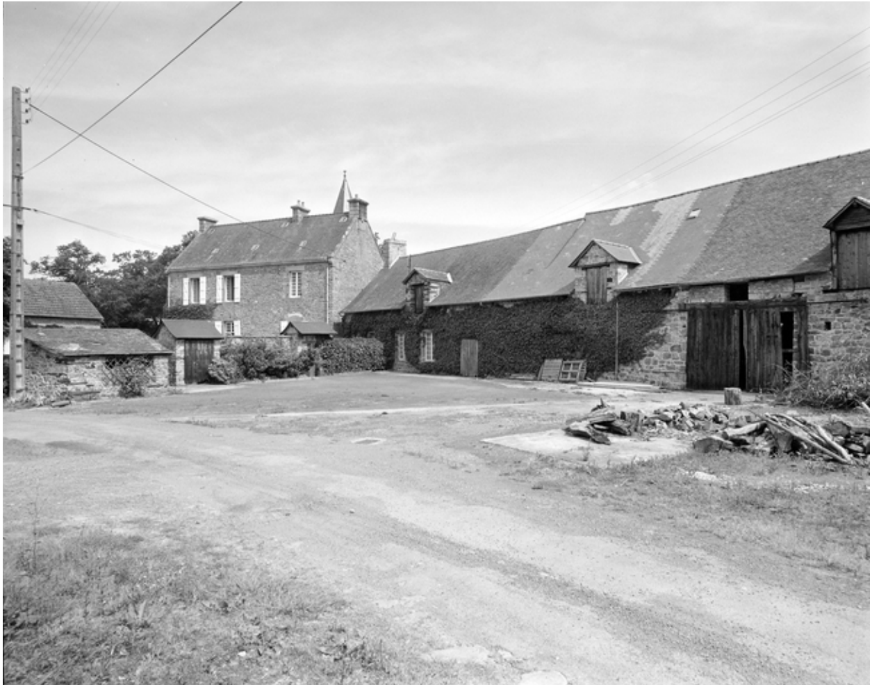
Vue générale depuis la première cour.
