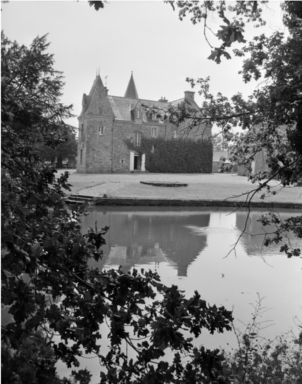
Logis, élévation ouest.
