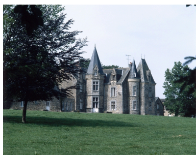
Logis, élévation nord-ouest. Phot. Guy Artur, Phot. Norbert Lambart IVR53_19973500766XA
