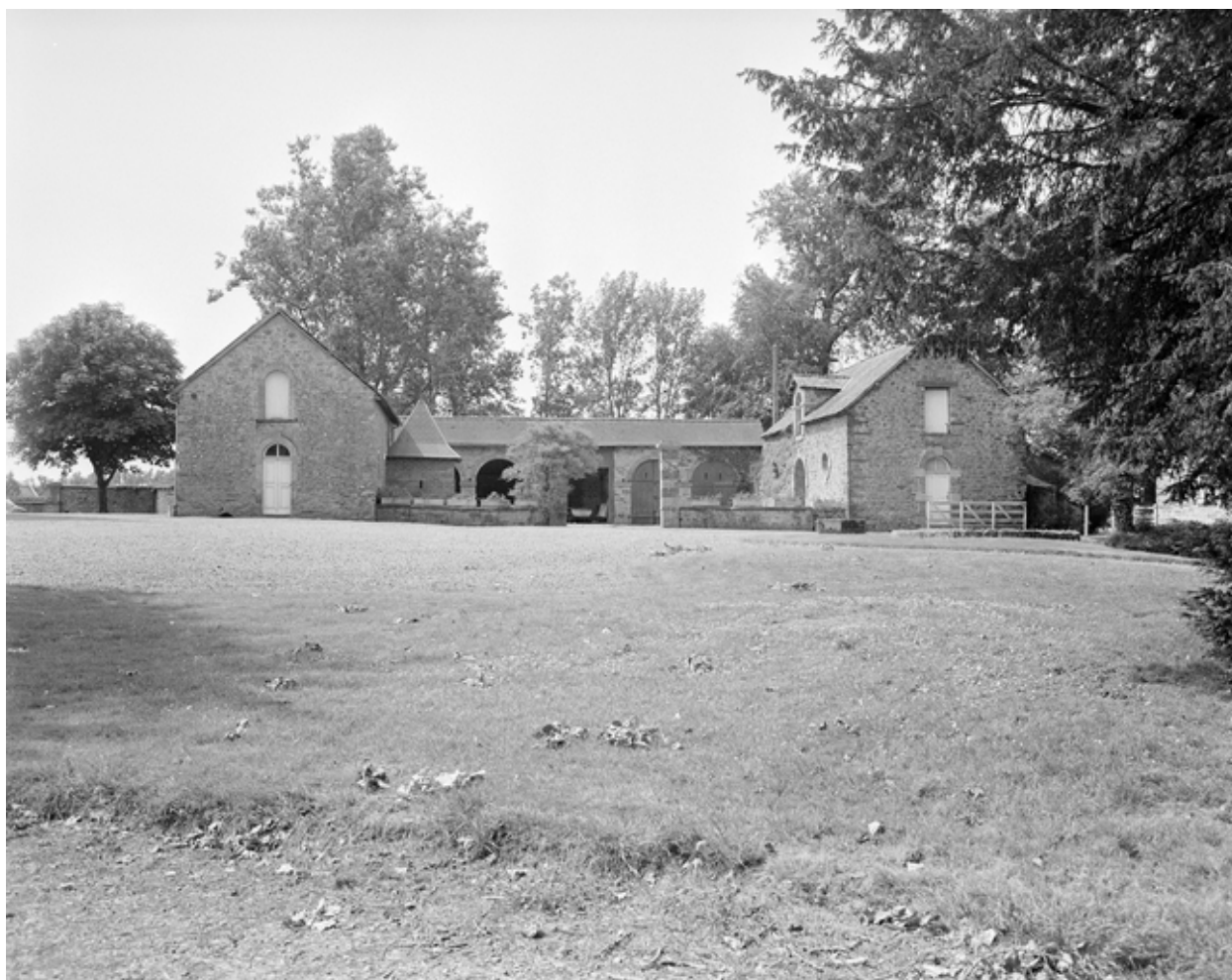
Vue générale des communs.
