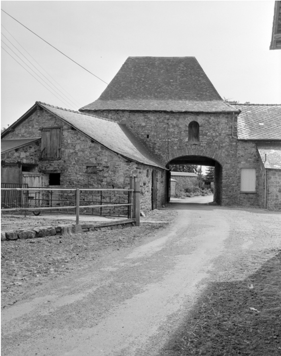
Vue générale du porche, côté chemin.
