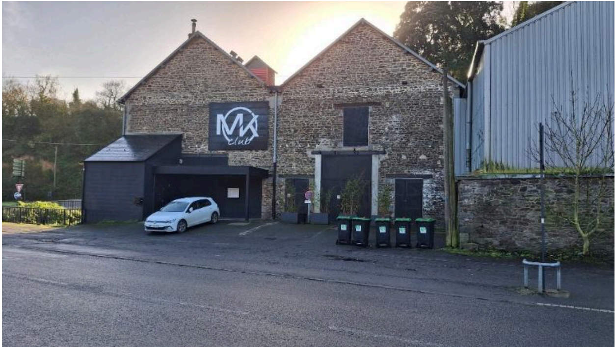
Ancien hangar industriel, actuellement magasin de commerce : élévation nord
