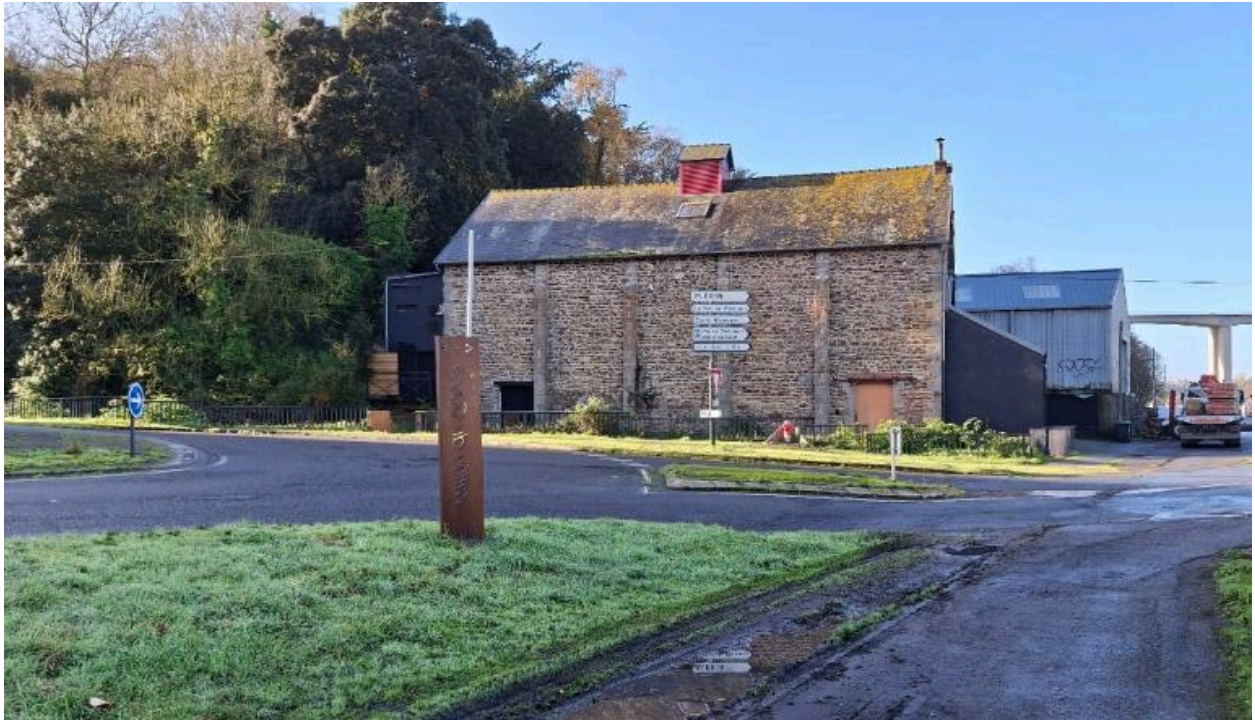
Ancien hangar industriel, élévation est : vue de situation depuis le rond-point du boulevard de la mer
