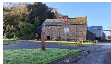
Ancien hangar industriel, élévation est : vue de situation depuis le rond-point du boulevard de la mer Phot. Erwana L'Haridon IVR53_20262210027NUCA
