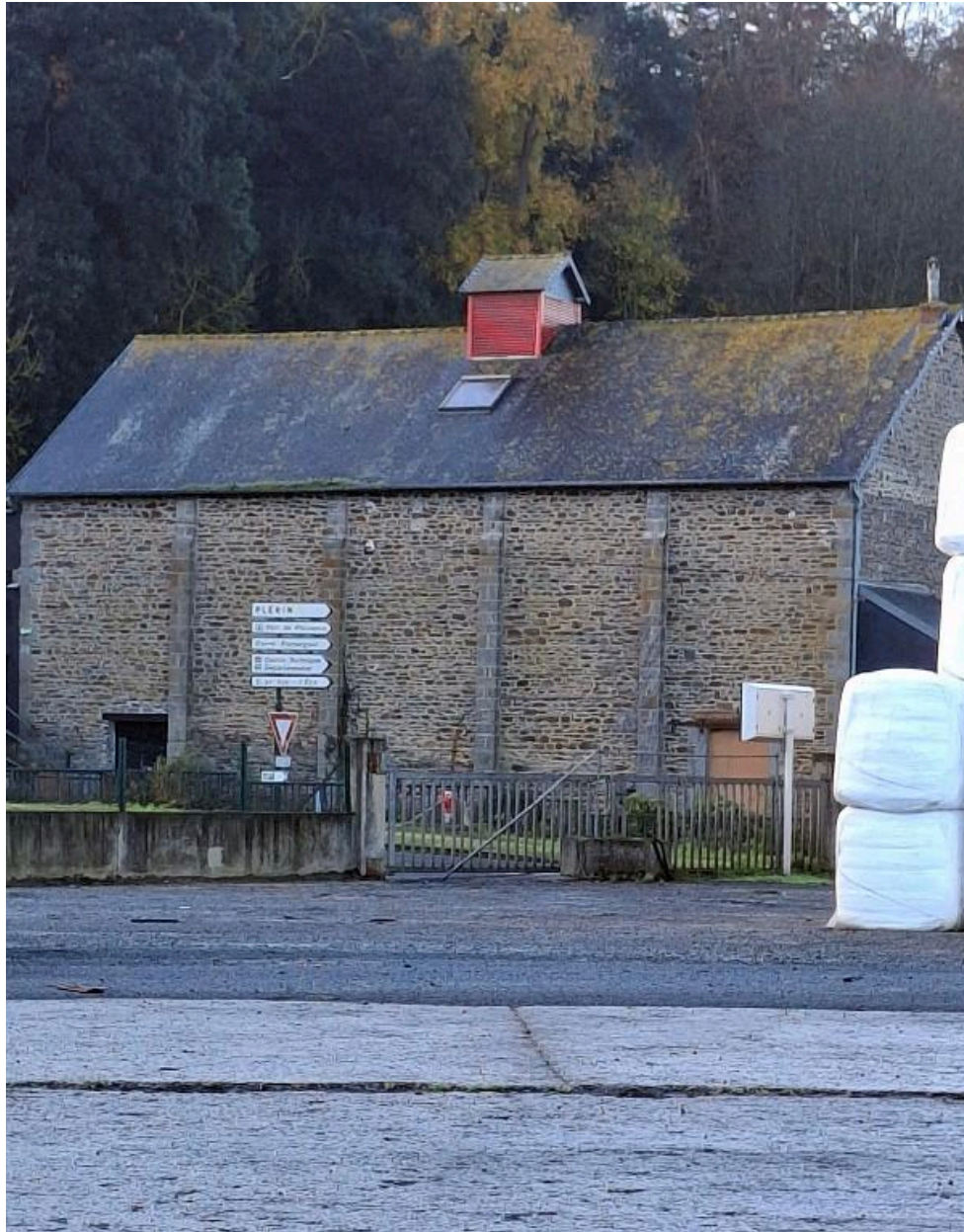
Ancien hangar industriel, élévation est, depuis le bassin à flot
