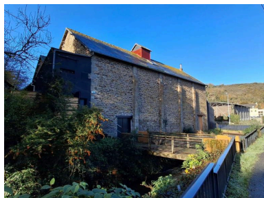
Ancien grenier à blé, élévation est, passerelle enjambant le Gouëdic créée en 1999 (sortie de secours d'un établissement recevant du public)
