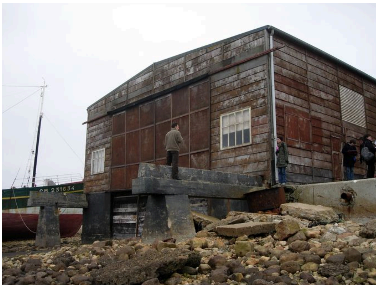
Vue de l'atelier de chantier naval des CMC depuis la mer
