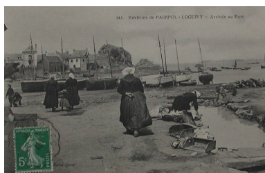
Le lavoir du port vers 1920 (collection particulière) Phot. Guy Prigent, Phot. Auteur inconnu IVR53_20082207403NUCB
