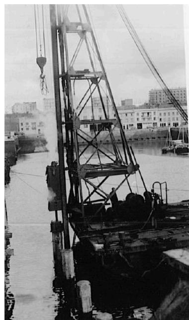
Photographie de suivi de chantier (1956) : installation des pieux par grue sur barge
