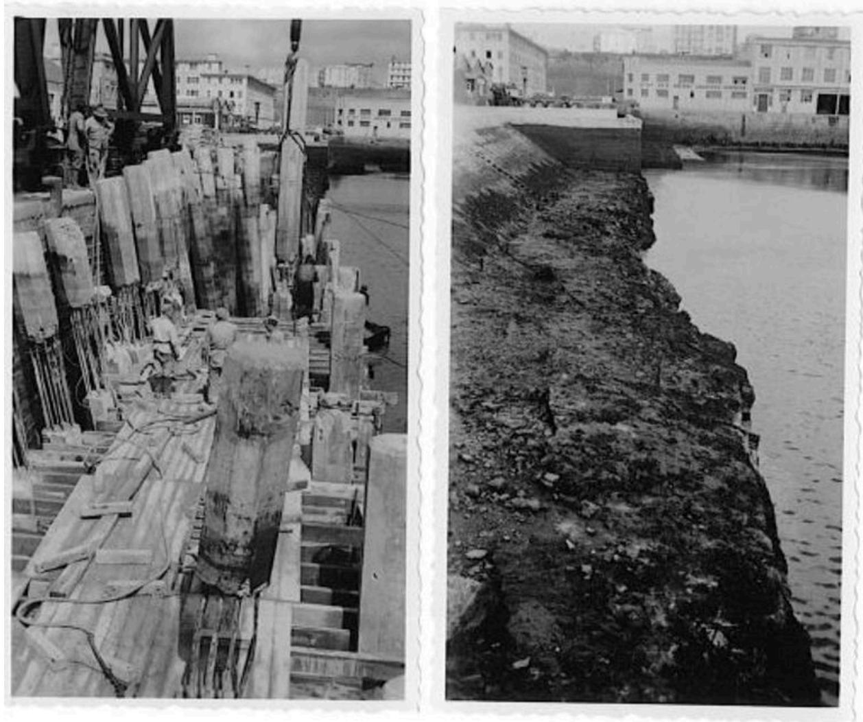
Photographies de suivi de chantier : perré provisoire (1945) et arase du quai de 1860 ; pieux en béton et ferrailage (1956)
