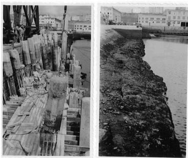
Photographies de suivi de chantier : perré provisoire (1945) et arase du quai de 1860 ; pieux en béton et ferrailage (1956)
