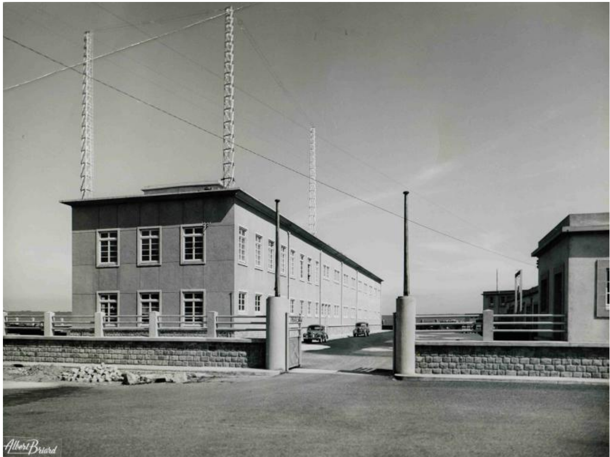
Elévation nord et ouest du nouveau bâtiment des phares et balises. Photographe Albert Briard (1954)
