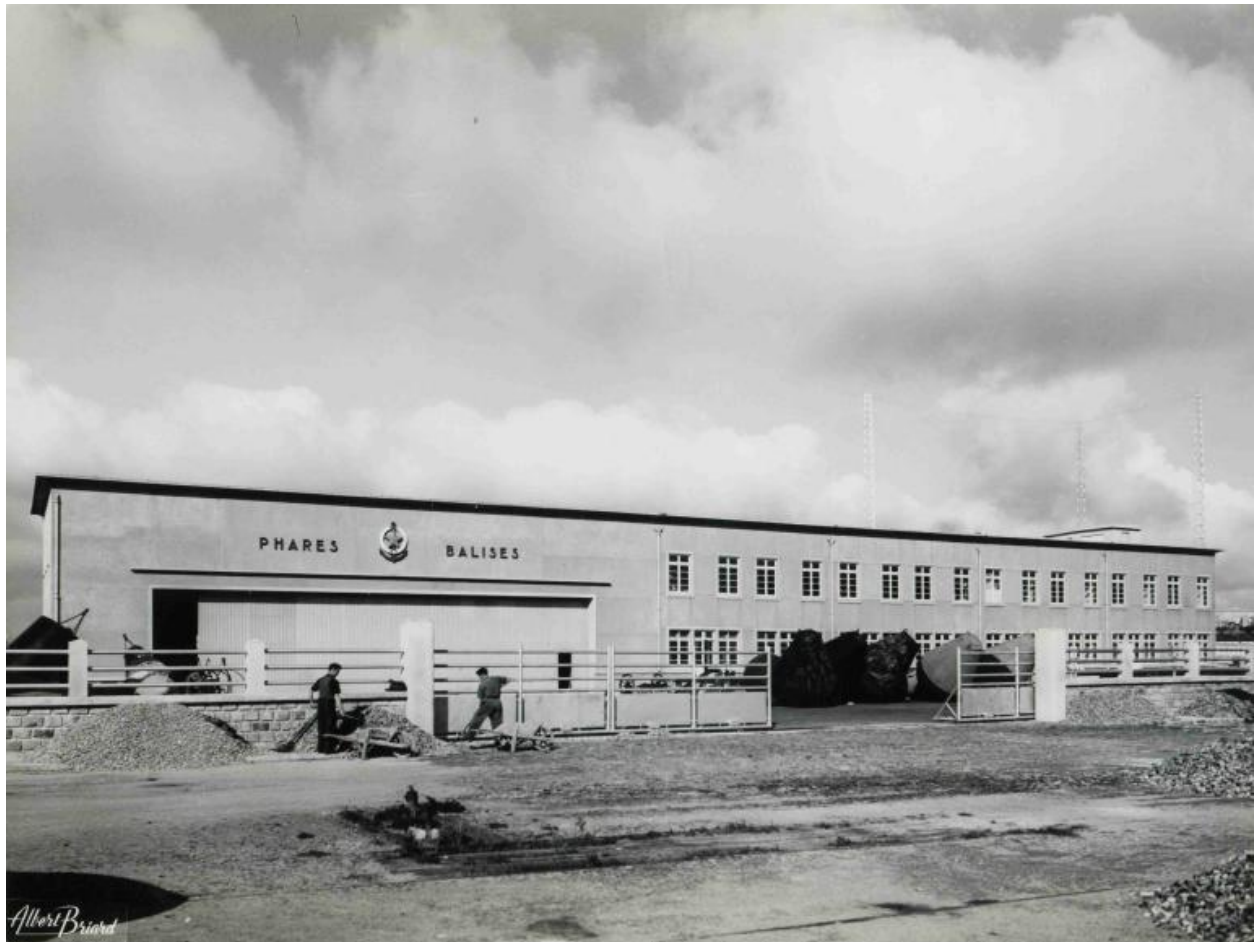
Bâtiment des Phares et Balises, la fin des travaux (1954)
