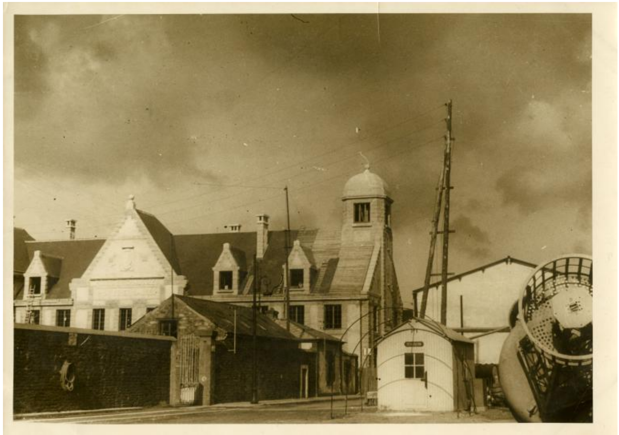
Le bâtiments des Ponts et Chaussées en cours de construction (La dépêche de Brest, 30/09/1938)
