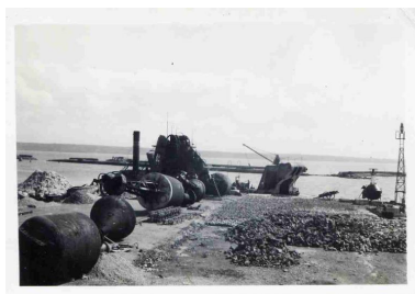
Travaux de nivellement du Parc (3/08/1947) Phot. Etat IVR53_20232906070NUCB
