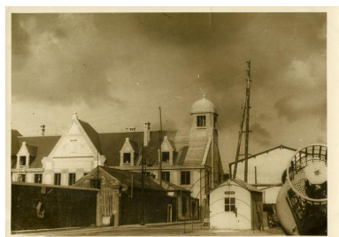
Le bâtiments des Ponts et Chaussées en cours de construction (La dépêche de Brest, 30/09/1938) Phot. La dépêche de Brest IVR53_20232905828NUCB
