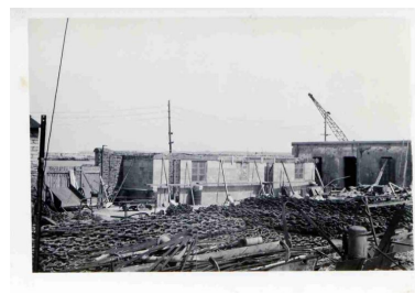
Construction des bureaux et vestiaires provisoires du Parc à balisage (06/1947) Phot. Etat IVR53_20232906074NUCB
