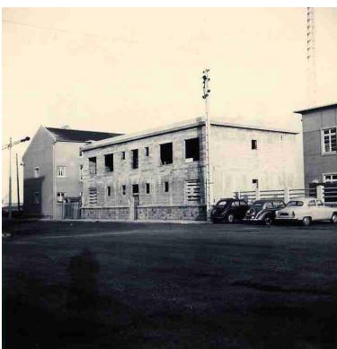
Logement des mécaniciens stagiaires, élévation nord, en cours de construction (10/05/1956) Phot. Etat IVR53_20232906078NUCB
