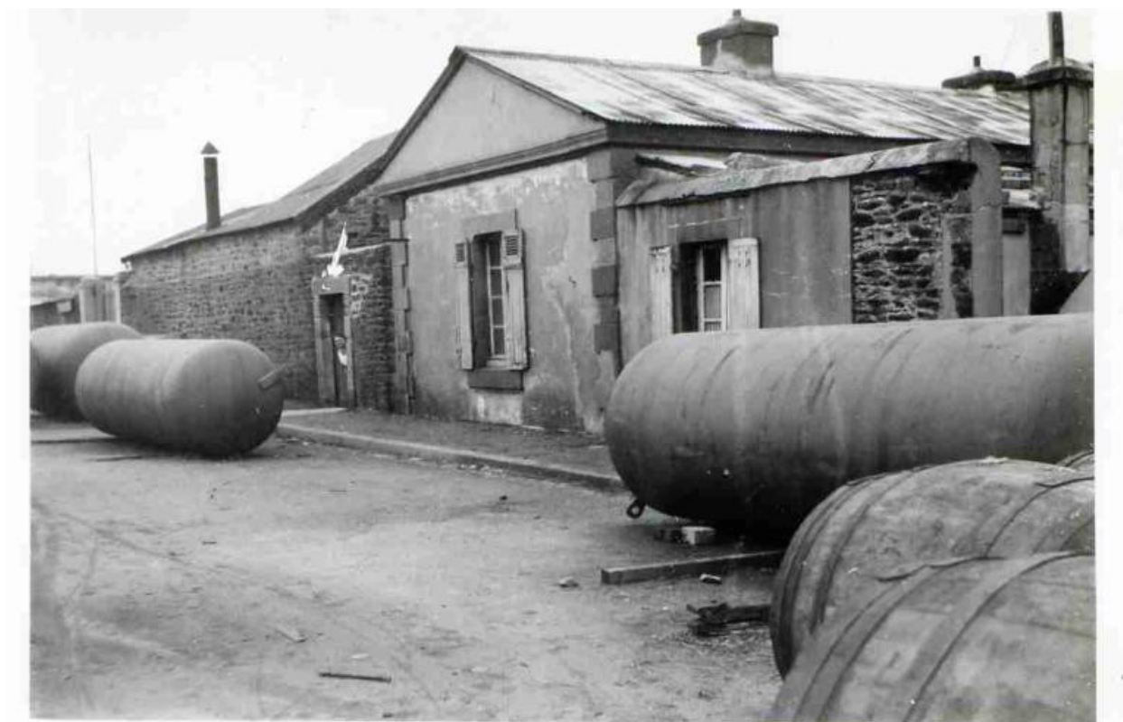
Vestiges des bâtiments antérieurs à la Seconde Guerre mondiale détruits lors de la reconstruction du site
