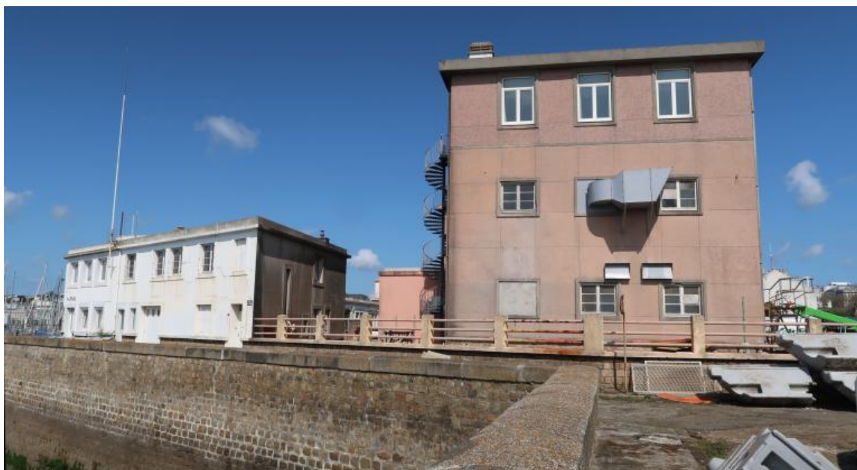
Elévations sud des bâtiments du site des Phares et Balises et pilotage
