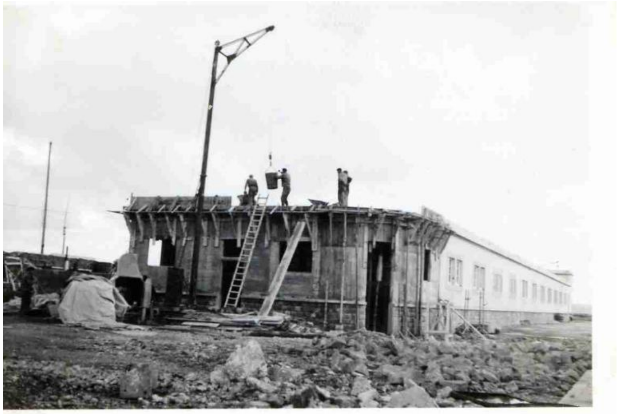
Construction du poste de transformateur en 1951
