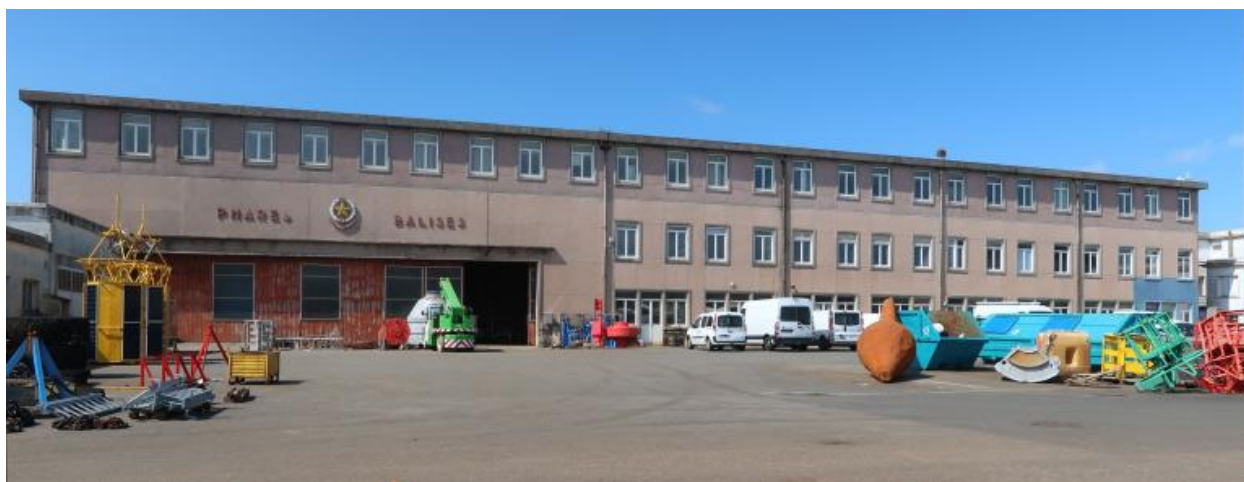
Bâtiment principal des Phares et Balises
