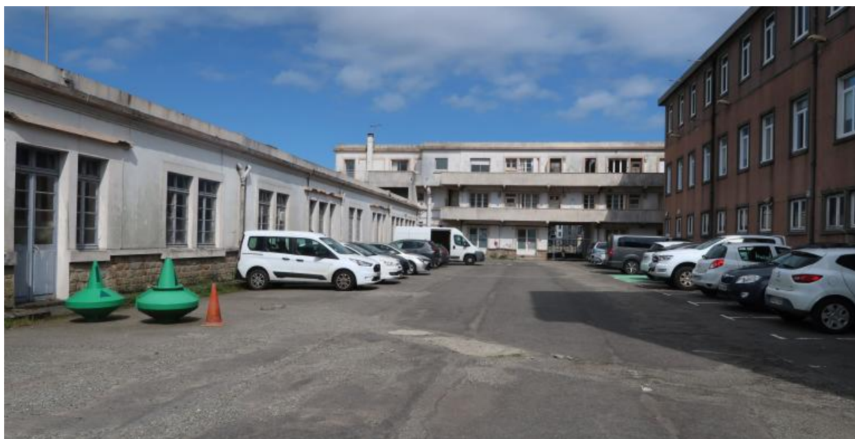
Cour entre les 3 bâtiments : ateliers, logements et bureaux
