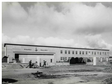
Bâtiment des Phares et Balises, la fin des travaux (1954) Phot. Albert Briard IVR53_20232906086NUCB
