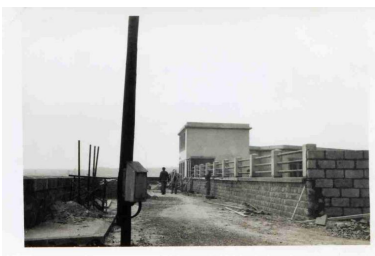
Clôture sud du Parc en mai 1950 Phot. Etat IVR53_20232906081NUCB
