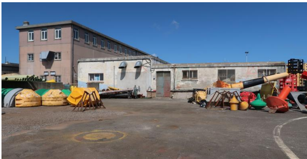
Parc à bouées, façades sud des bâtiments (bureaux ; atelier peinture)
