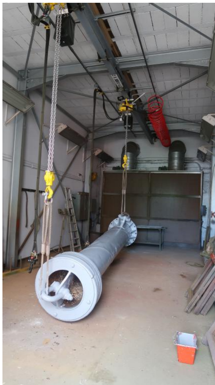
Intérieur d'un bâtiment atelier : travail en cours
