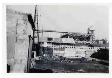
Fondations de l'atelier de mécanique (06/1947) Phot. Etat IVR53_20232906071NUCB
