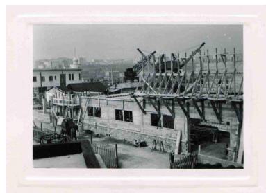
Construction du bâtiment, élévation ouest (19/03/1953) Phot. Etat IVR53_20232906077NUCB
