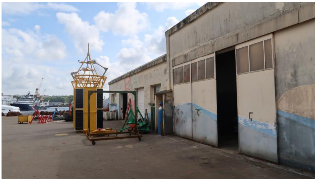
Bâtiment des ateliers
