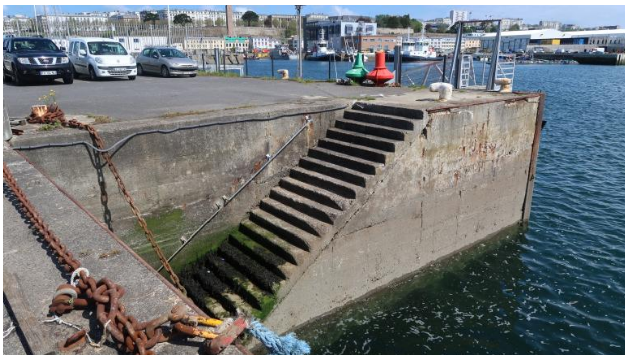
Quai des baliseurs, escaliers
