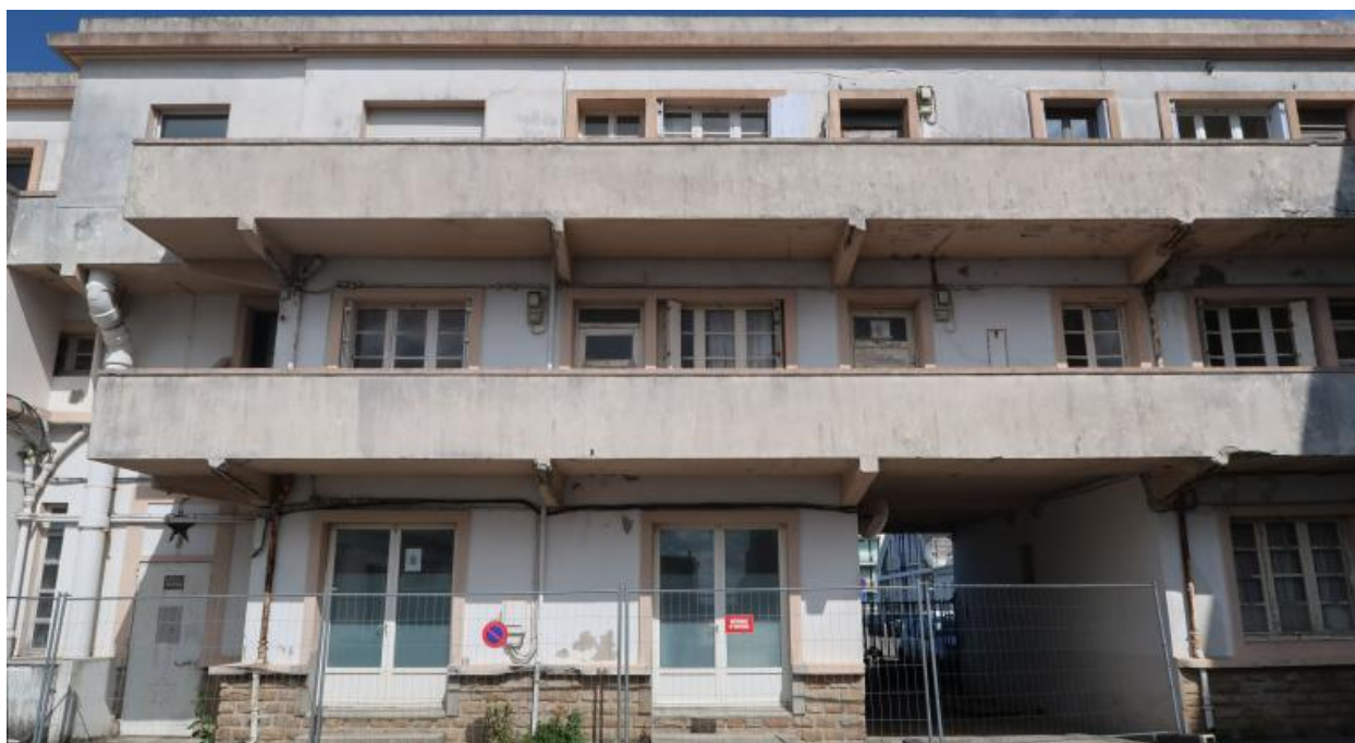
Immeuble à logements (désaffecté)
