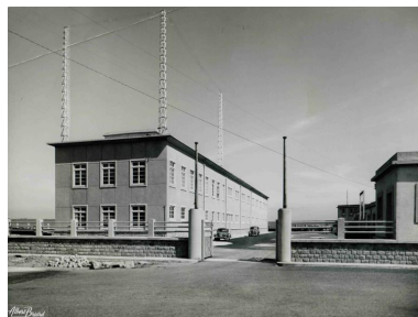
Elévation nord et ouest du nouveau bâtiment des phares et balises. Photographe Albert Briard (1954) Phot. Albert Briard IVR53_20232906085NUCB
