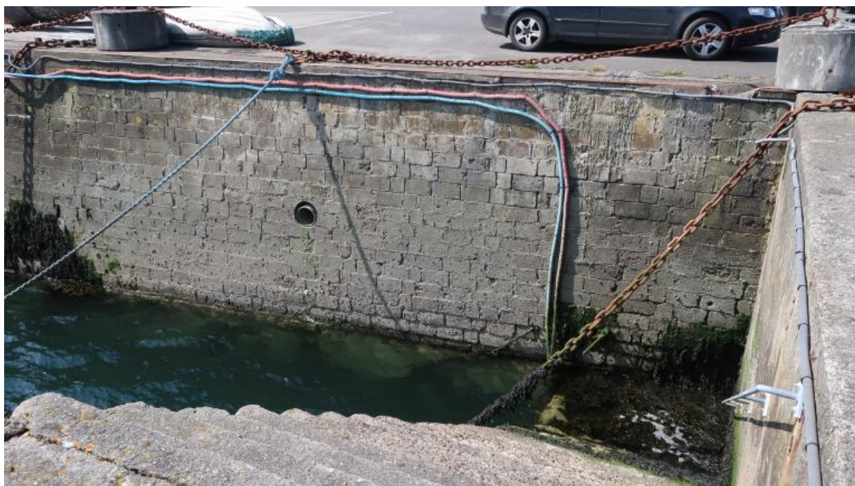
Quai des Baliseurs, escaliers et maçonnerie
