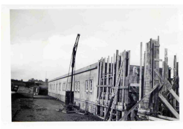
Bâtiment de pilotage en cours de construction (12/1949) Phot. Etat IVR53_20232906072NUCB
