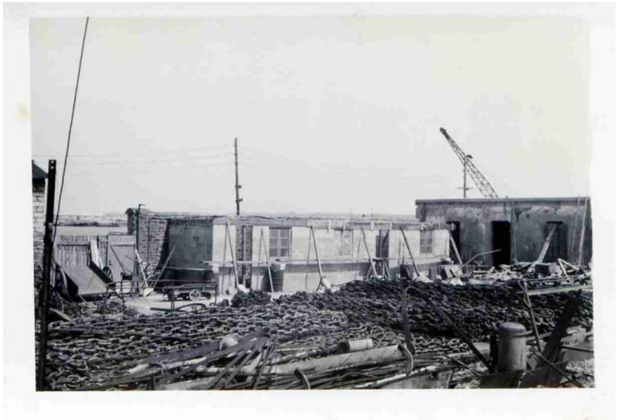
Construction des bureaux et vestiaires provisoires du Parc à balisage (06/1947)
