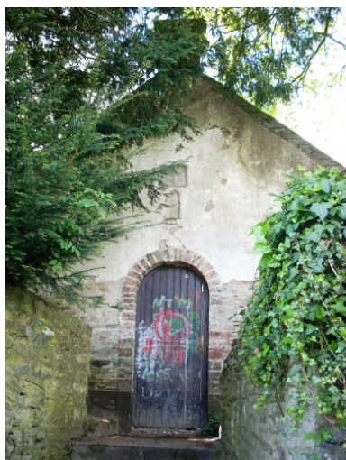
Carhaix, chapelle de la Salette : élévation ouest Phot. Gwénaél Fauchille IVR53_20082905804NUCA
