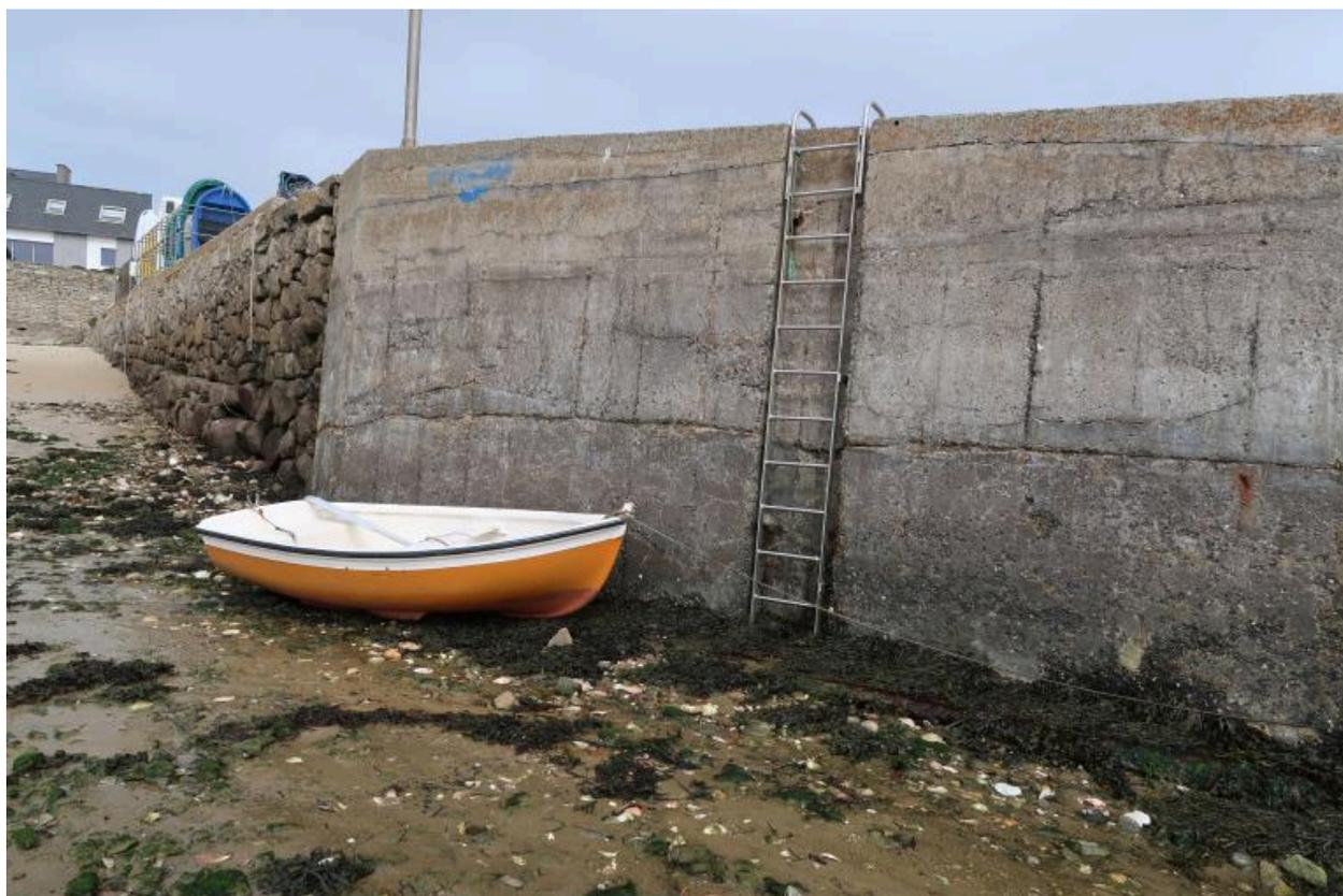
Cale de Porz Kernog, deux périodes de construction aux matériaux différents : maçonnerie, ciment
