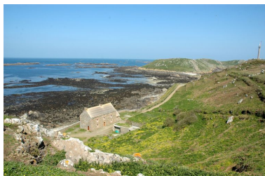
Vue de situation depuis le sud-ouest (état en 2006) Phot. Guillaume Lécueillier IVR53_20062202476NUCA
