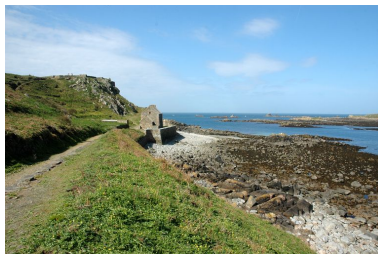
Vue de situation (état en 2006) Phot. Guillaume Lécueillier IVR53_20062210063NUCA
