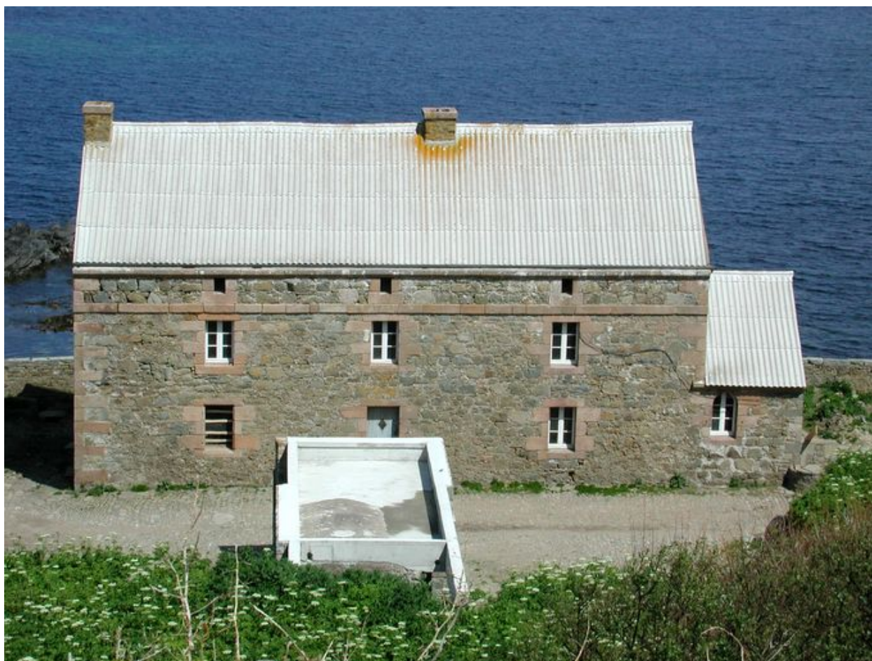
Vue générale depuis le sud (état en 2006)
