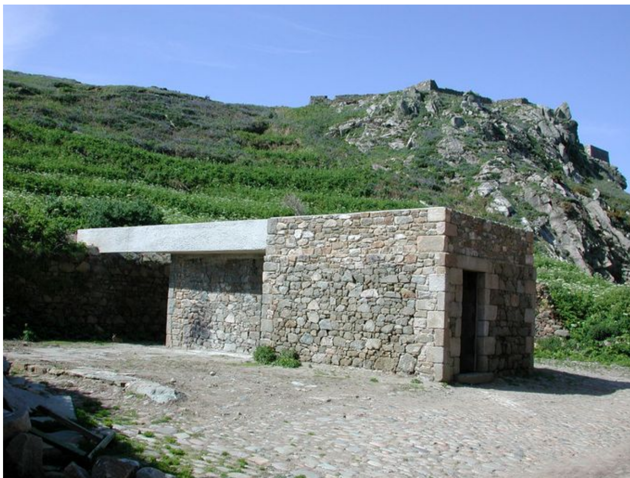
Vue du bâtiment implanté devant la caserne (état en 2002). Il est doté d'un toit plat
