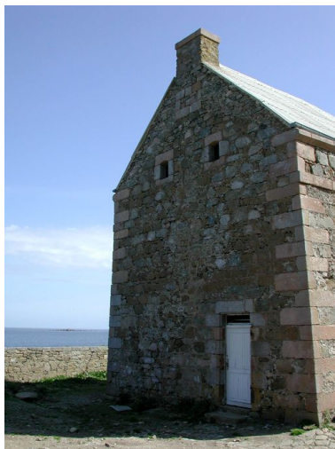
Vue du pignon ouest (état en 2006) Phot. Guillaume Lécueillier IVR53_20022202482NUCA
