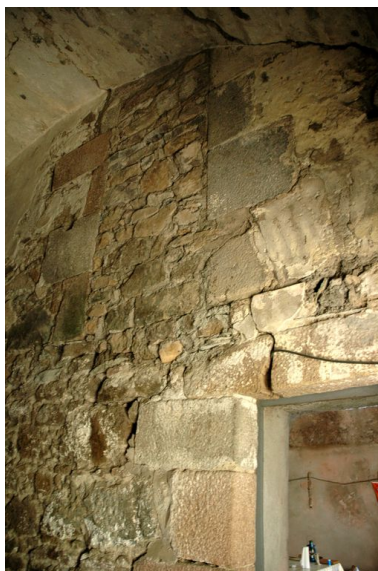
Vue intérieure : palier du premier étage (état en 2006). Cette porte murée desservait à l'origine les combles Phot. Guillaume Lécueillier IVR53_20062210067NUCA
