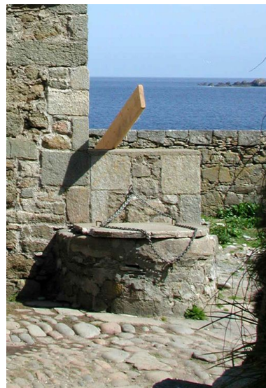
Vue du puits (état en 2002) Phot. Guillaume Lécueillier IVR53_20022202472NUCA
