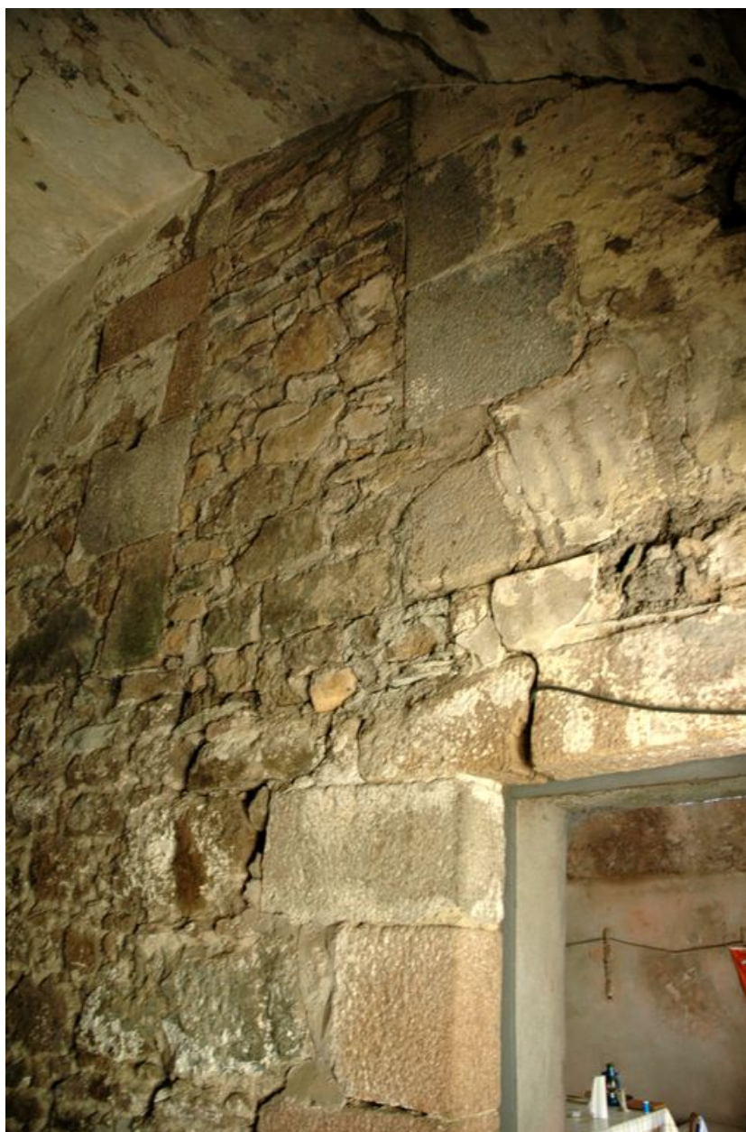
Vue intérieure : palier du premier étage (état en 2006). Cette porte murée desservait à l'origine les combles
