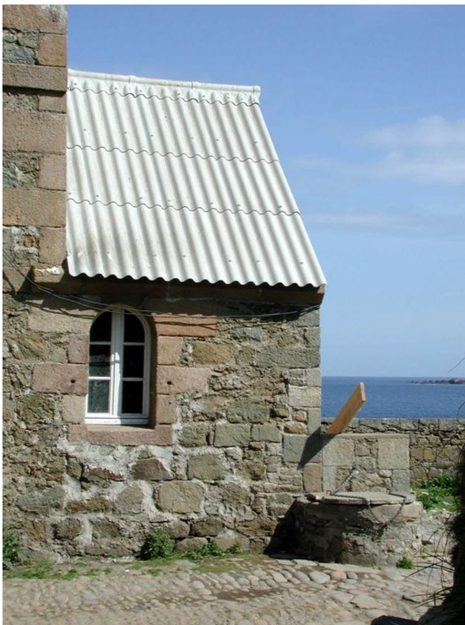
Vue de la chapelle et du puits : élévation sud (état en 2002)
