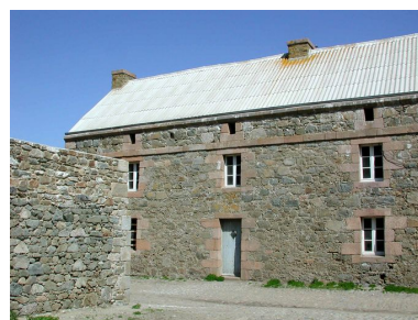
Vue de l'élévation sud (état en 2002) Phot. Guillaume Lécueillier IVR53_20022202486NUCA
