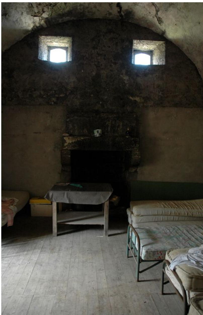
Vue intérieure : premier étage (état en 2006). Le pignon ouest est dotée d'une cheminée
