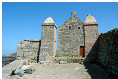
Vue du pignon ouest (état en 2006). Au premier plan, la porte commandant l'accès à la cale Phot. Guillaume Lécueillier IVR53_20062210061NUCA
