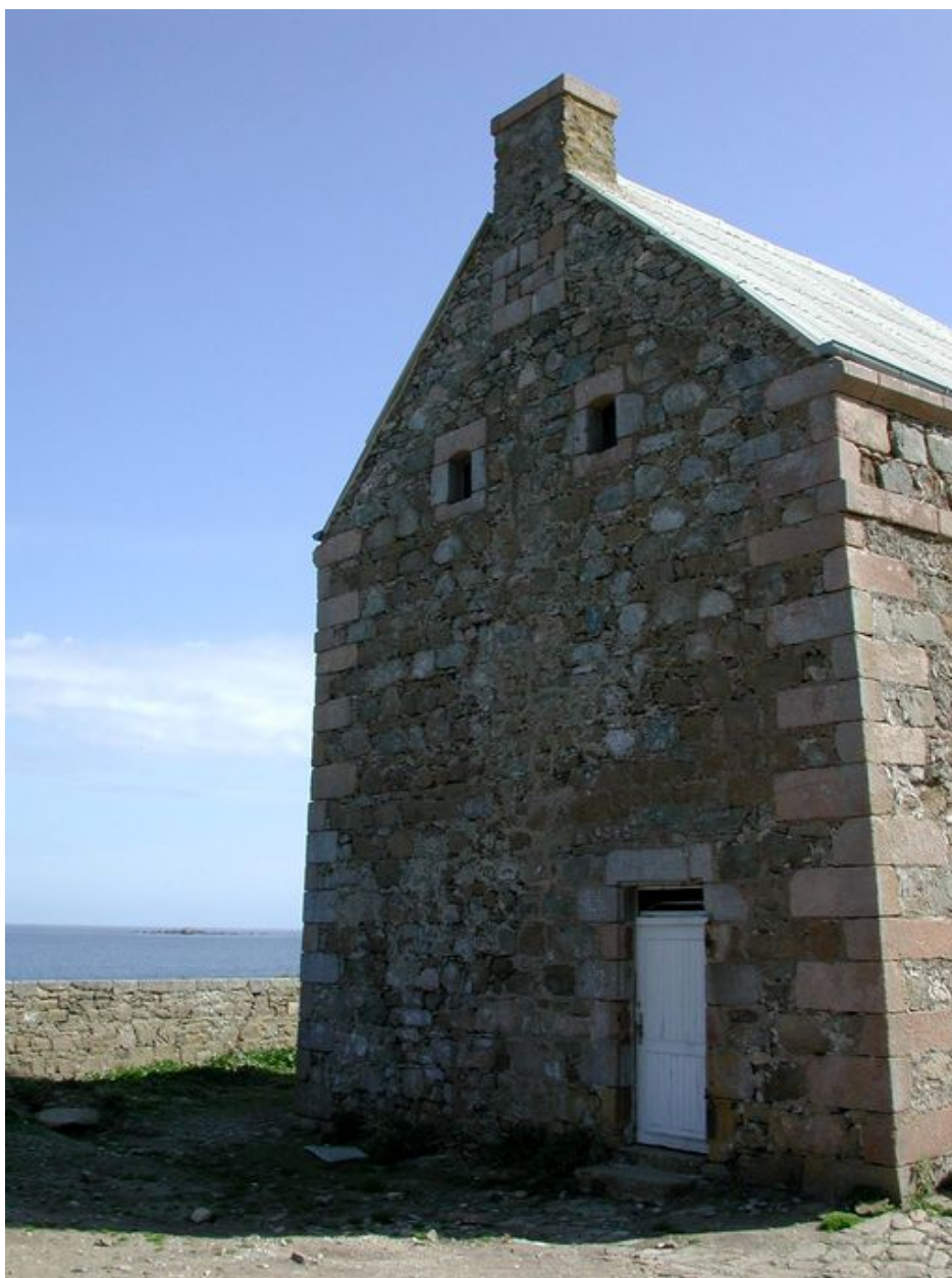
Vue du pignon ouest (état en 2006)
