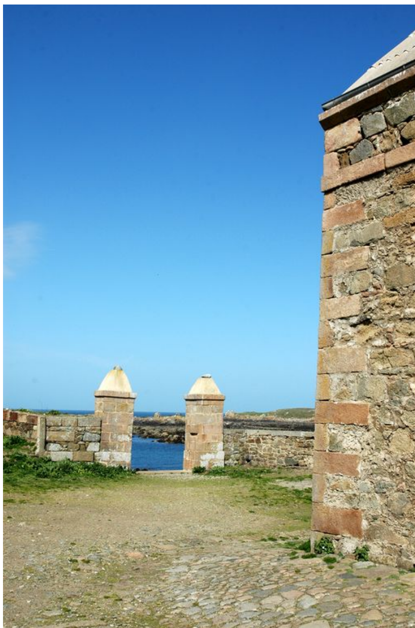
Vue de situation de la porte commandant l'accès à la cale (état en 2006). A droite, la caserne
