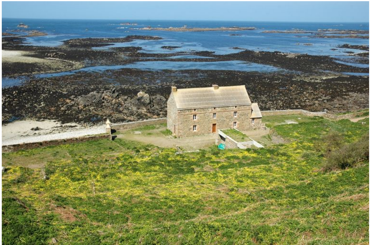
Vue générale depuis le chemin de ronde central au sud (état en 2006)
