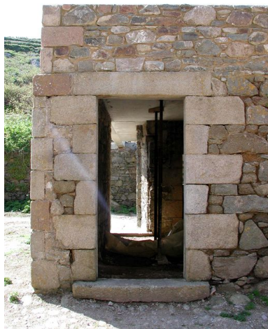
Vue du bâtiment implanté devant la caserne : porte nord (état en 2002). Il est doté d'un toit plat Phot. Guillaume Lécueillier IVR53_20022202475NUCA
