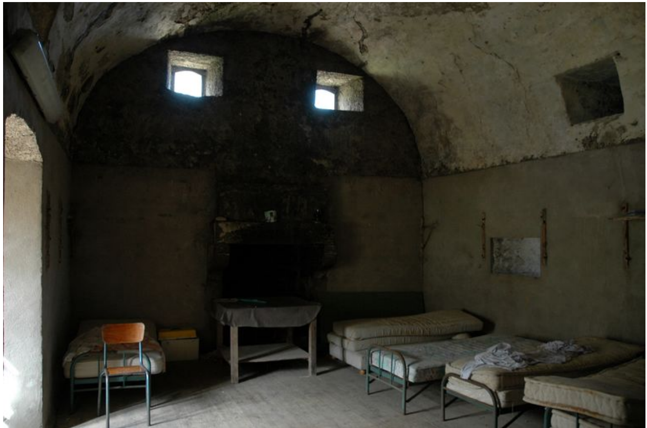
Vue intérieure : premier étage (état en 2006). Le pignon ouest est dotée d'une cheminée
