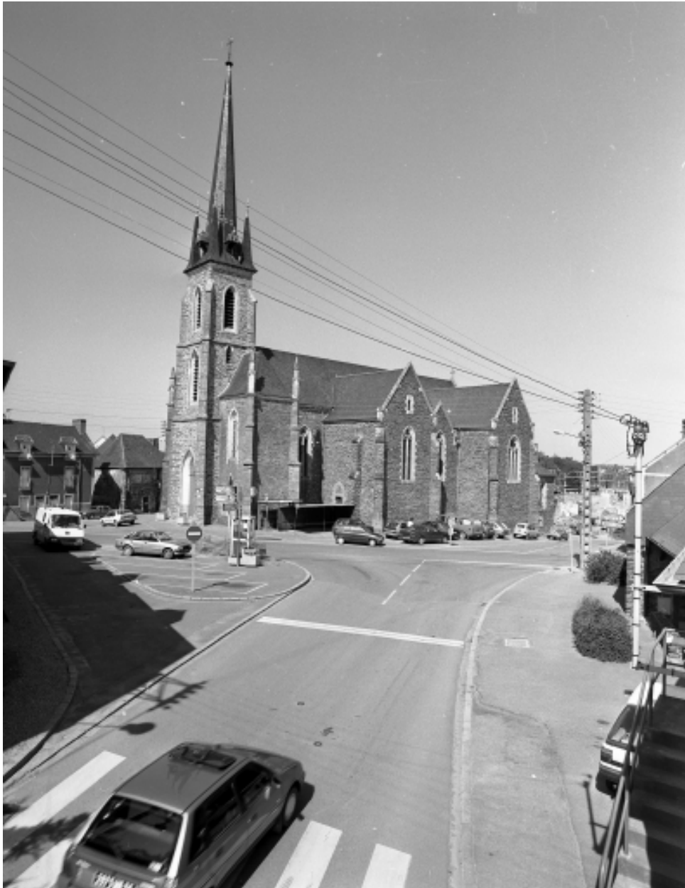
Elévation sud ouest : vue générale
