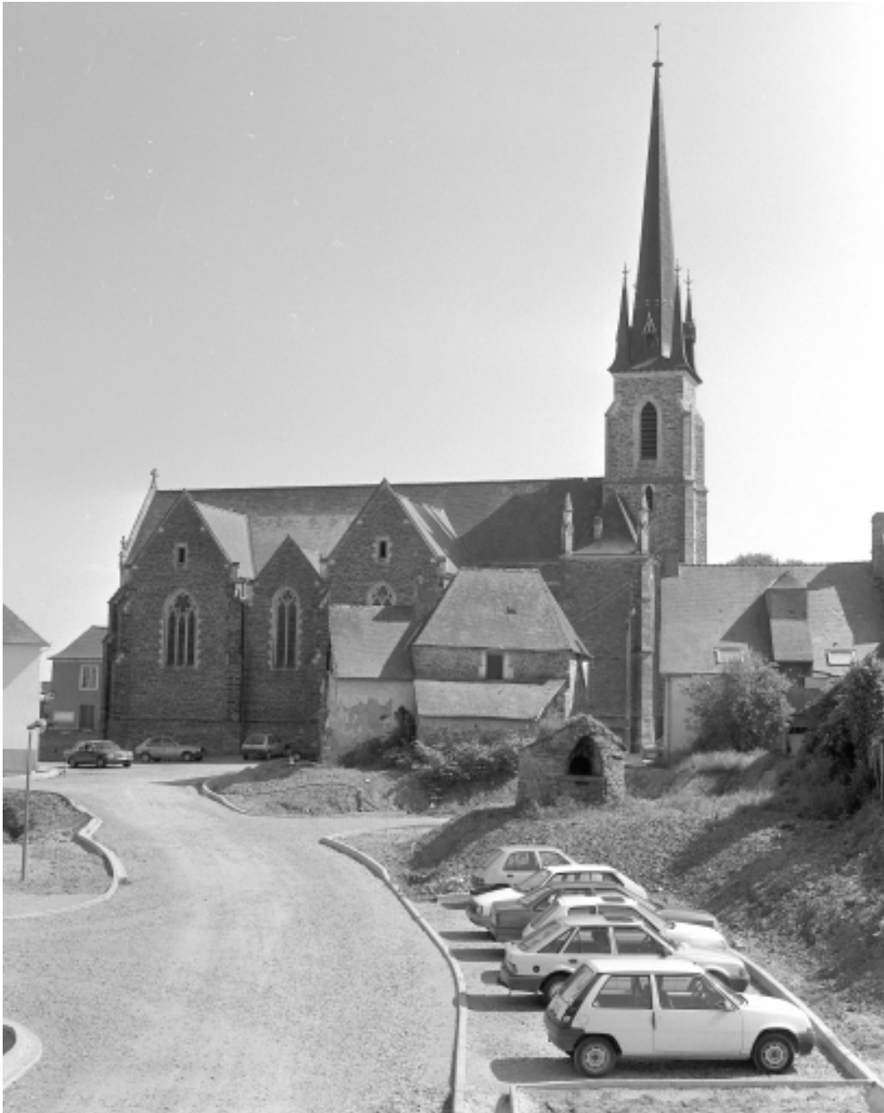
Elévation nord : vue générale
