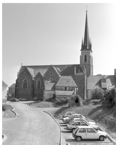
Elévation nord : vue générale Phot. Guy Artur, Phot. Norbert Lambart IVR53_19943500944X
