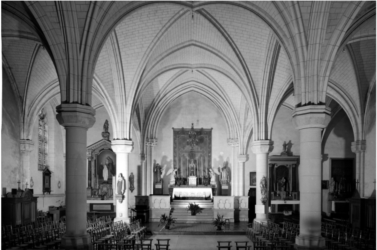
Intérieur : vue générale vers le chœur
