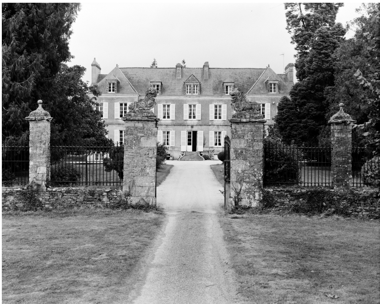
Vue de situation sud avec portail.
