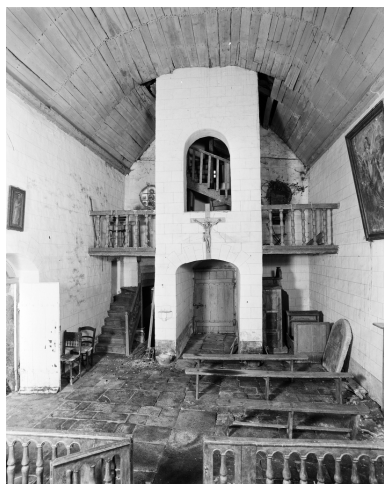
Chapelle, vue générale vers la nef et la tribune. Phot. Bernard Bègne IVR53_19985600638X
