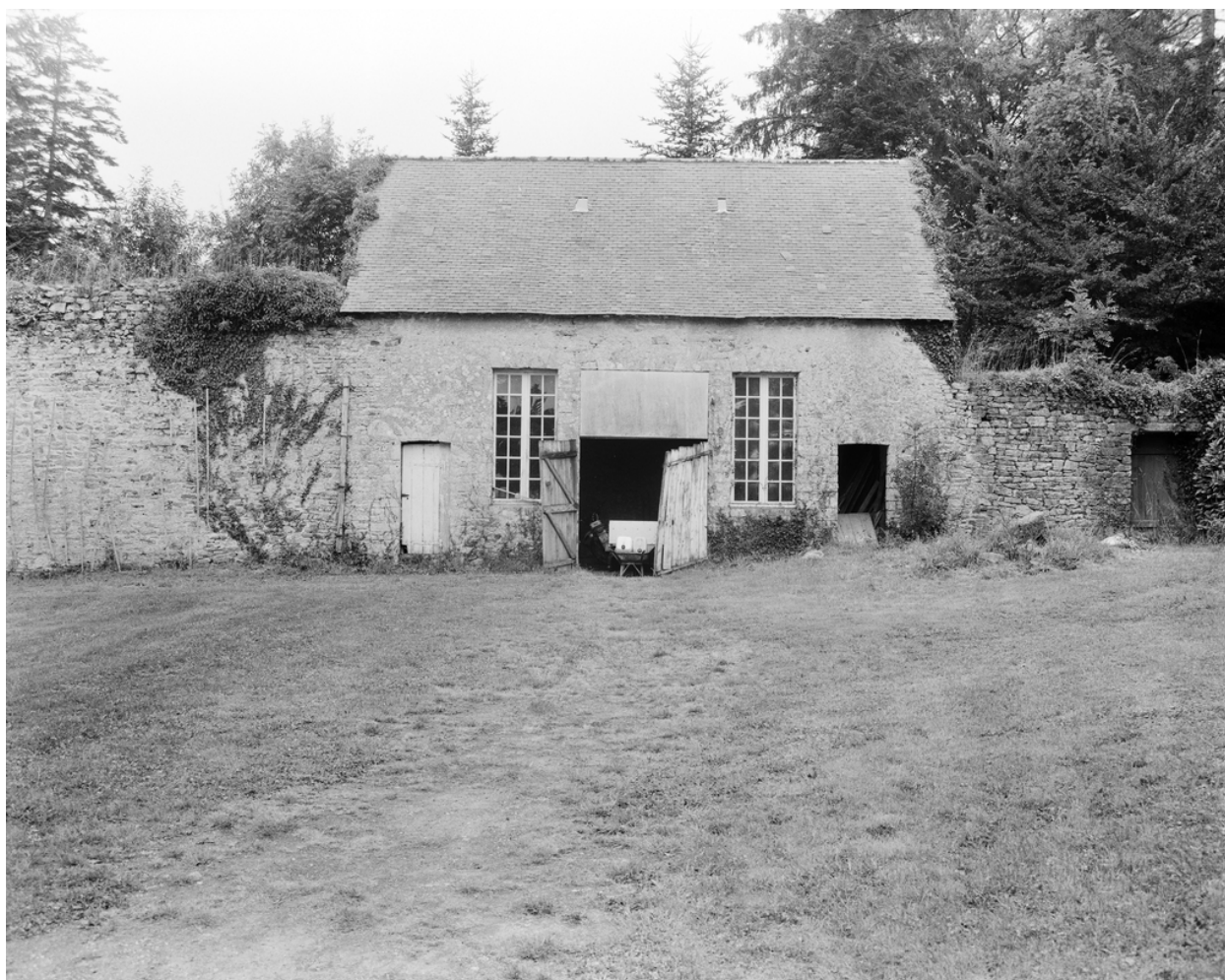
Orangerie, vue générale.
