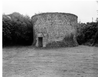
Pigeonnier, vue générale. Phot. Bernard Bègne IVR53_19985600632X
