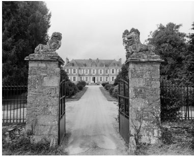
Vue de situation sud avec portail. Phot. Bernard Bègne IVR53_19985600657X
