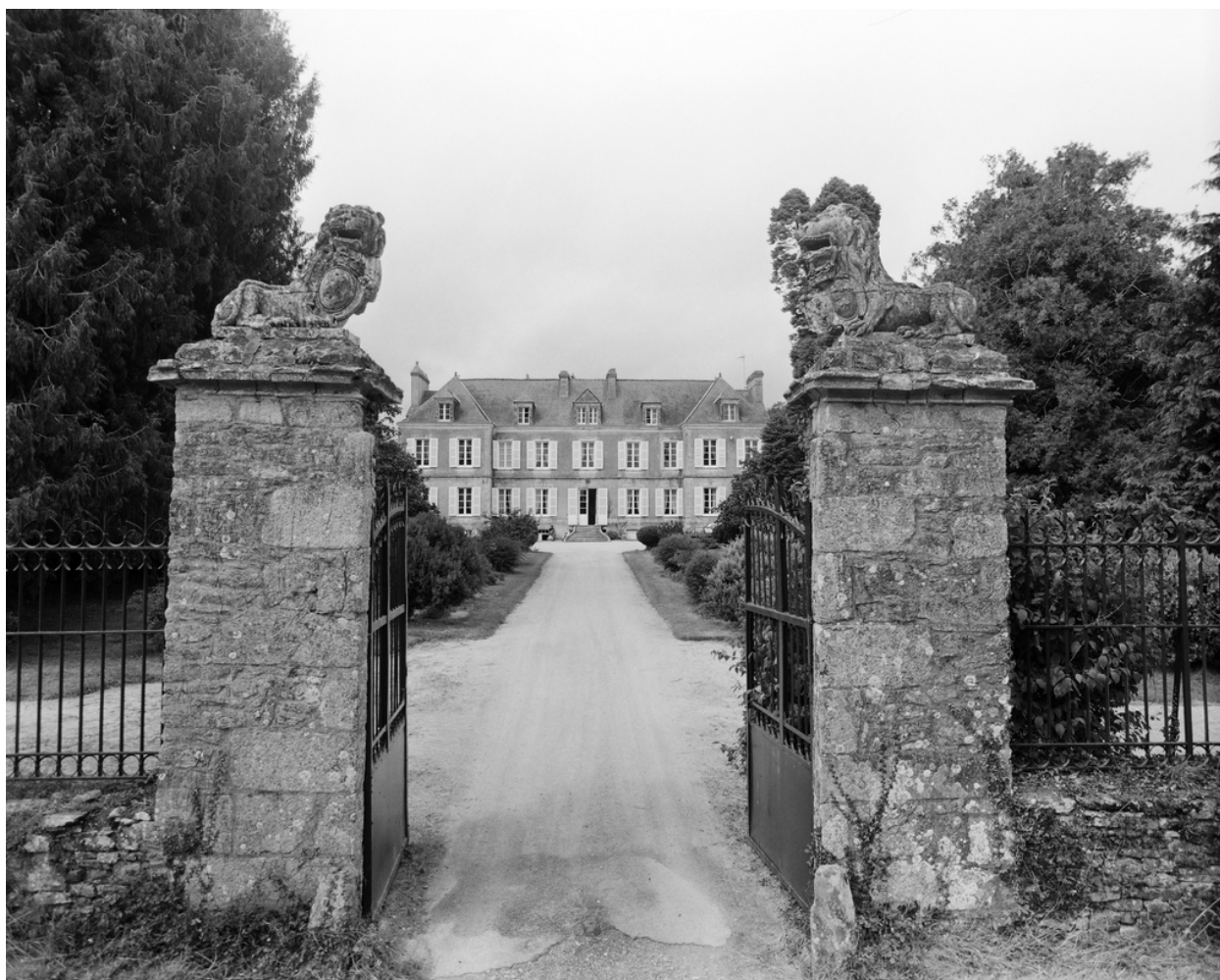
Vue de situation sud avec portail.
