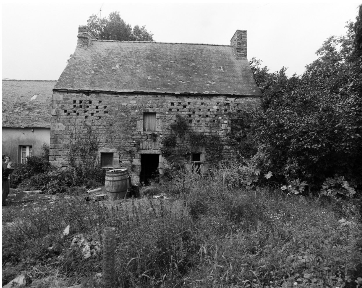
Ancienne métairie, vue générale.
