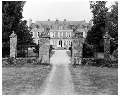
Vue de situation sud avec portail. Phot. Bernard Bègne IVR53_19985600658X
