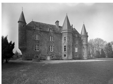
Manoir : élévation est (état en 1985) Phot. Norbert Lambart IVR53_19855600797V
