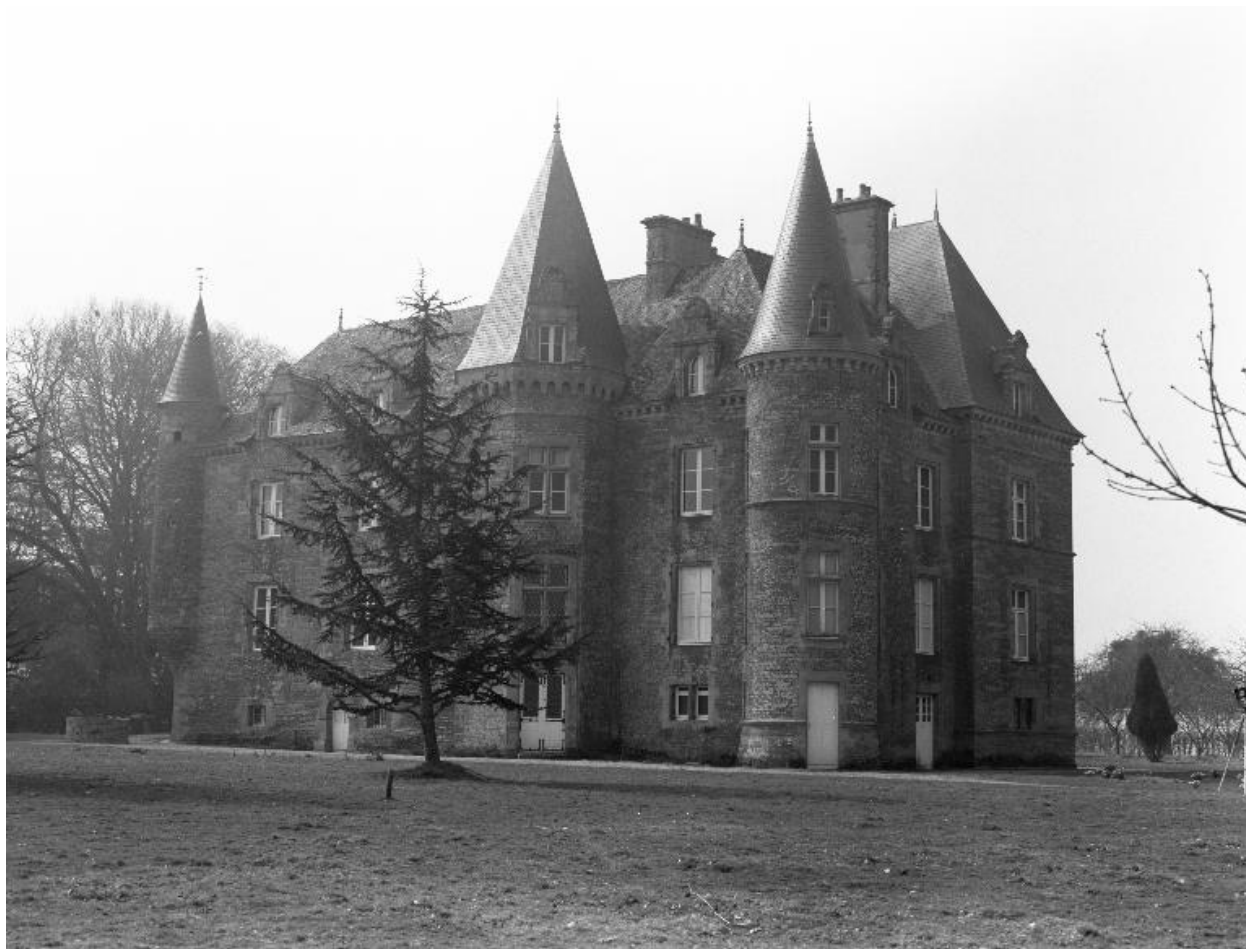
Manoir : vue générale nord-est (état en 1984)
