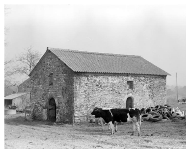
Manoir, chapelle : vue générale sud-ouest (état en 1984) Phot. Guy Artur, Phot. Norbert Lambart IVR53_19845600517X
