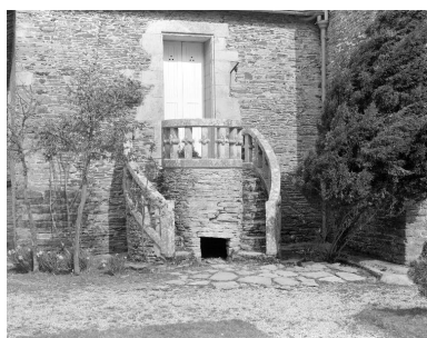
Manoir, élévation sud : l'escalier (état en 1984) Phot. Guy Artur, Phot. Norbert Lambart IVR53_19845600515X
