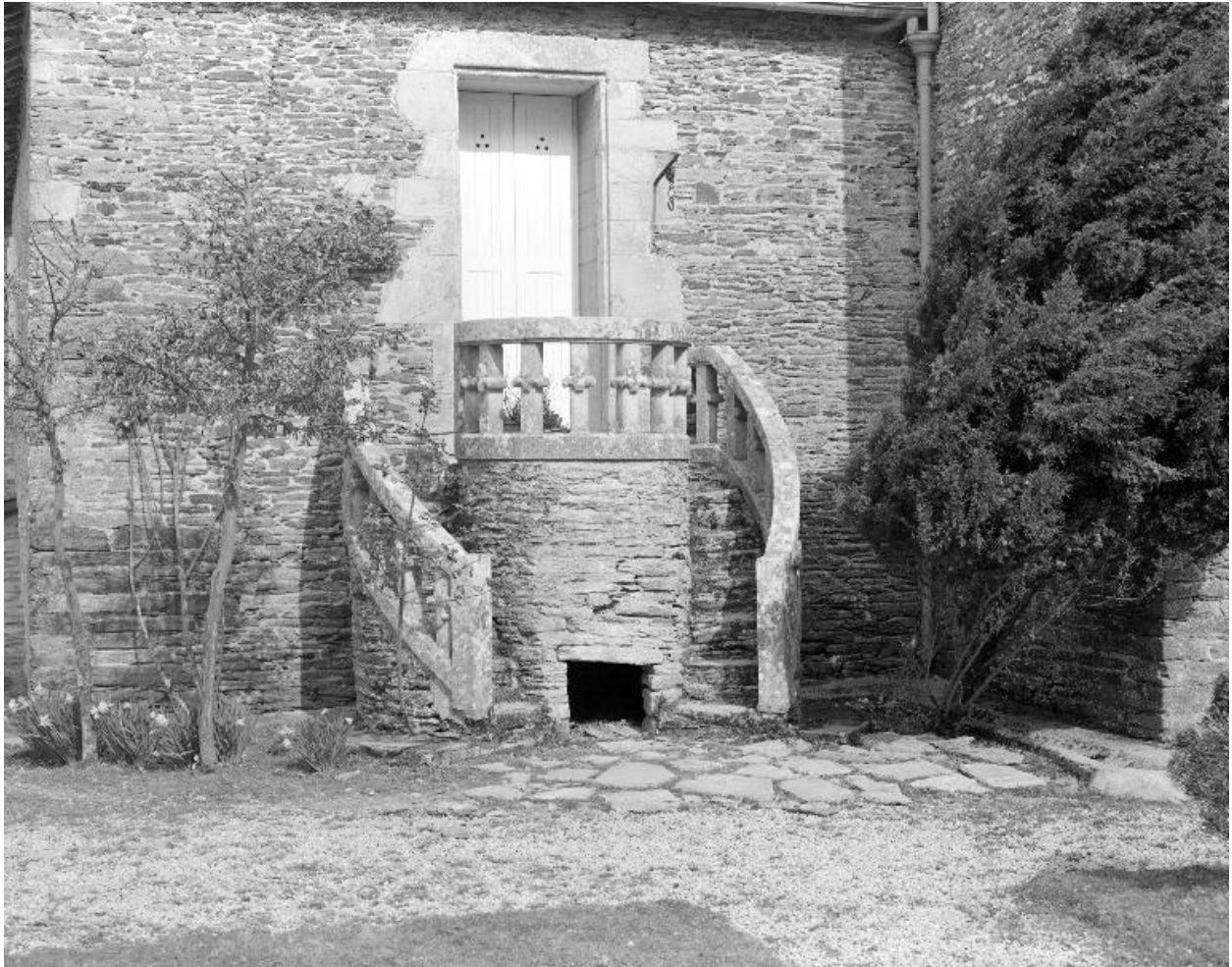
Manoir, élévation sud : l'escalier (état en 1984)
