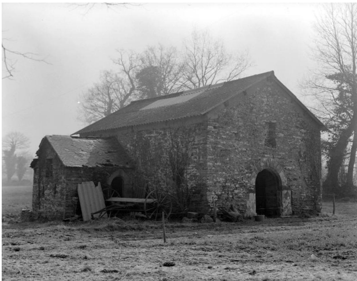
Manoir, chapelle : vue générale nord-ouest (état en 1984)
