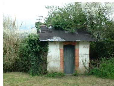
Dépendance de l'ancienne caserne des douaniers des Quatre-Vents Phot. Julien Amghar IVR53_20065606603NUCA
