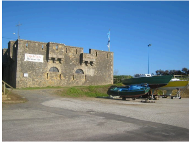
Vue générale du corps de garde Phot. Françoise Péron IVR53_20072908932NUCA
