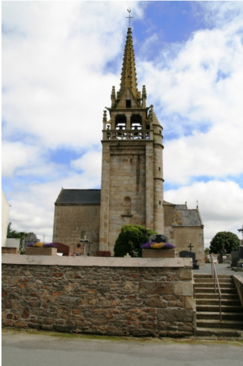
Plouégat-Moysan, église paroissiale Saint-Pierre : élévation ouest
