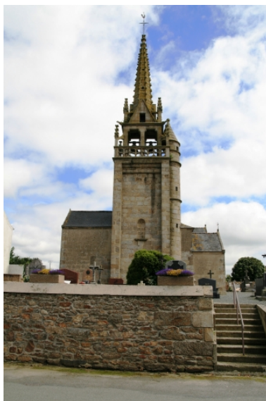
Plouégat-Moysan, église paroissiale Saint-Pierre : élévation ouest Phot. Gwénaél Fauchille IVR53_20082906685NUCA
