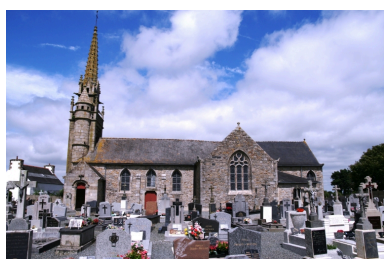
Plouégat-Moysan, église paroissiale Saint-Pierre : élévation sud Phot. Gwénaél Fauchille IVR53_20082906687NUCA
